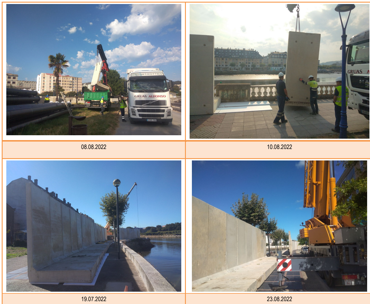
Figura 10 Seguimiento de implantación de barrera acústica.
