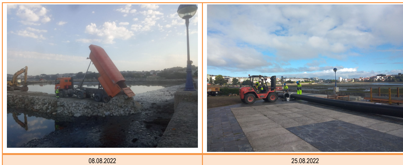
Figura 2 Cubrición de camiones y maquinaria de obra
