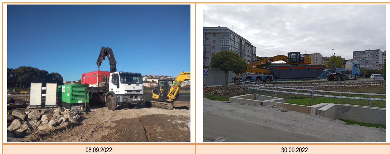
Figura 2 Nuevos equipos en obra
