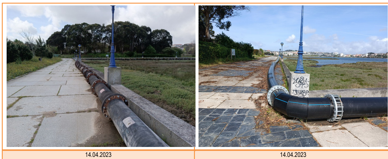
Figura 9 Instalación de impulsión
