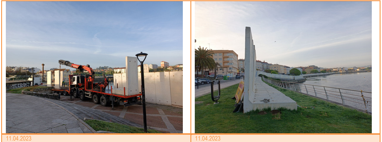
Figura 2 Implantación de barreras acústicas. Mes de abril de 2023.
