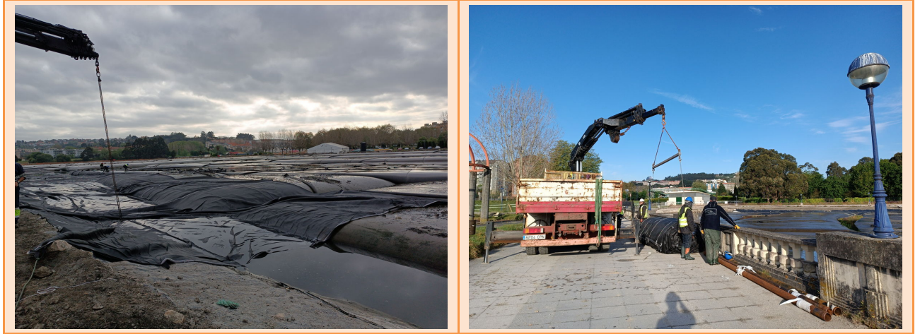
Figura 5 Llenado de geotubos
