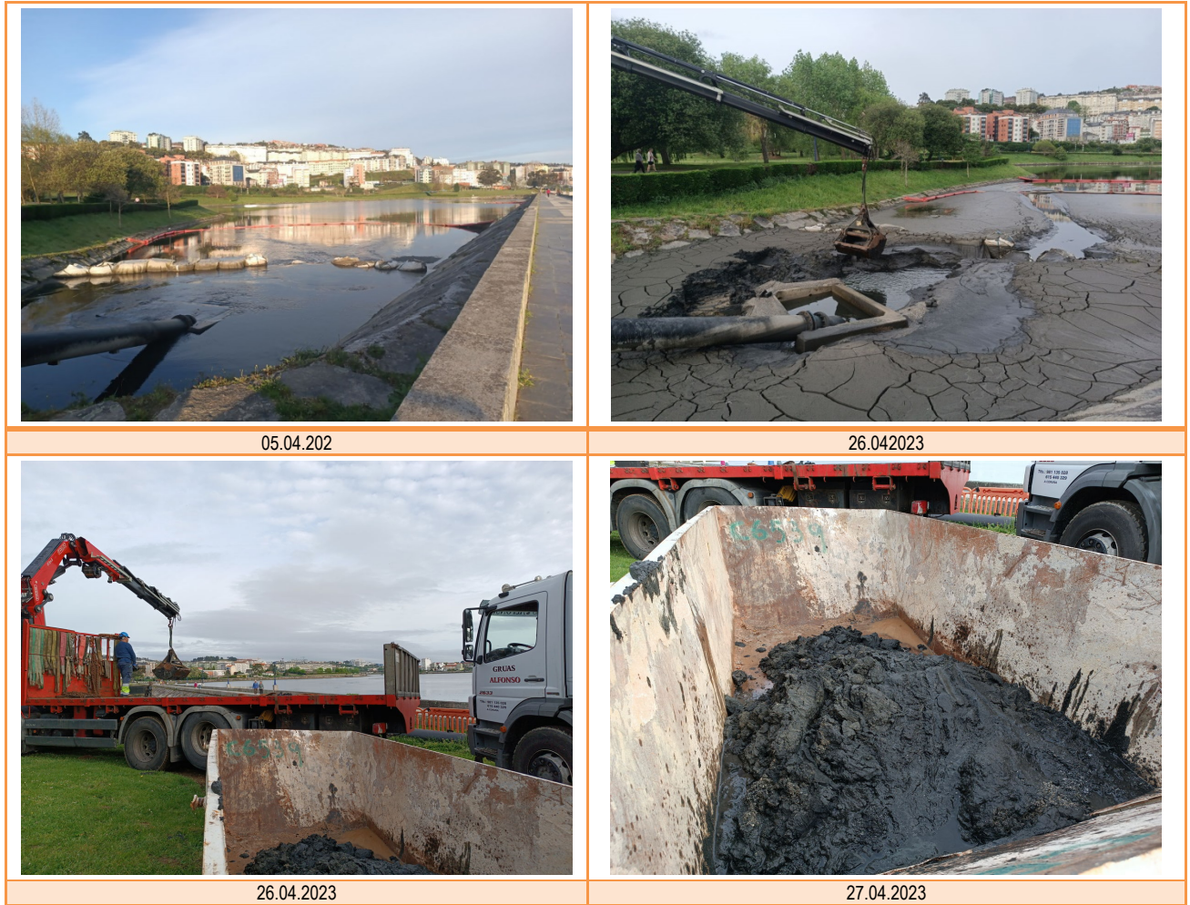
Figura 10 Retirada de fangos acumulados en la laguna de Fonteculler.
