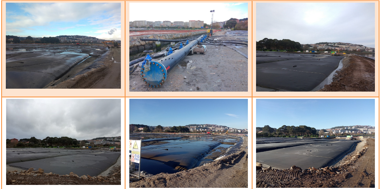
Figura 4 Llenado de geotubos
