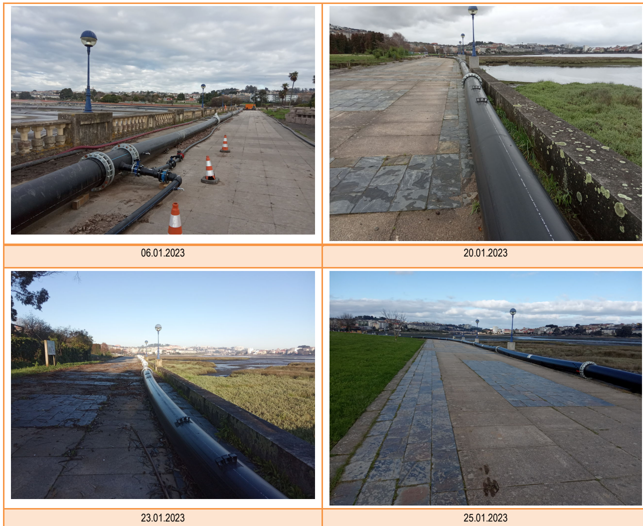
Figura 7 Instalación de impulsión
