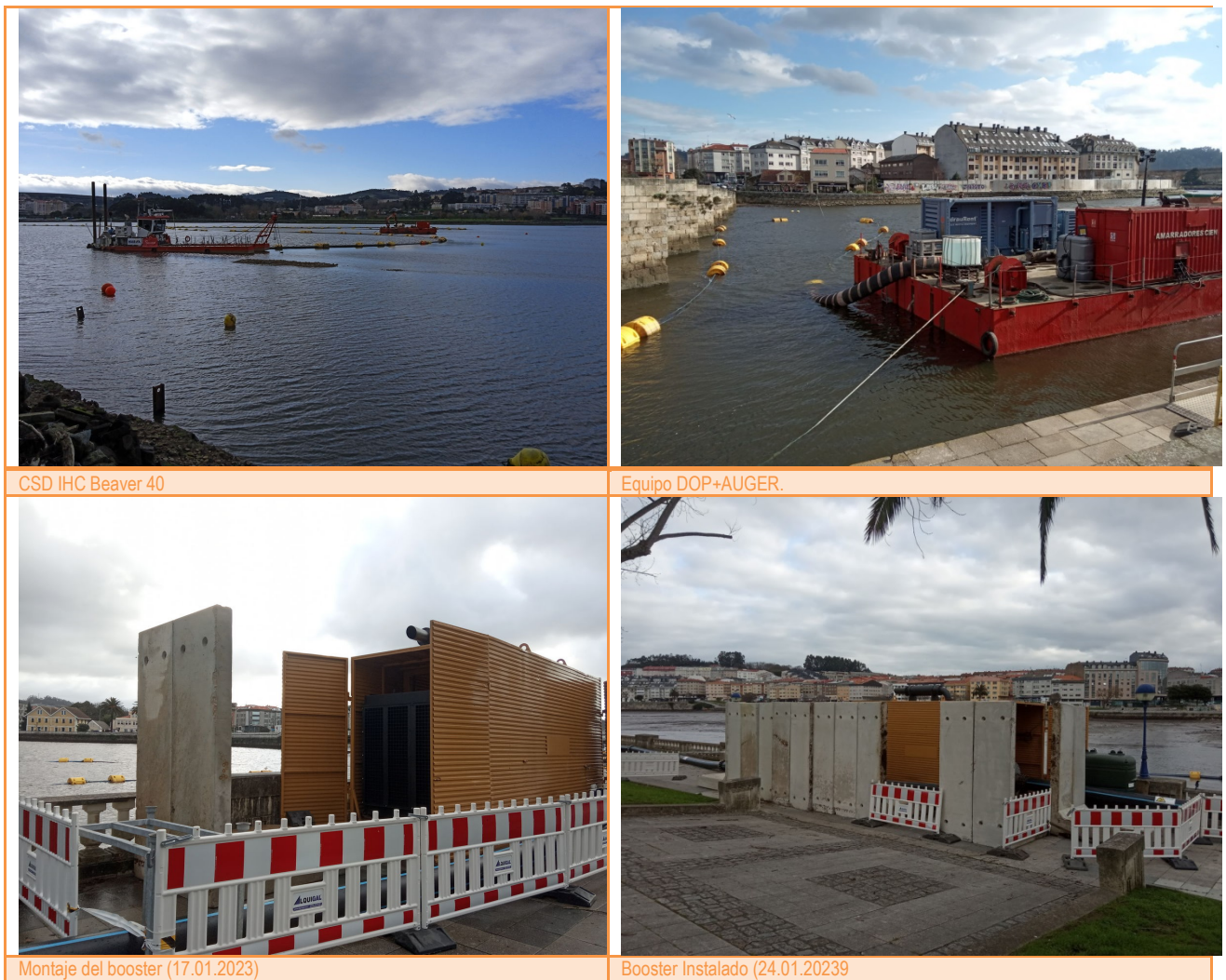
Figura 2 Equipos de dragado y otros medios. Mes de enero de 2023.
