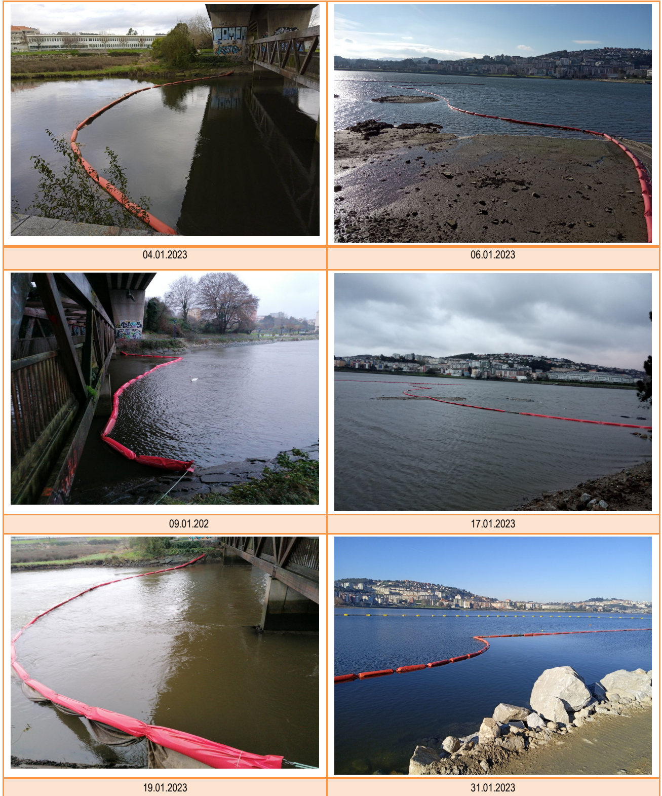
Figura 6 Seguimiento de la barrera antiturbidez.
