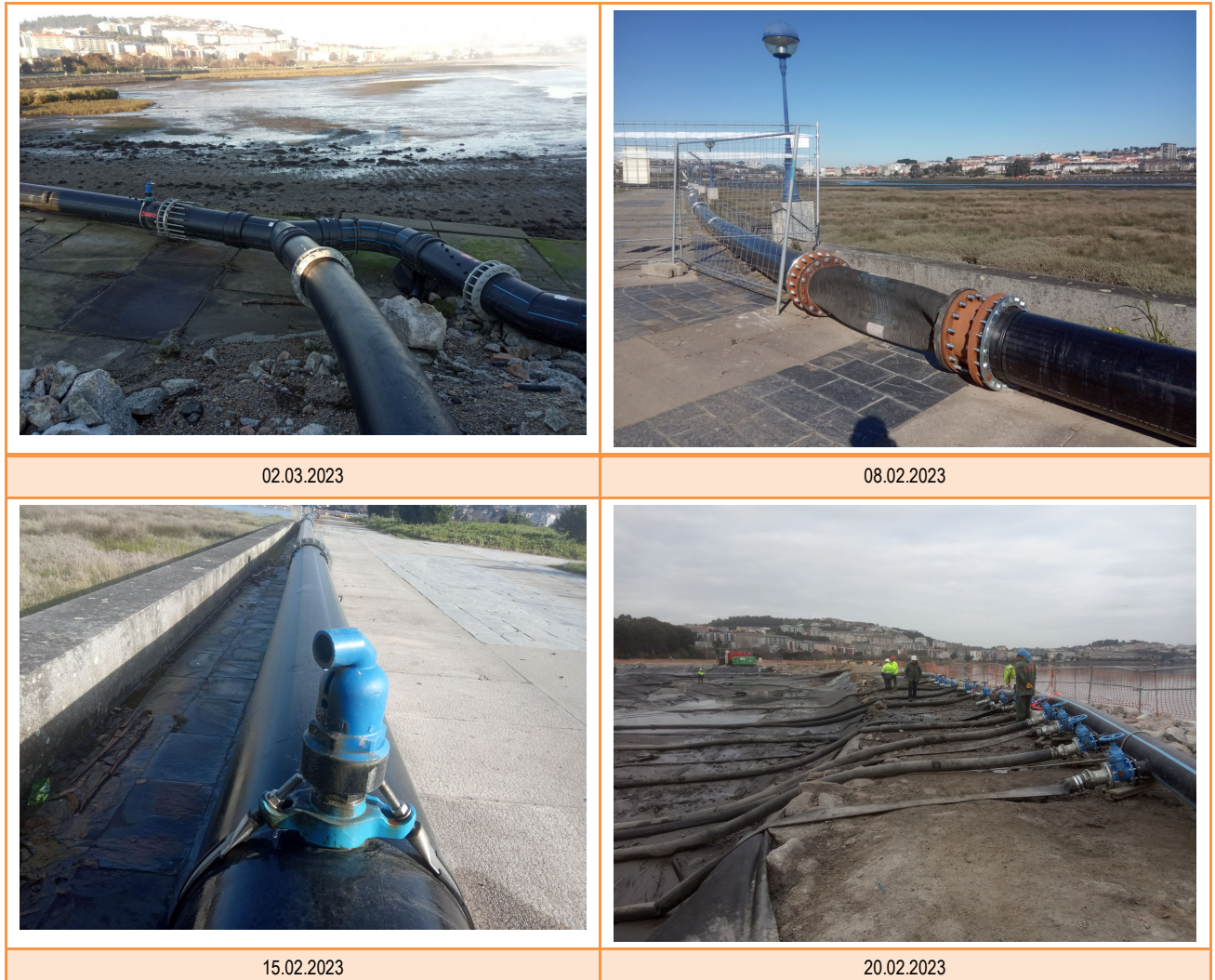
Figura 8 Instalación de impulsión
