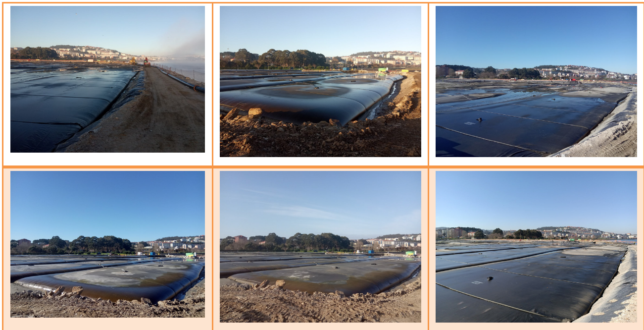
Figura 5 Llenado de geotubos
