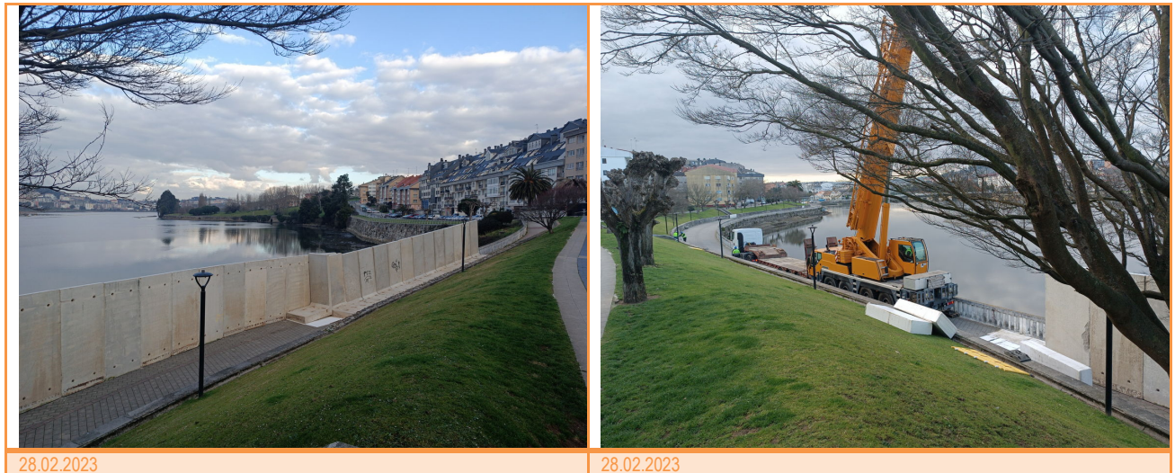
Figura 2 Implantación de barreras acústicas. Mes de Febrero de 2023.
