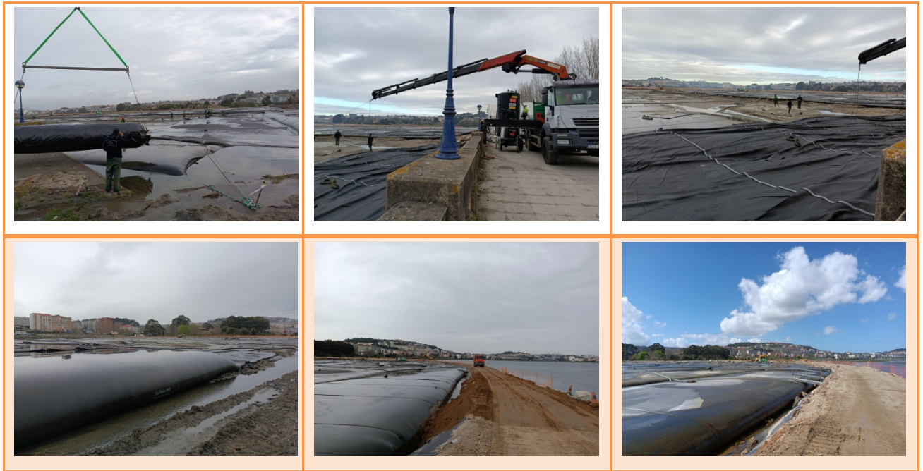
Figura 5 Llenado de geotubos
