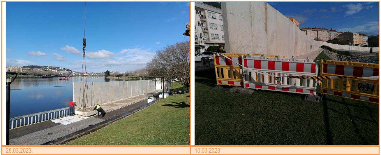
Figura 2 Implantación de barreras acústicas. Mes de marzo de 2023.
