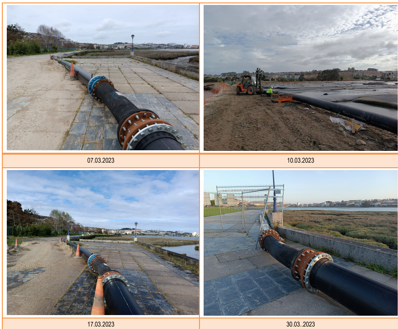
Figura 8 Instalación de impulsión
