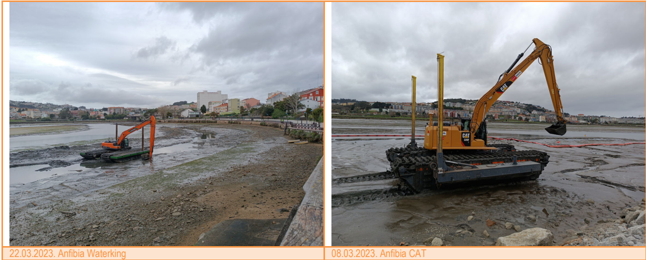
Figura 3 Equipos de dragado. Mes de marzo de 2023.
