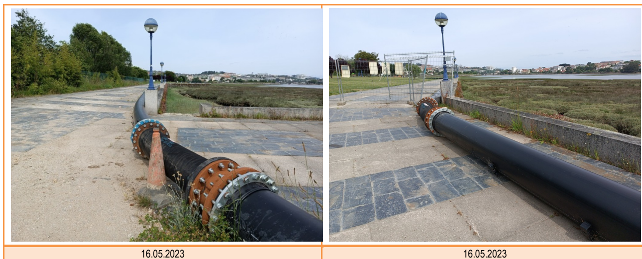
Figura 8 Instalación de impulsión
