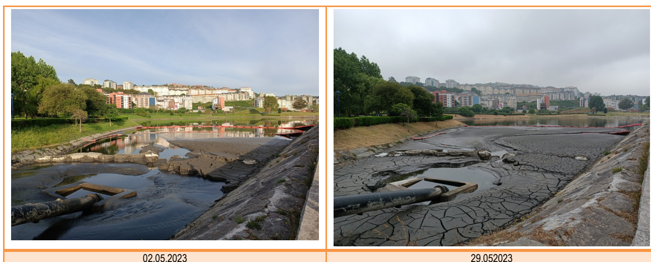
Figura 9 Decantación de fangos acumulados en la laguna de Fonteculler.
