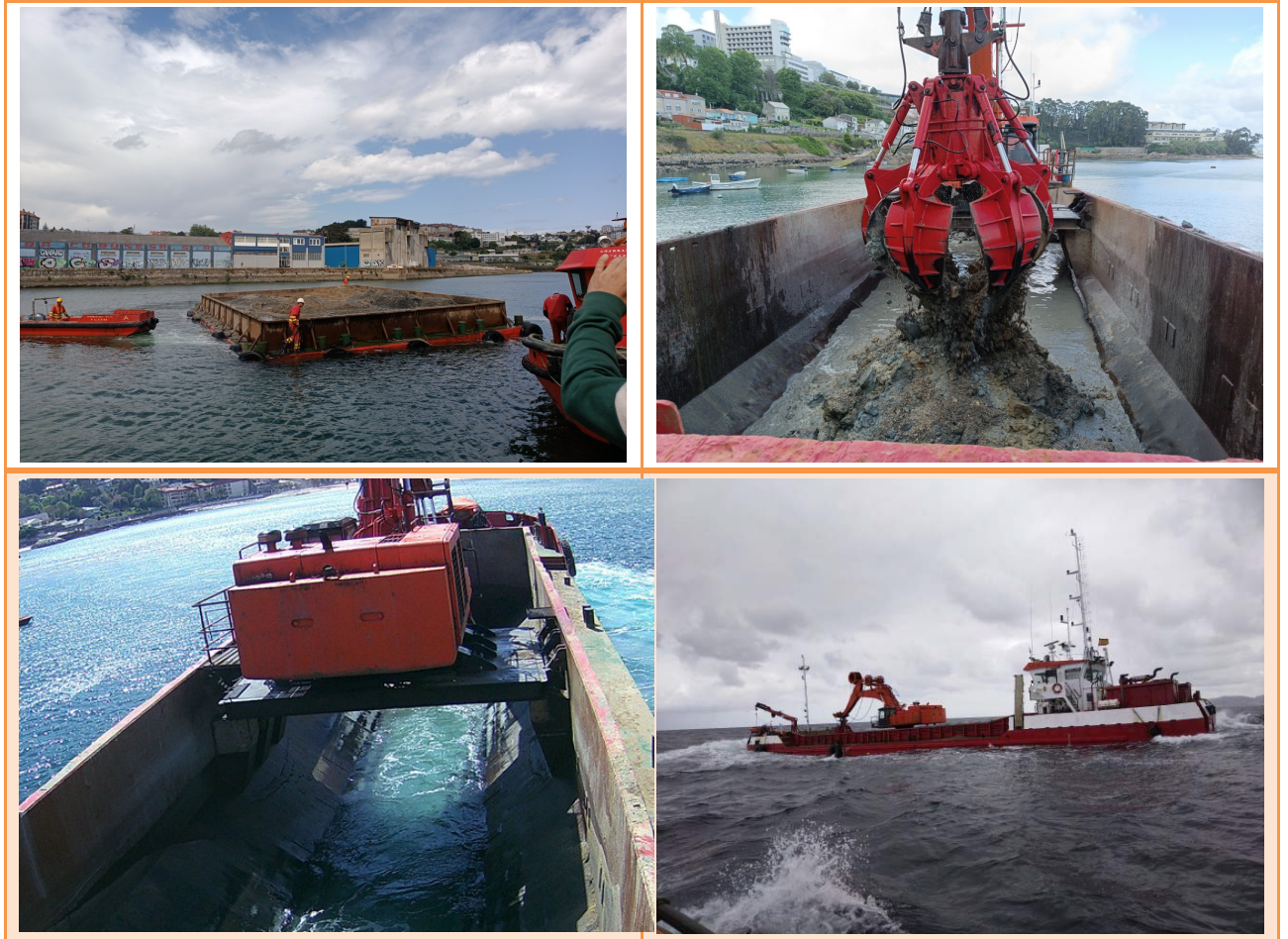
Figura 5 Dragado de canal y vertido.
