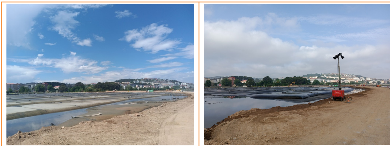
Figura 4 Llenado de geotubos
