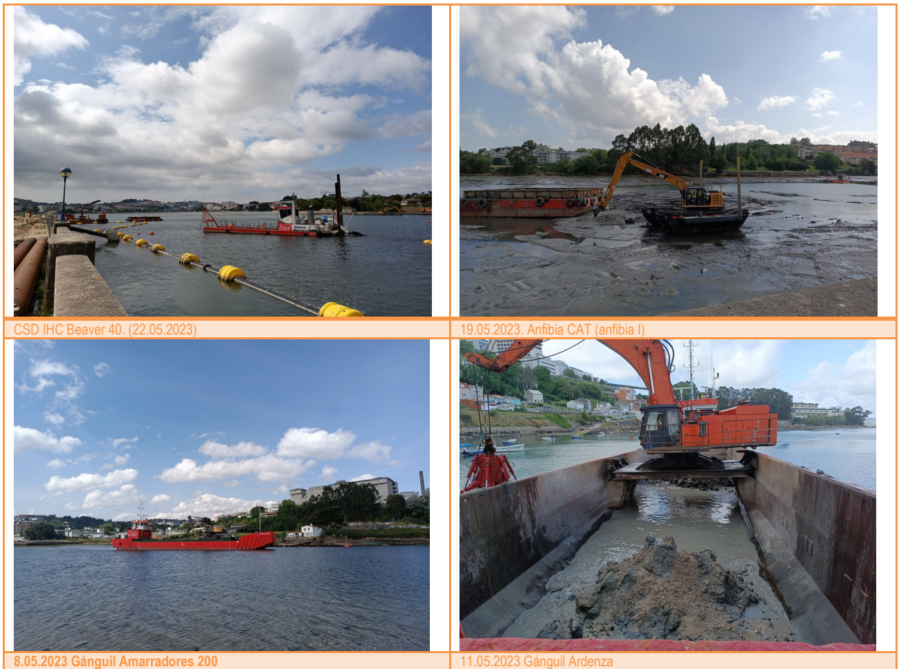
Figura 2 Equipos de dragado. Mes de mayo de 2023.
