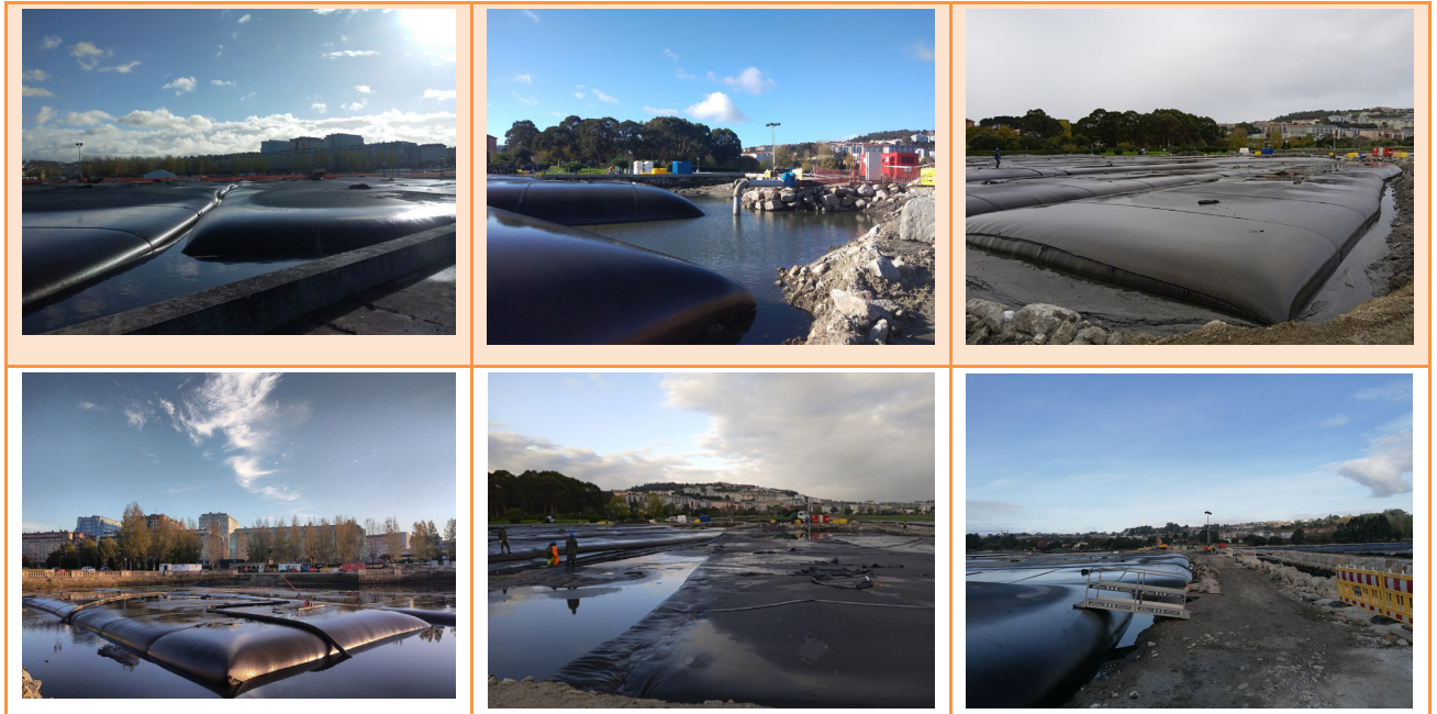
Figura 4 Llenado de geotubos
