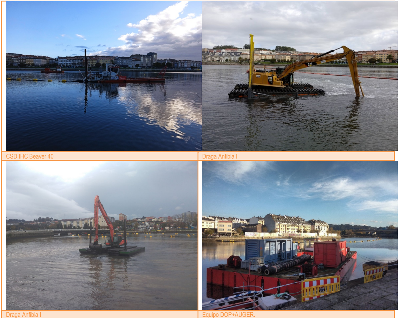
Figura 2 Equipos de dragado. Mes de noviembre de 2022.
