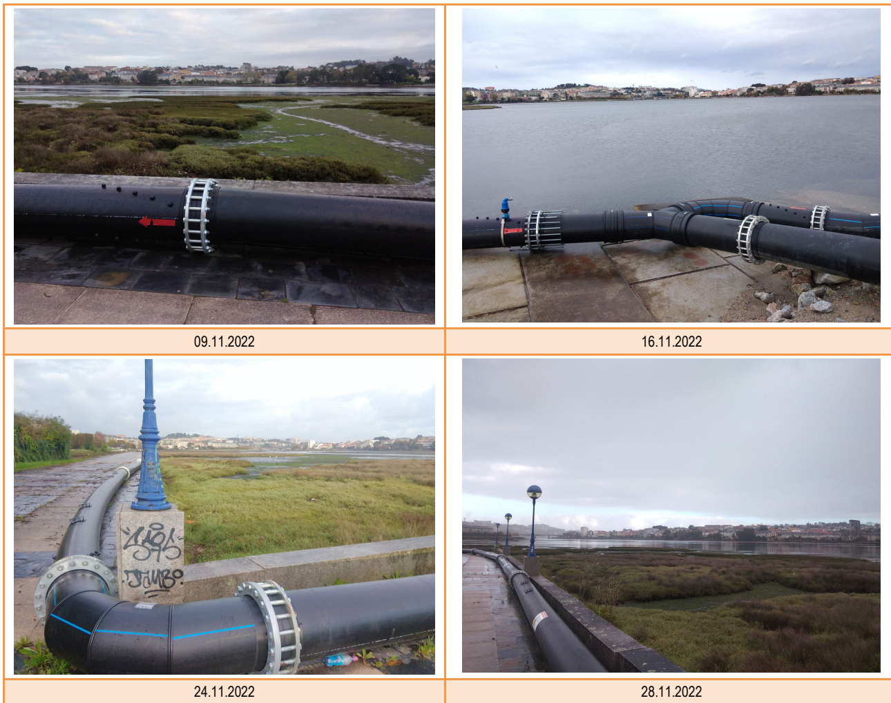
Figura 7 Instalación de impulsión
