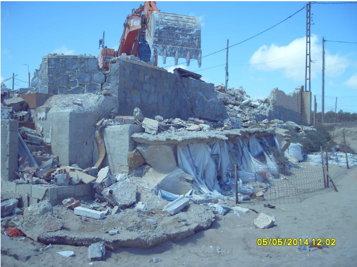
Fotos durante la obra:
