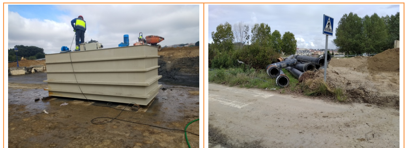
Figura 8 Desmontaje de instalación de floculante y conducción de impulsión.
