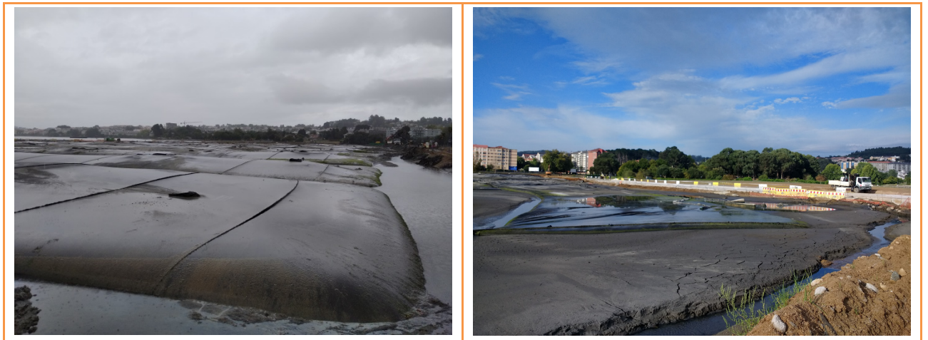
Figura 4 Llenado de geotubos
