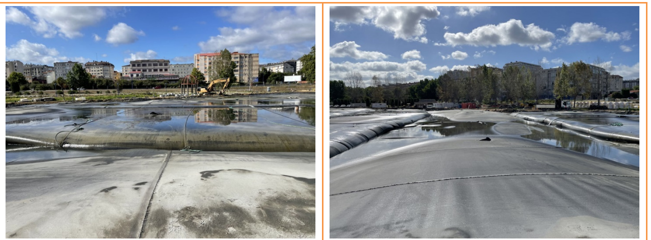
Figura 5 Llenado de geotubos
