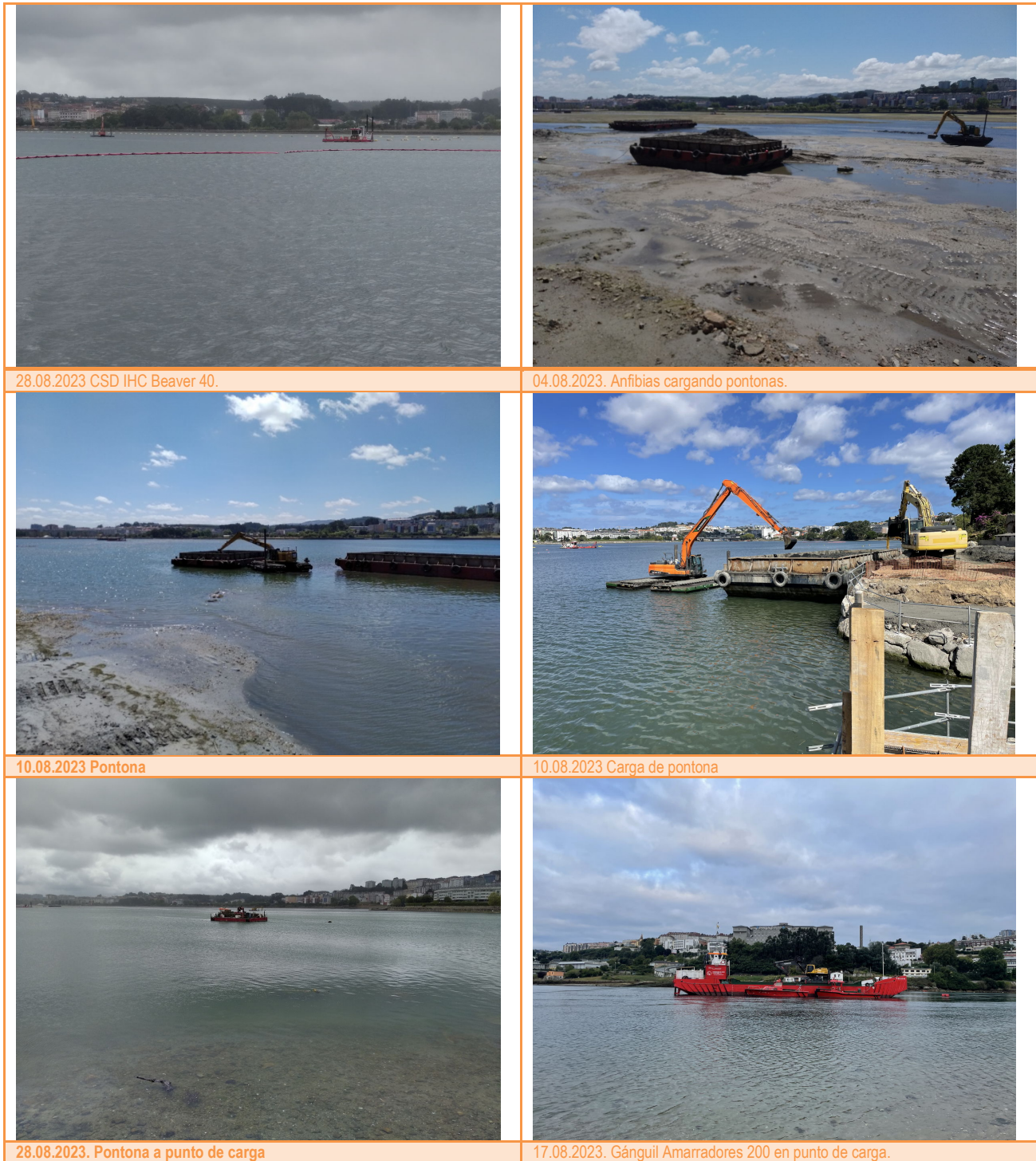
Figura 3 Equipos de dragado. Mes de agosto de 2023.
