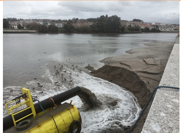
11/12/2023 Bombeo de material de restitución al sector VI
