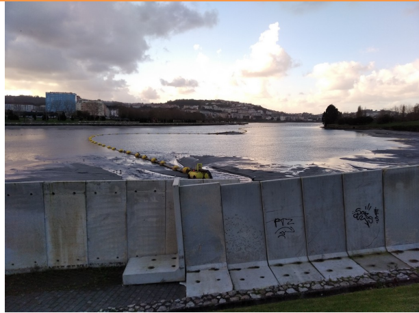
04/12/2023 Bombeo de material de restitución al sector IV
