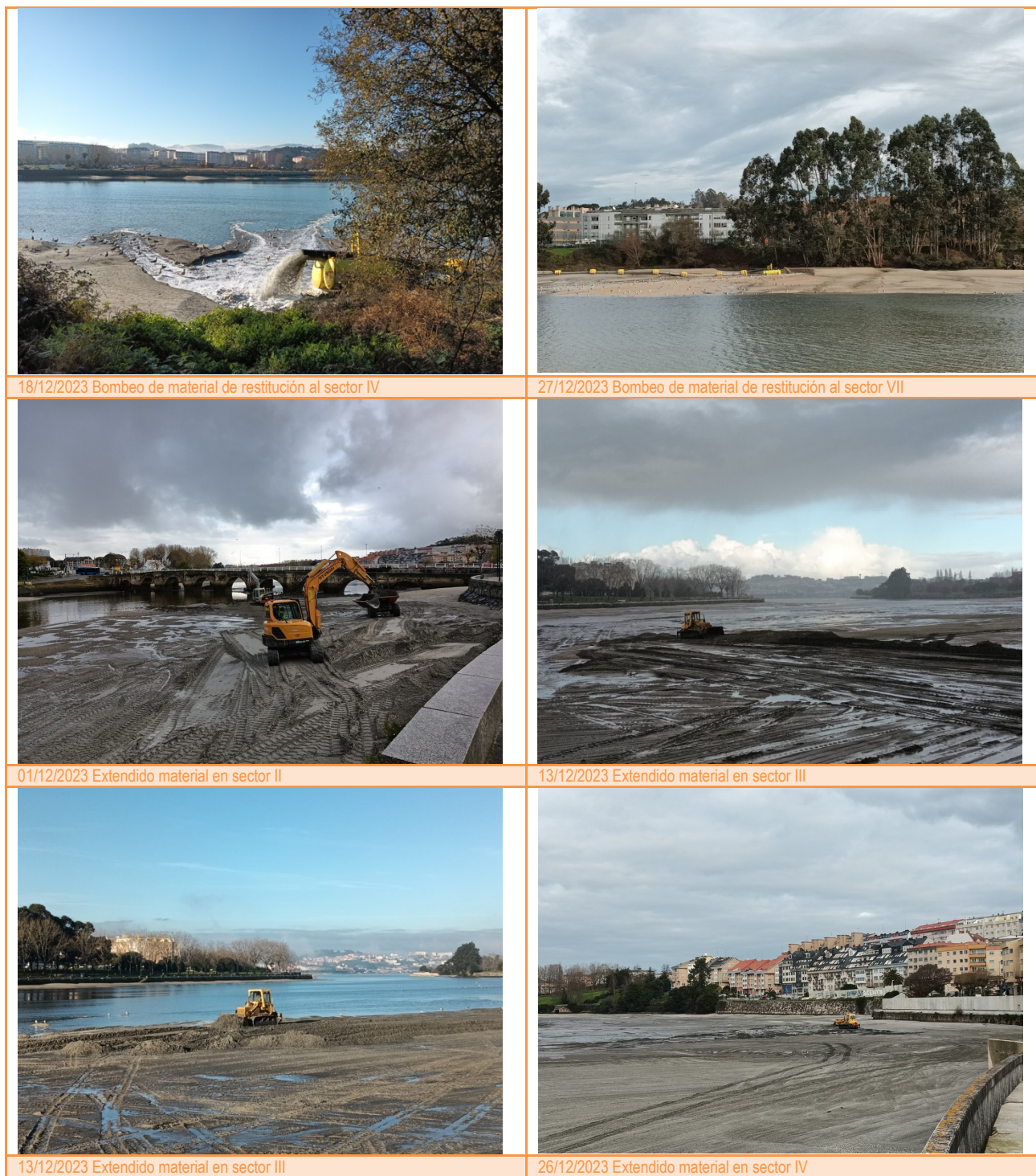
Figura 6 Extendido de material. Mes de diciembre de 2023.
