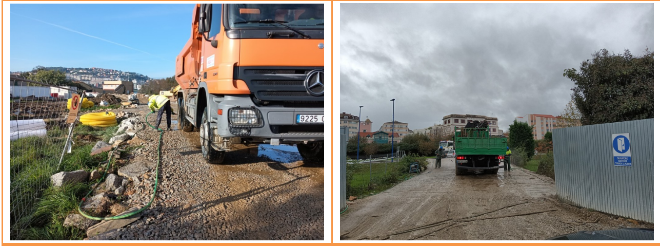
Figura 1 Lavado de ruedas de camiones a la salida de los recintos de obra de Oleiros y Culleredo.
