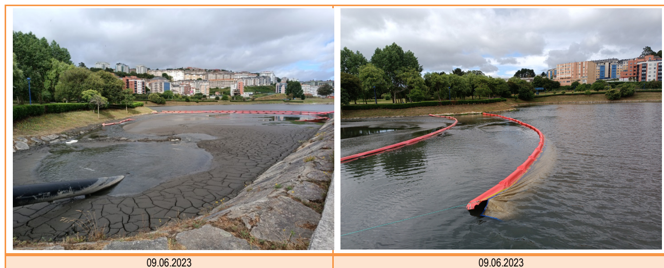
Figura 8 Decantación de fangos acumulados en la laguna de Fonteculler.
