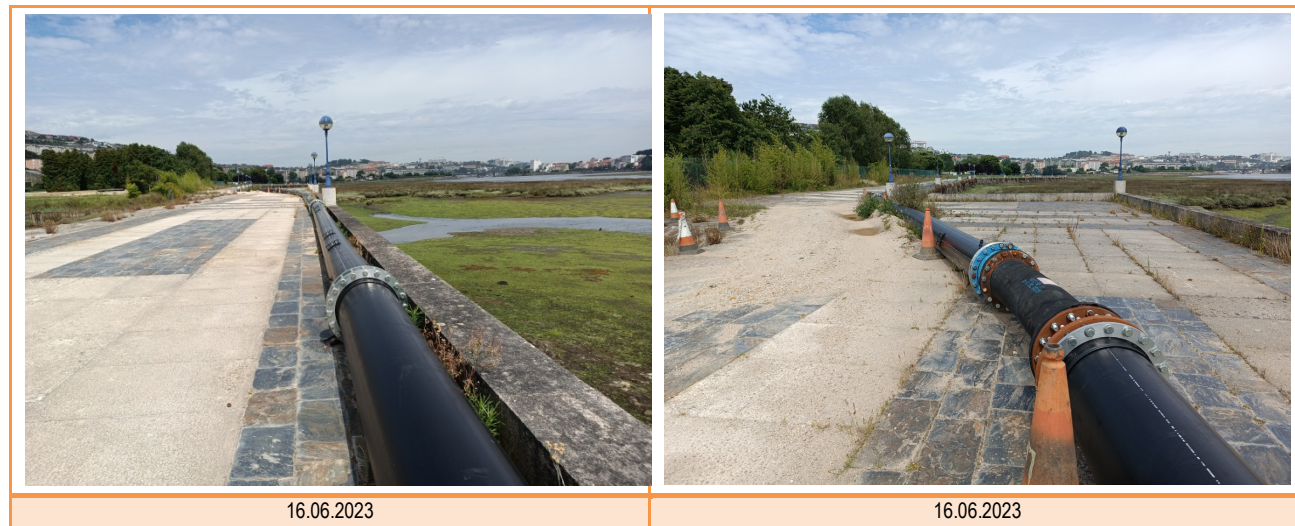
Figura 7 Instalación de impulsión
