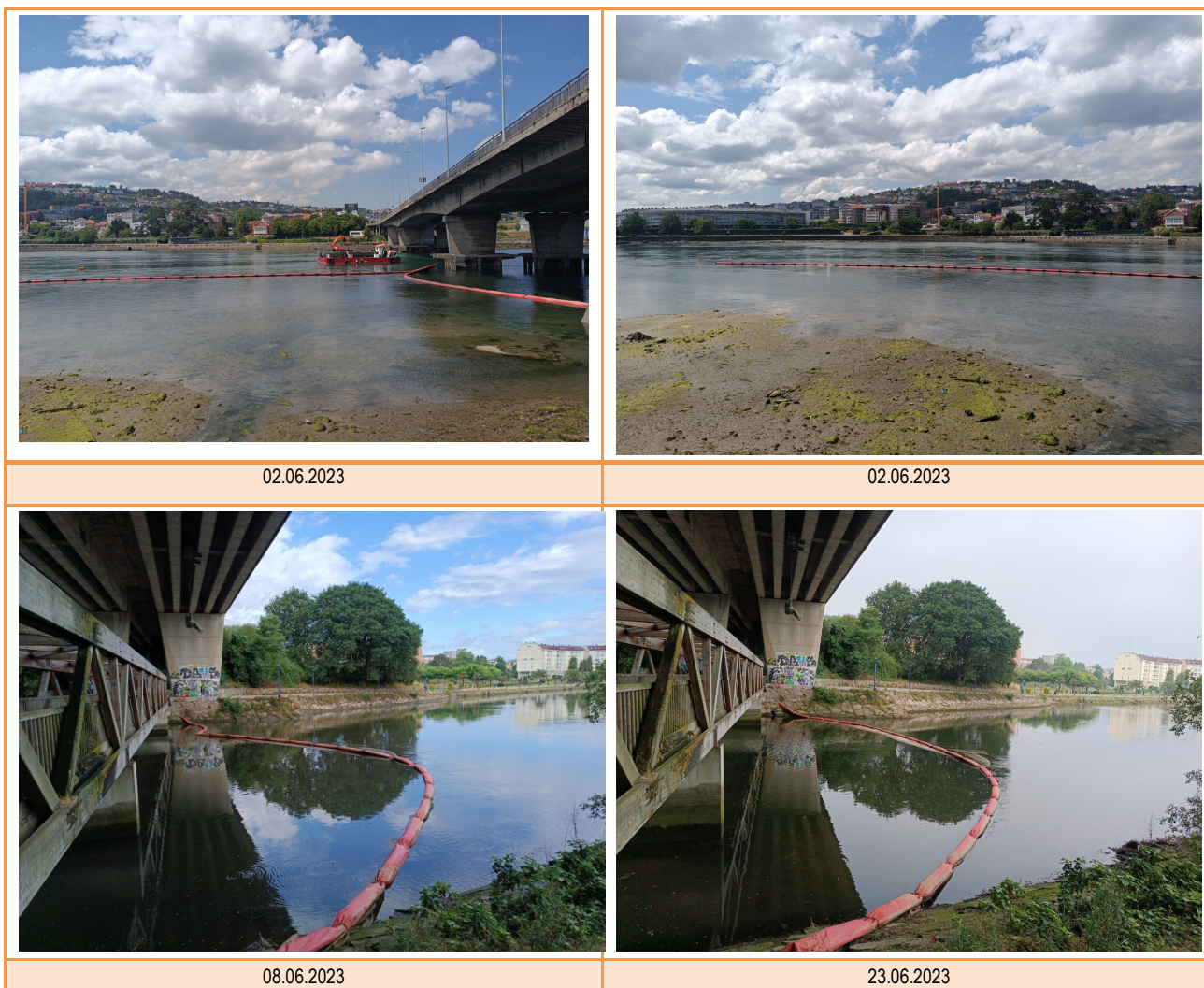
Figura 6 Seguimiento de la barrera antiturbidez.
