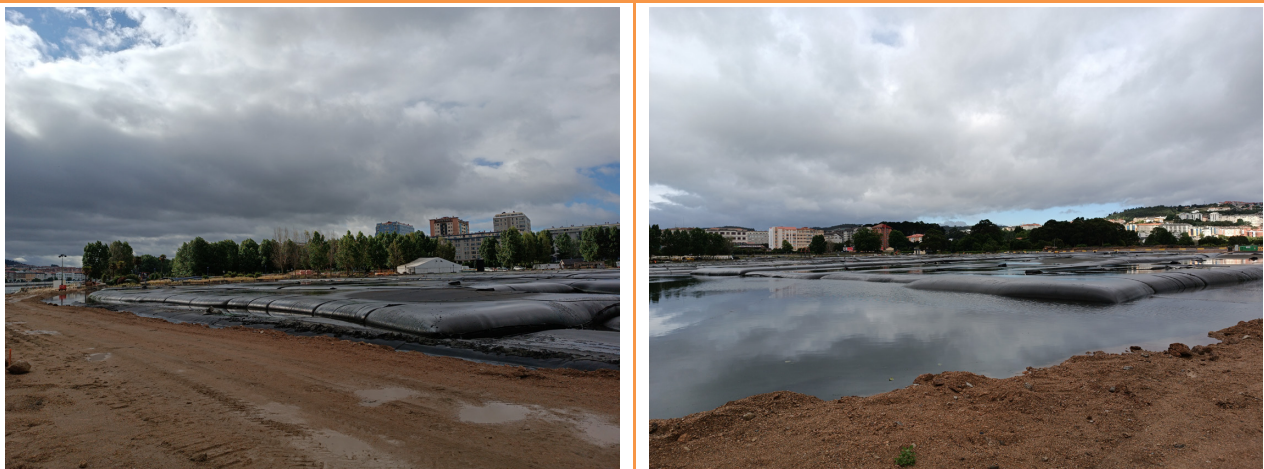
Figura 4 Llenado de geotubos
