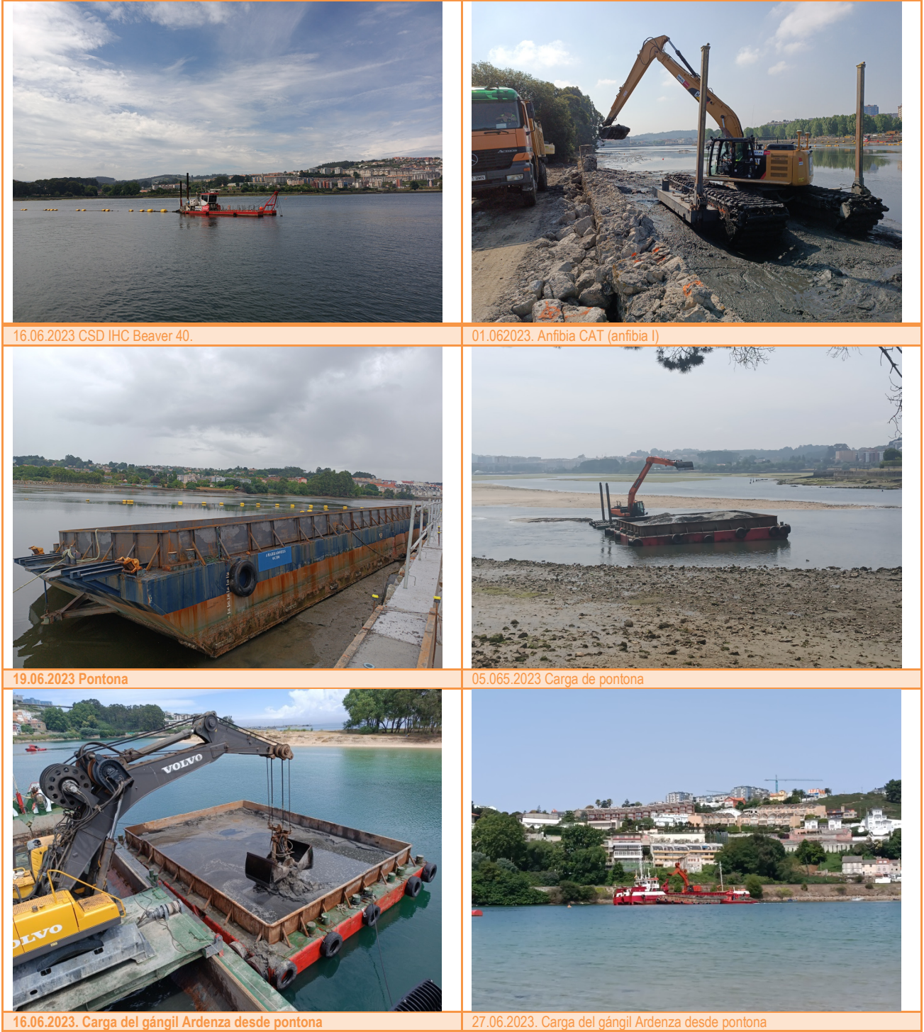
Figura 2 Equipos de dragado. Mes de junio de 2023.
