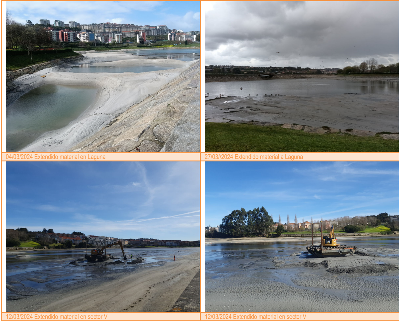
Figura 4 Extendido de material. Mes de marzo de 2024.
