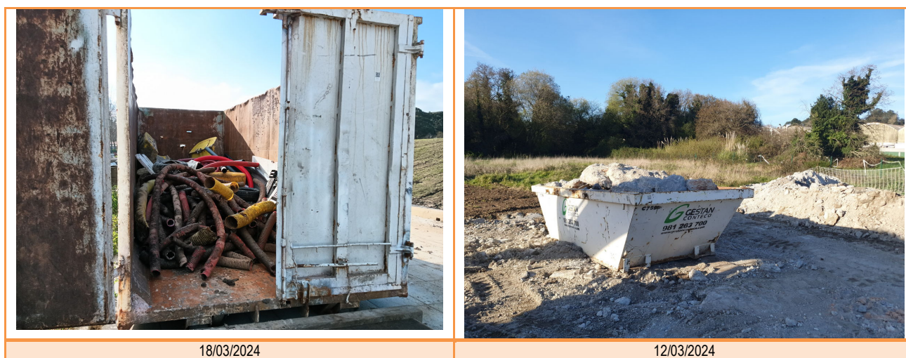
Figura 12 Seguimiento de control de residuos.
