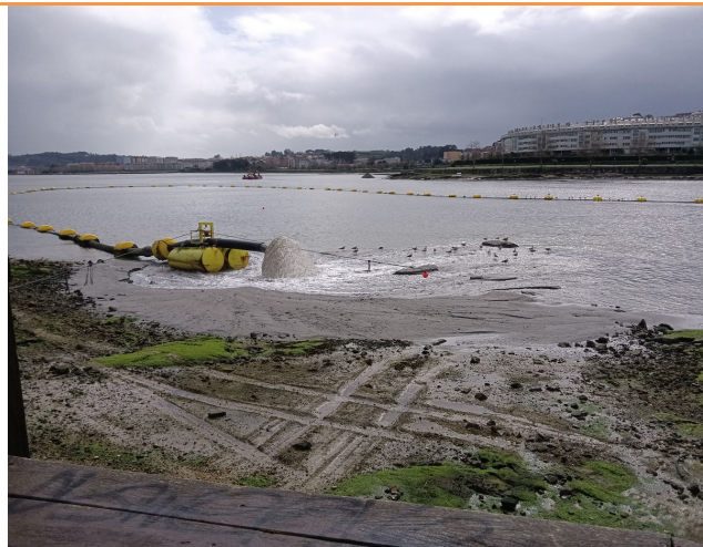
04/03/2024 Extendido de material en sector XV
