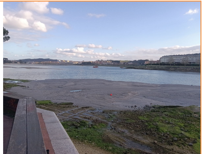
05/03/2024 Extendido de material en sector XV
