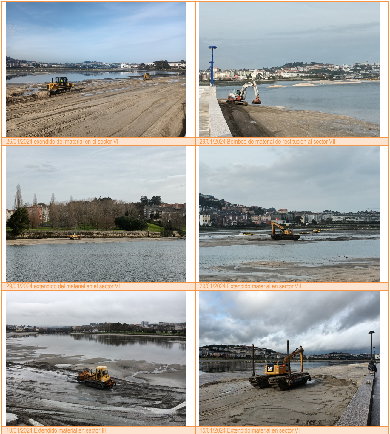
Figura 6 Extendido de material. Mes de enero de 2024.
