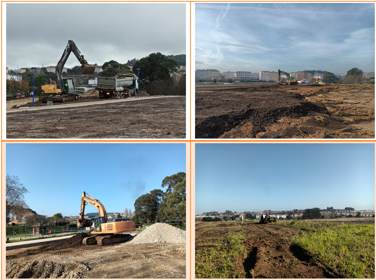
Figura 7 Actuaciones en el recinto de Culleredo
