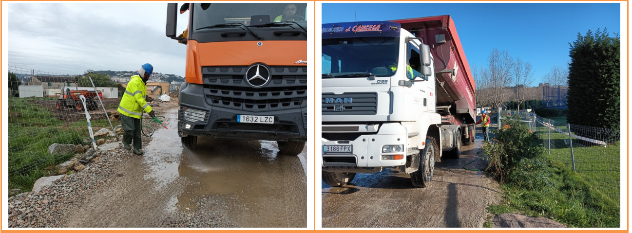
Figura 1 Lavado de ruedas de camiones a la salida de los recintos de obra de Culleredo.
