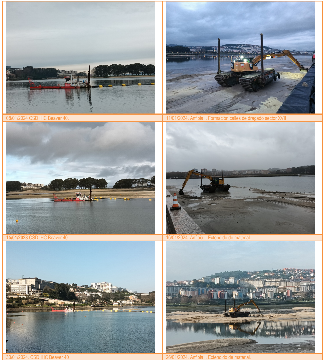
Figura 4 Equipos de dragado. Mes de enero de 2023.
