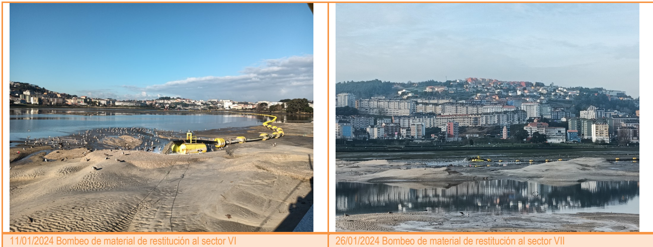
11/01/2024 Bombeo de material de restitución al sector VI
