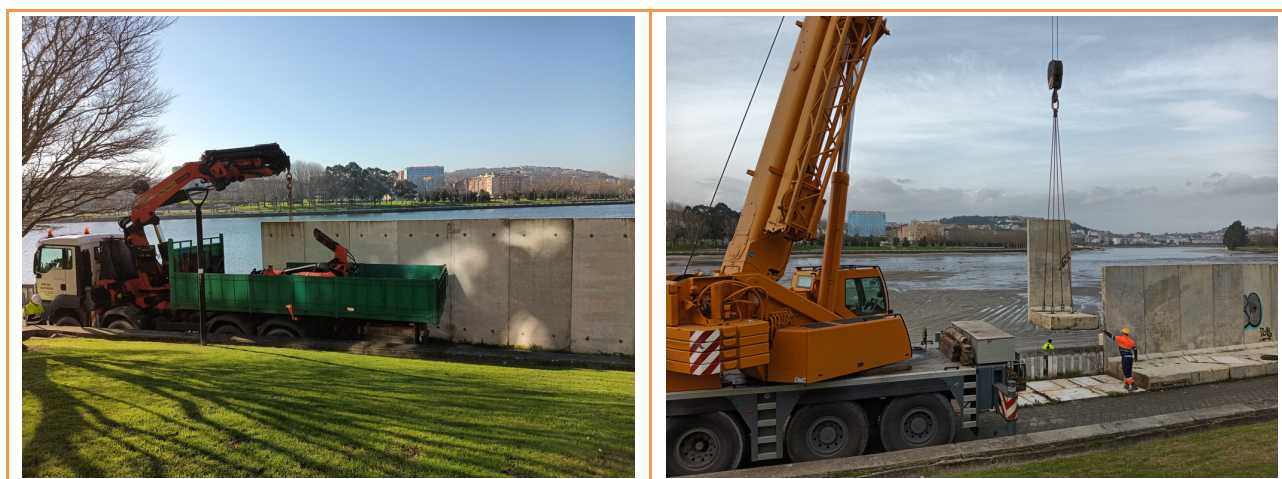
Figura 3 Inicio de la retirada de pantallas acústicas del sector III.
