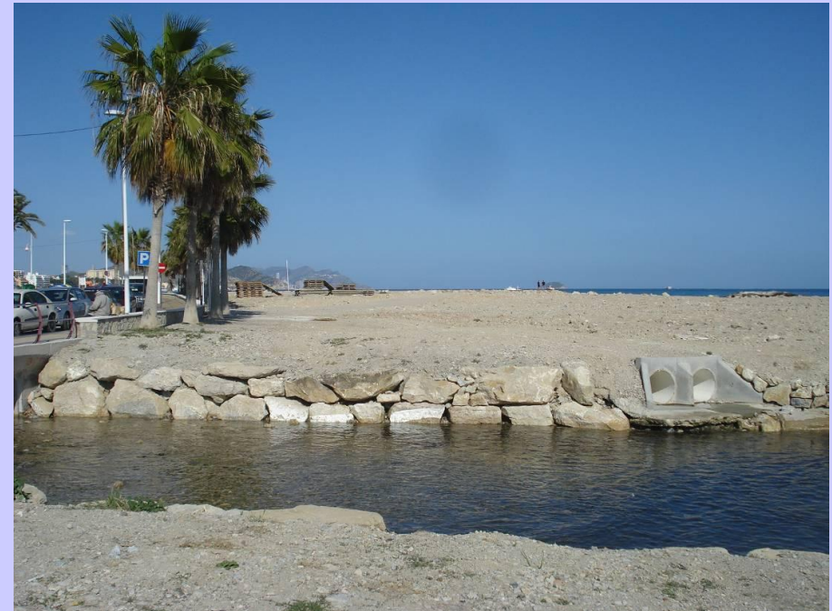
Vista de la zona una vez finalizados los trabajos
