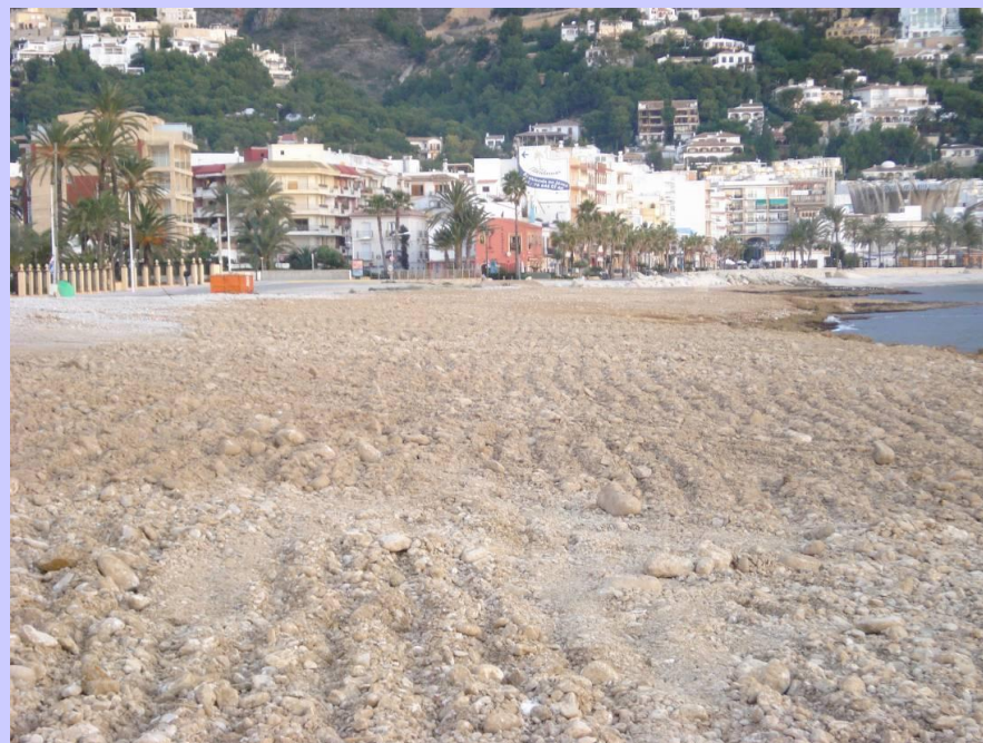
Vista de la zona con los trabajos finalizados
