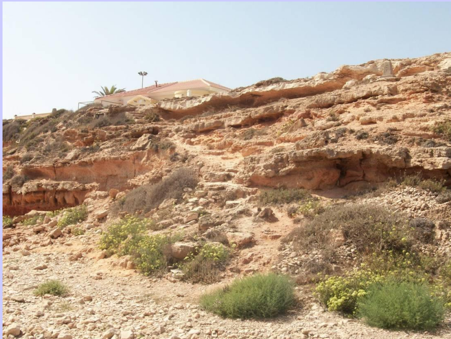
Vista previa de la zona del acceso 1
