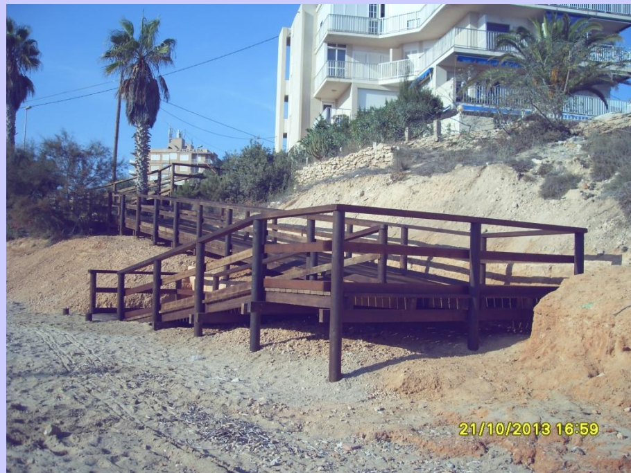
Pasarela tras la reparación
