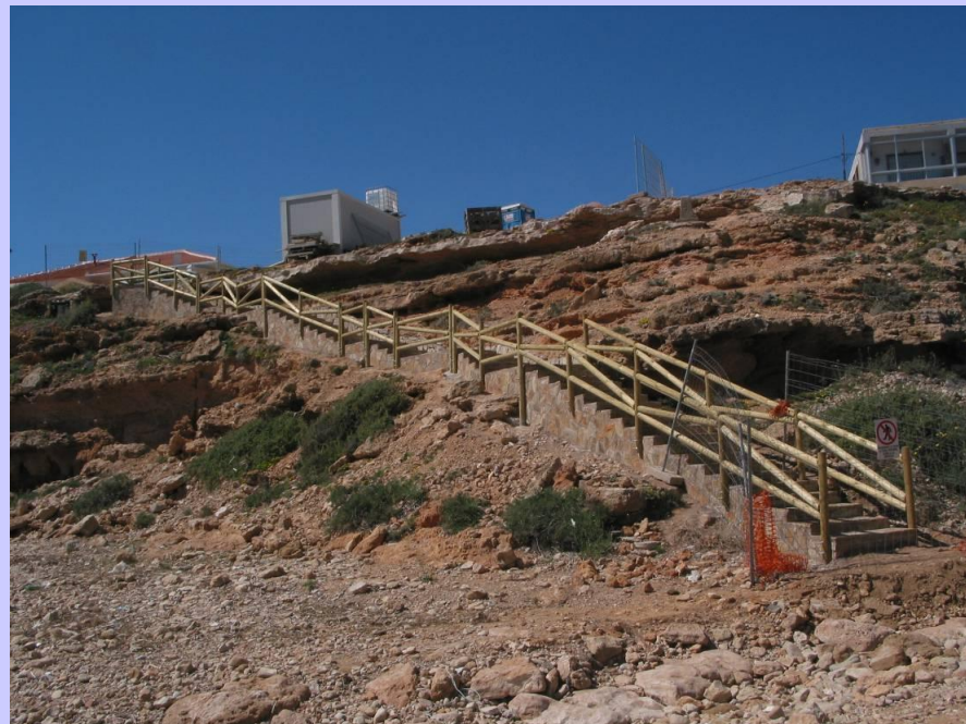
Vista del acceso 1, una vez finalizados los trabajos.
