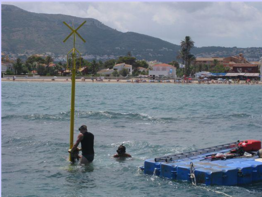
Imagen ejecutando los trabajos de colocación de los espeques
