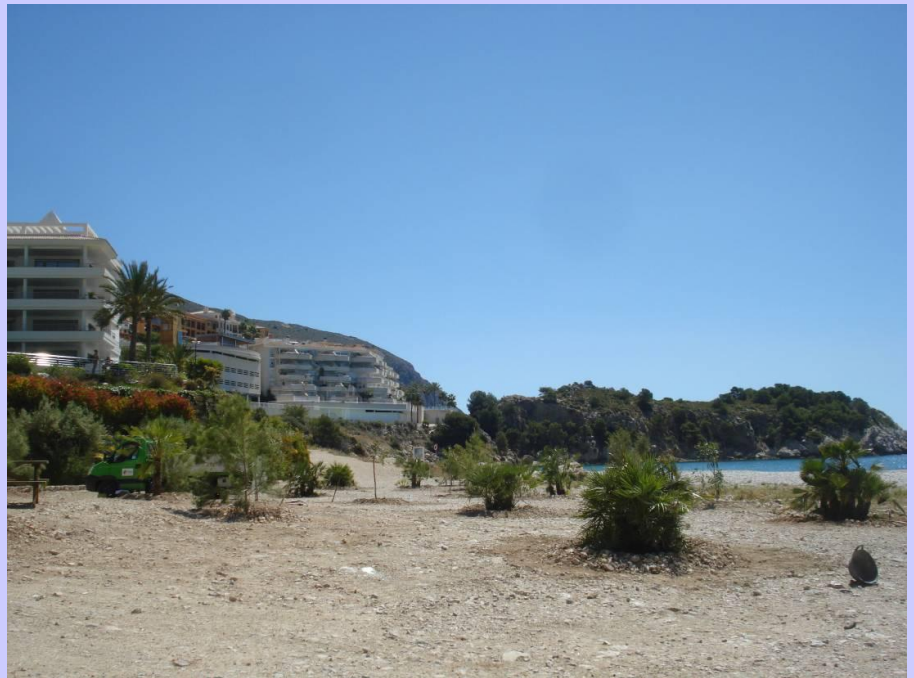
Estado final con la plantación.
