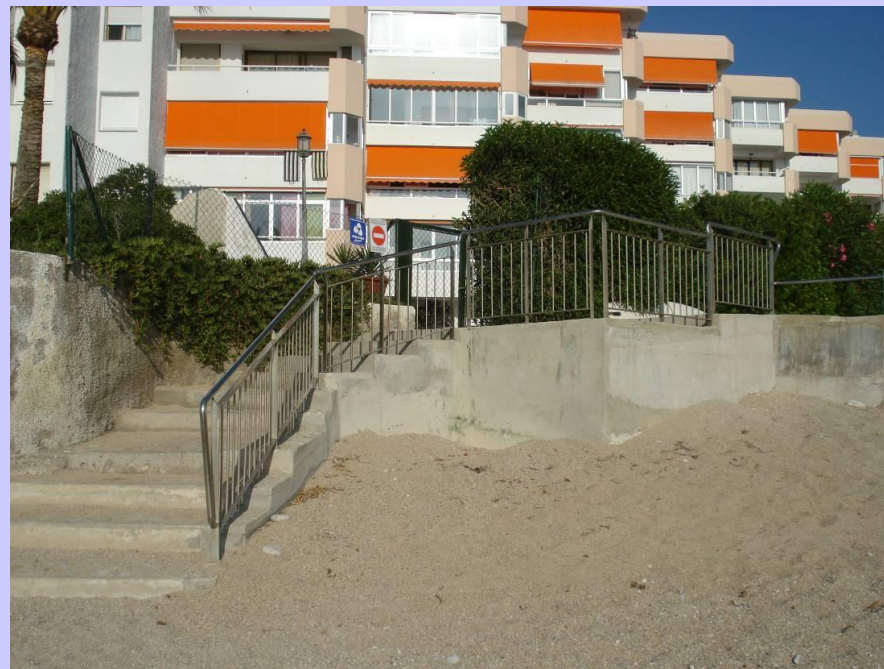
Estado final del acceso acondicionado.
