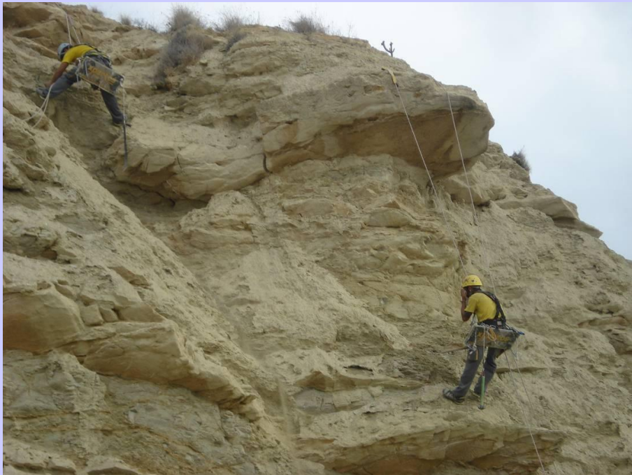
Trabajos de saneo en el talud.
