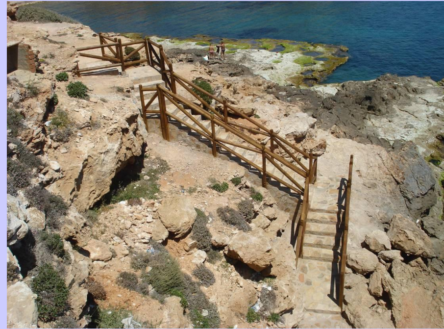
Vista del acceso 2, una vez finalizados los trabajos.
