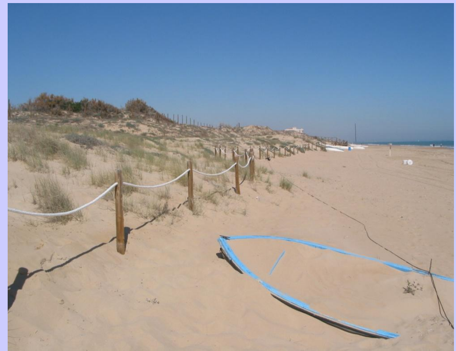
Vista general de un tramo cerramiento con la cuerda de nylon colocada
