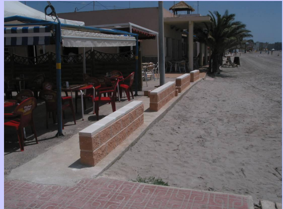
Vista de la misma calle con los muretes terminados
