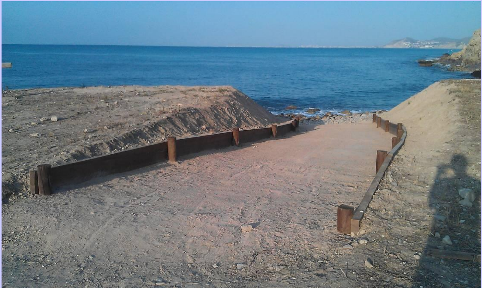
Vista de la rampa de acceso ejecutada
