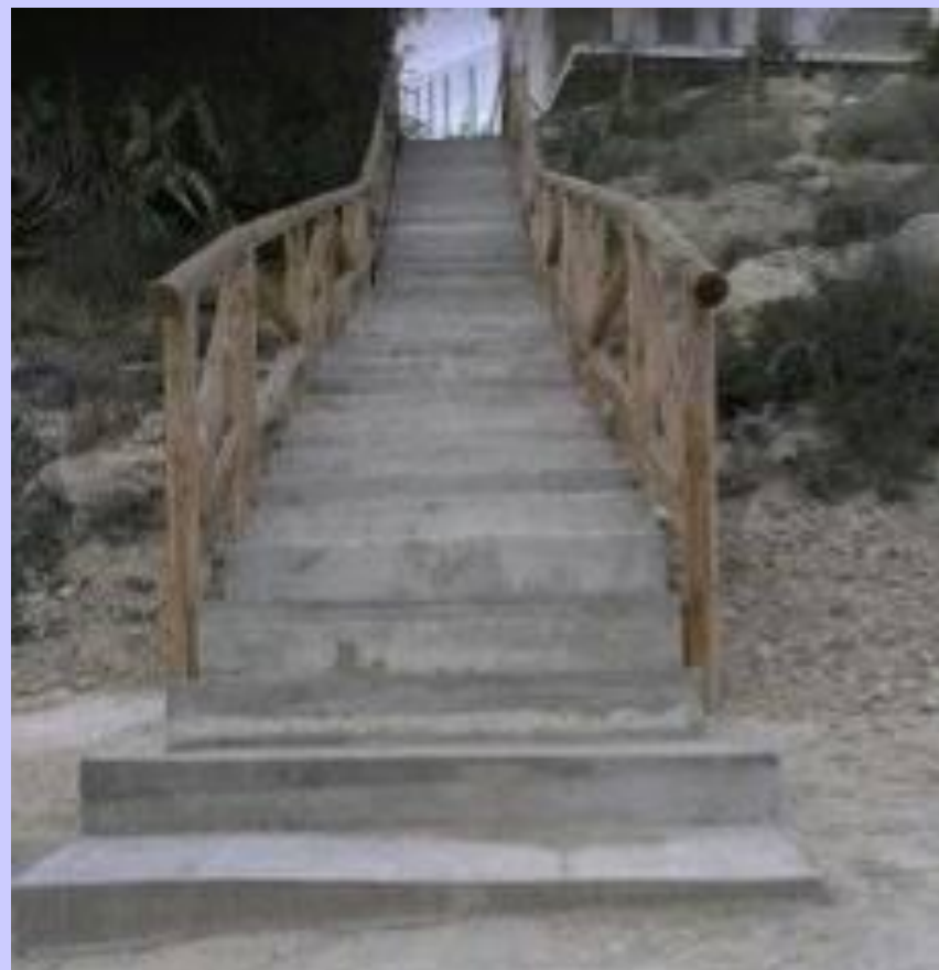
Acceso 2 una vez finalizada la reconstrucción
