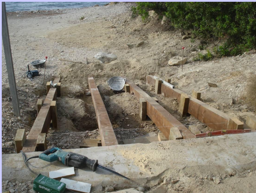
Inicio de los trabajos de ejecución De la rampa
