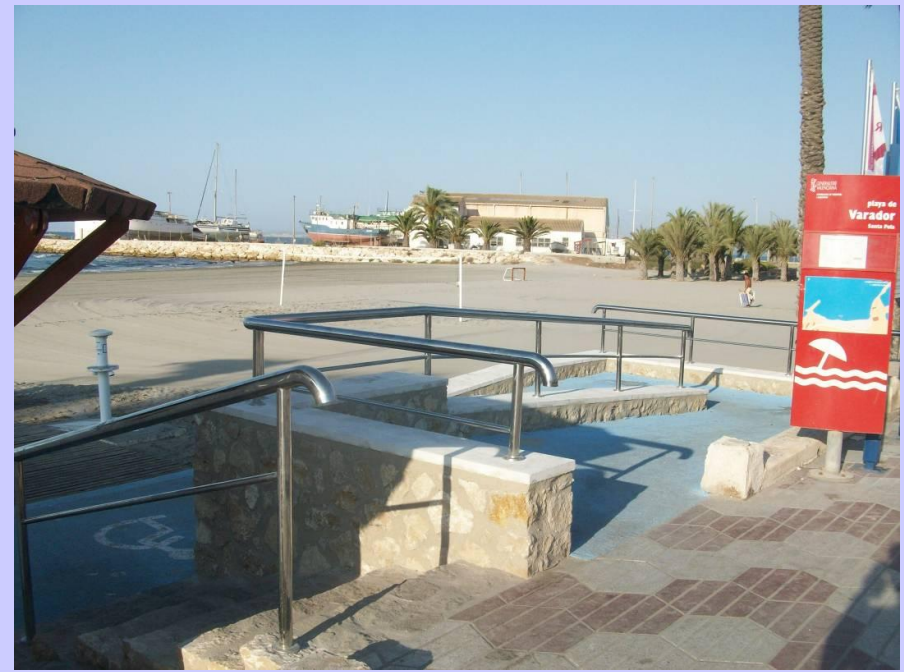
Rampa y escalera finalizada.
