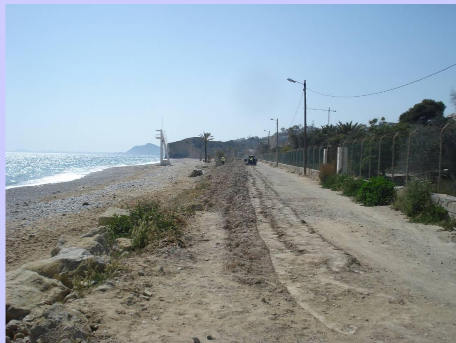
Imagen con los trabajos de escarificado y retirada de vallado iniciados.
