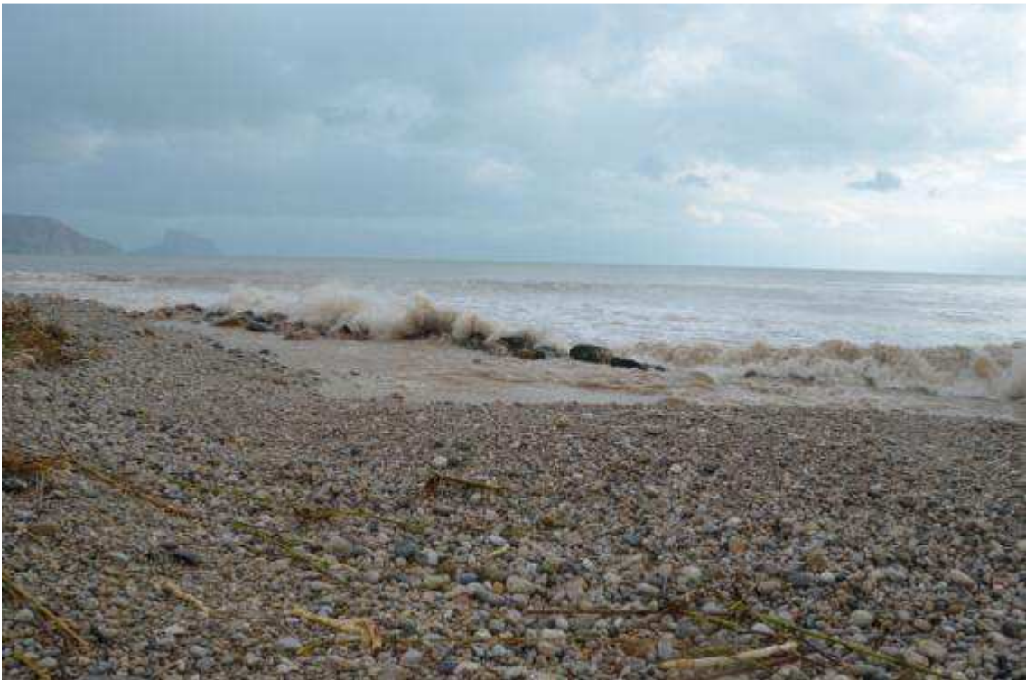
PROTECCIÓN DE ESCOLLERA. ALTEA
