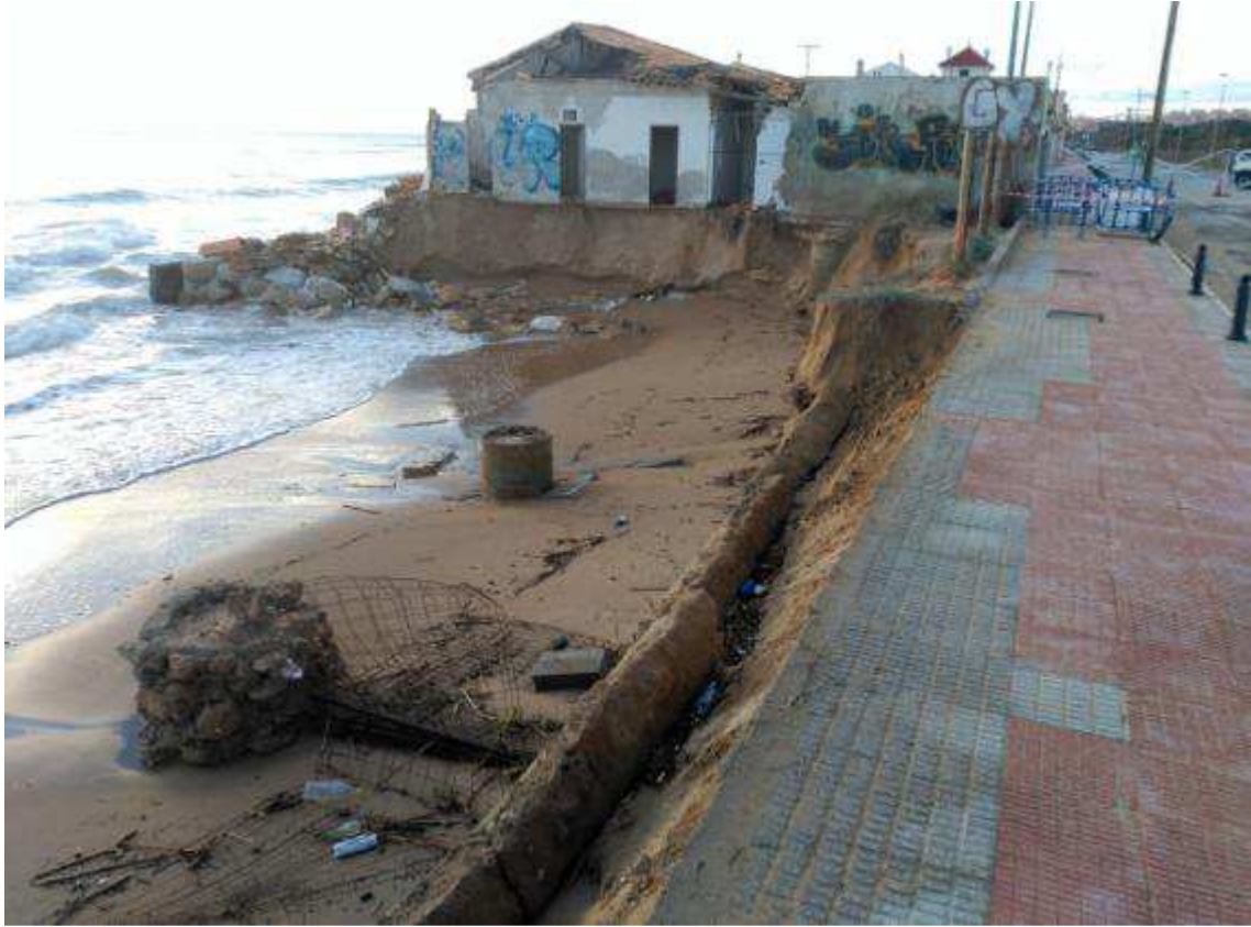
VIVIENDA EN RUINAS. GUARDAMAR DEL SEGURA
