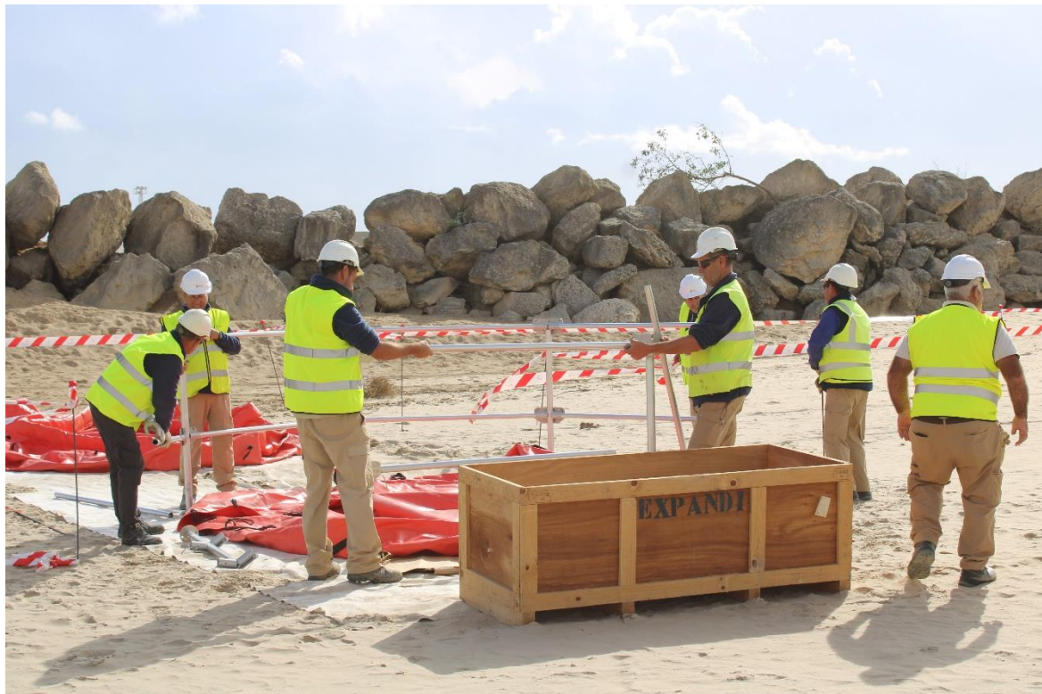
Ilustración 31. Personal interviniente practicando el montaje de los tanques de almacenamiento.
