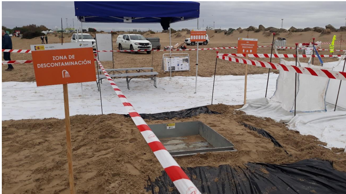
Ilustración 32. Vista general de la zona de descontaminación.
