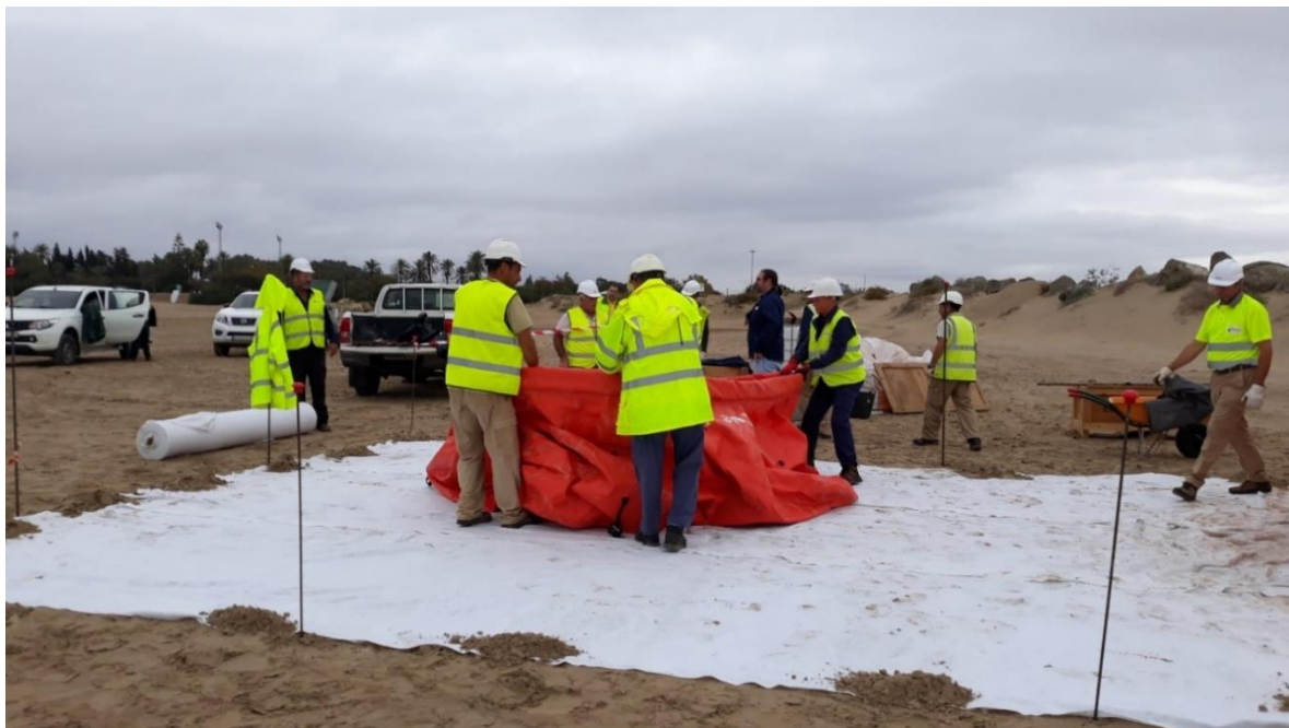
Ilustración 33. Personal interviniente realizando el despliegue del tanque autoportante.
