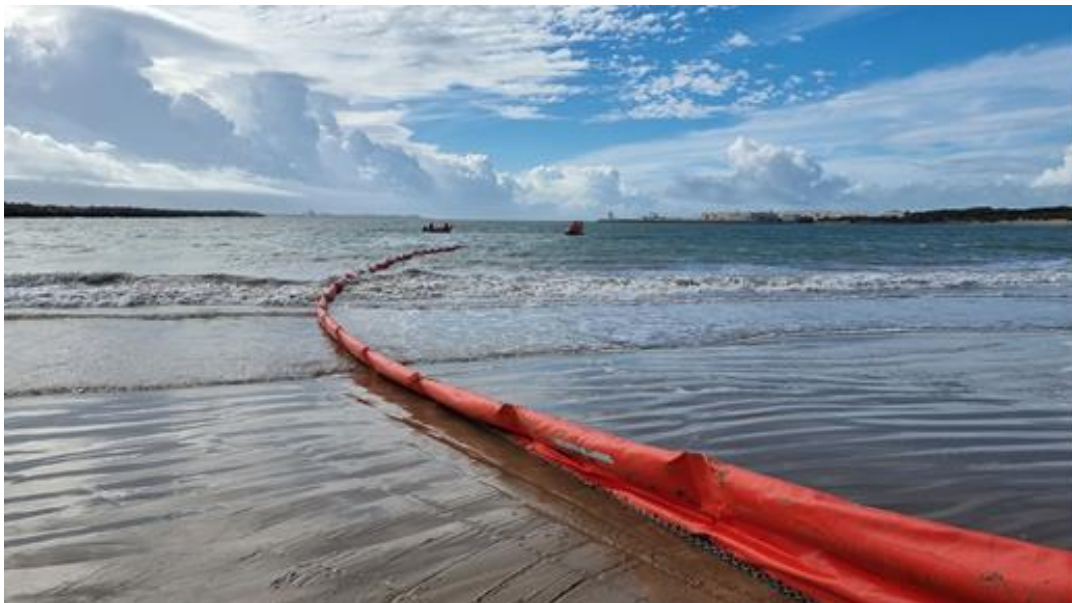
Ilustración 38. Despliegue de barreras de contención en la playa.
