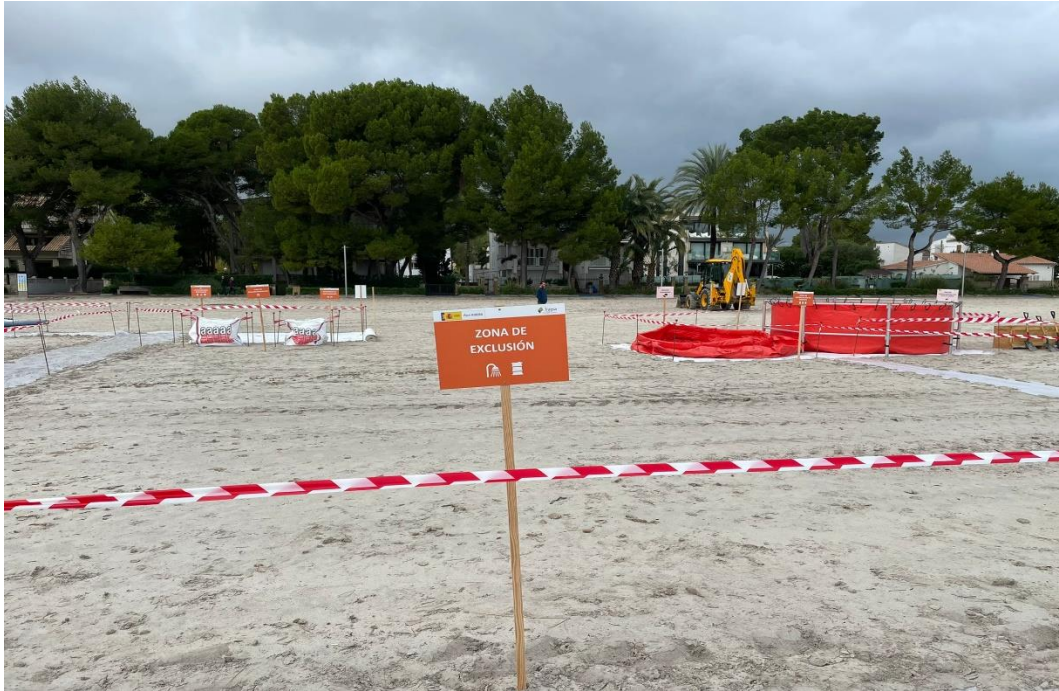
Ilustración 25. Zona de exclusión donde se pueden ver las dos partes que la forman (descontaminación a la izquierda y almacenamiento de residuos a la derecha).
