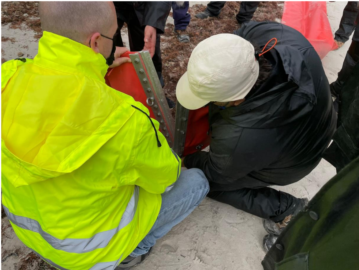
Ilustración 21. Empatado de la barrera cilíndrica con la selladora.
