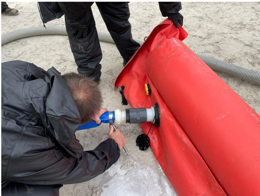
Ilustración 23. Llenado de agua de las cámaras inferiores de la barrera selladora.
