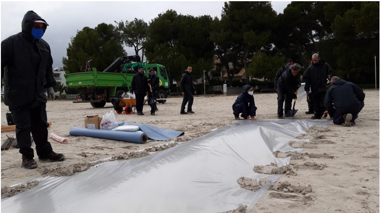
Ilustración 24. Montaje de los corredores con láminas plásticas.
