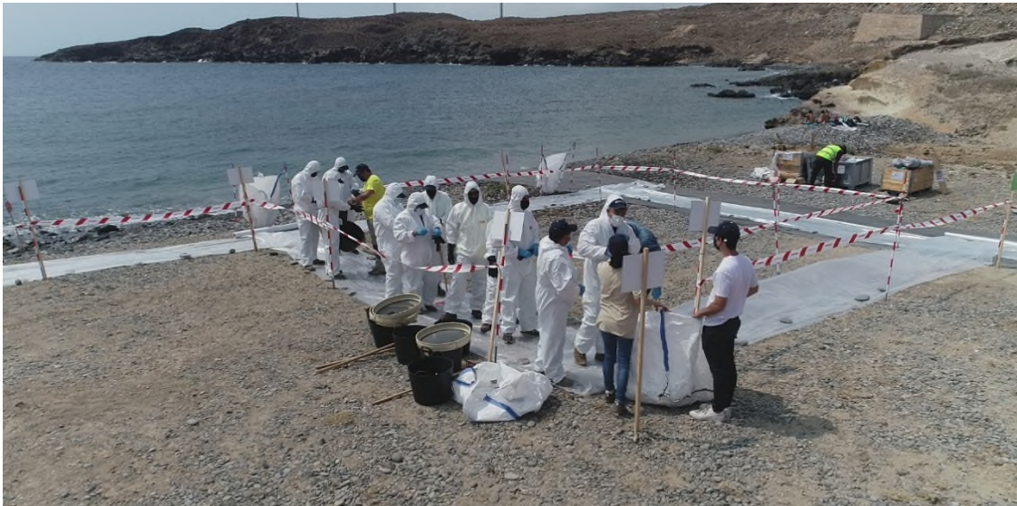
Ilustración 33. Retirada de EPI y recogida de herramientas en la zona de descontaminación.
