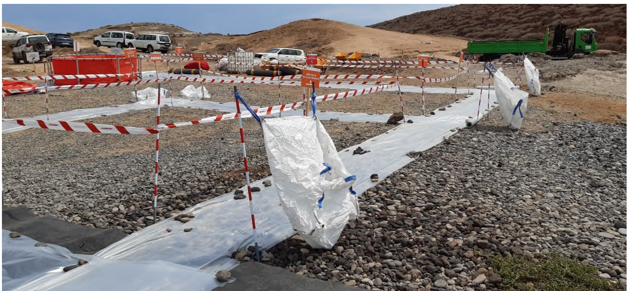
Ilustración 25. Vista de los corredores en la zona de trabajo.
