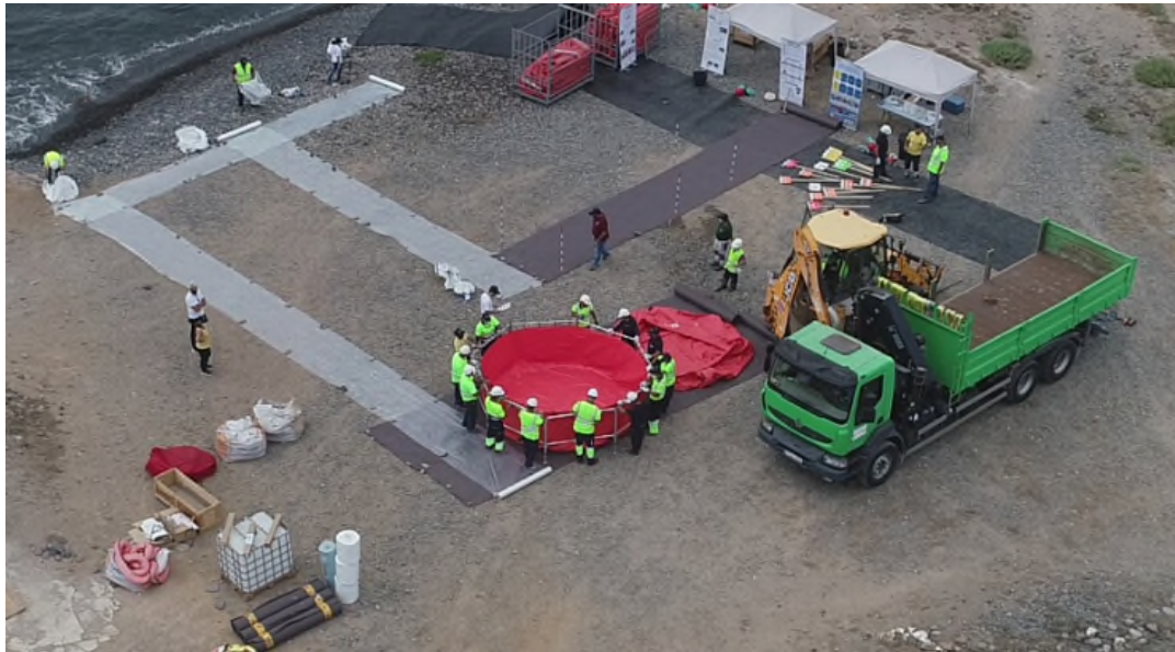
Ilustración 29. Montaje de tanques en la zona de almacenamiento temporal de residuos.
