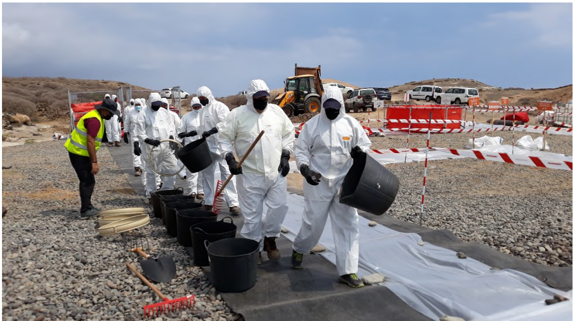
Ilustración 27. Recogida de las herramientas de limpieza en el corredor limpio.
