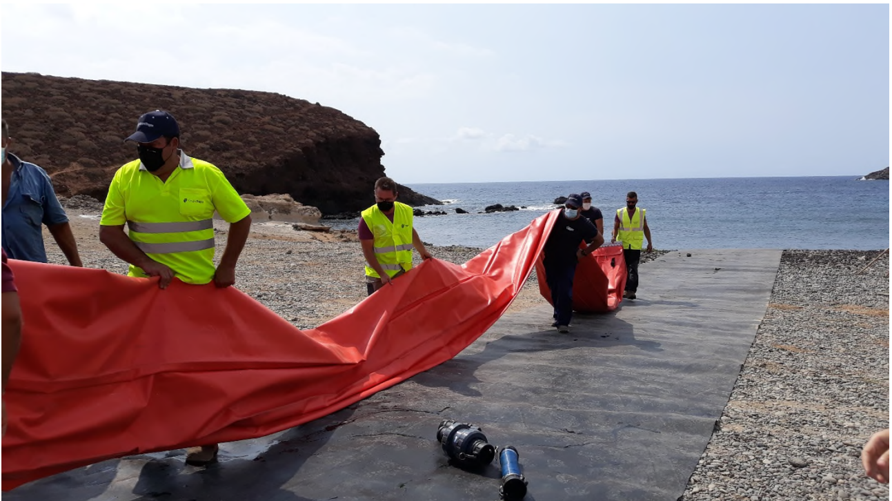
Ilustración 24. Recogida de la barrera selladora.
