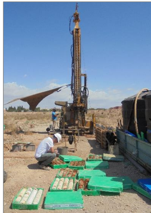
Figura 5. Imágenes de la construcción de los sondeos litológicos.
