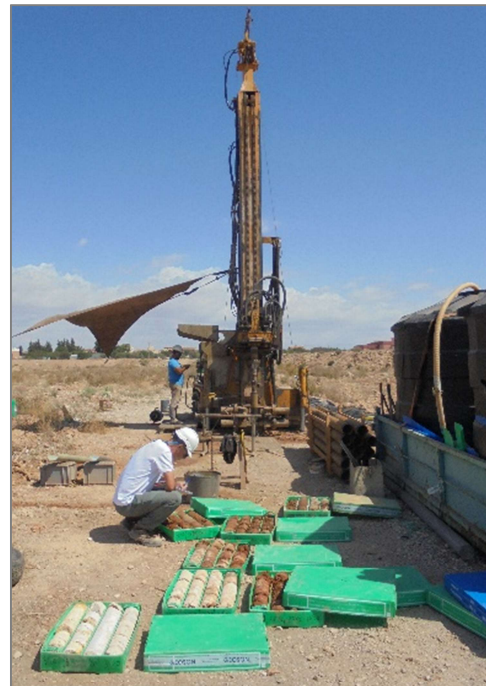
Figura 21. Imágenes de la construcción de los sondeos litológicos.
