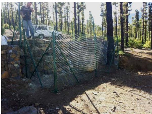
Ilustración 5.- Trabajos de cercado del aljibe
