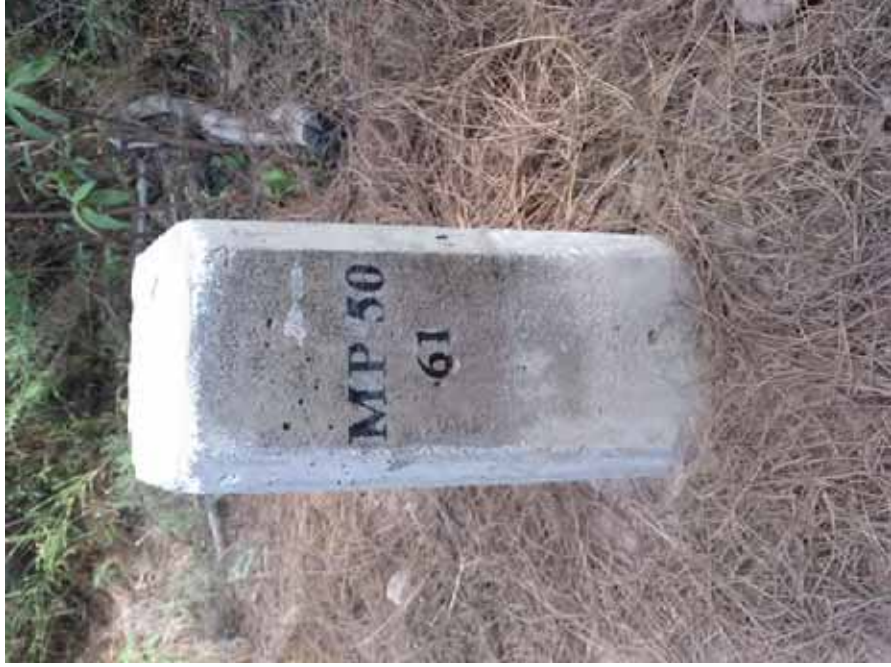
Detalle del mojón colocado
