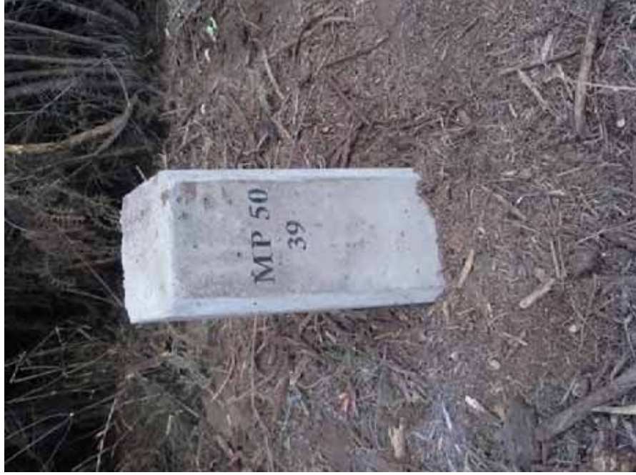
Detalle del mojón colocado
