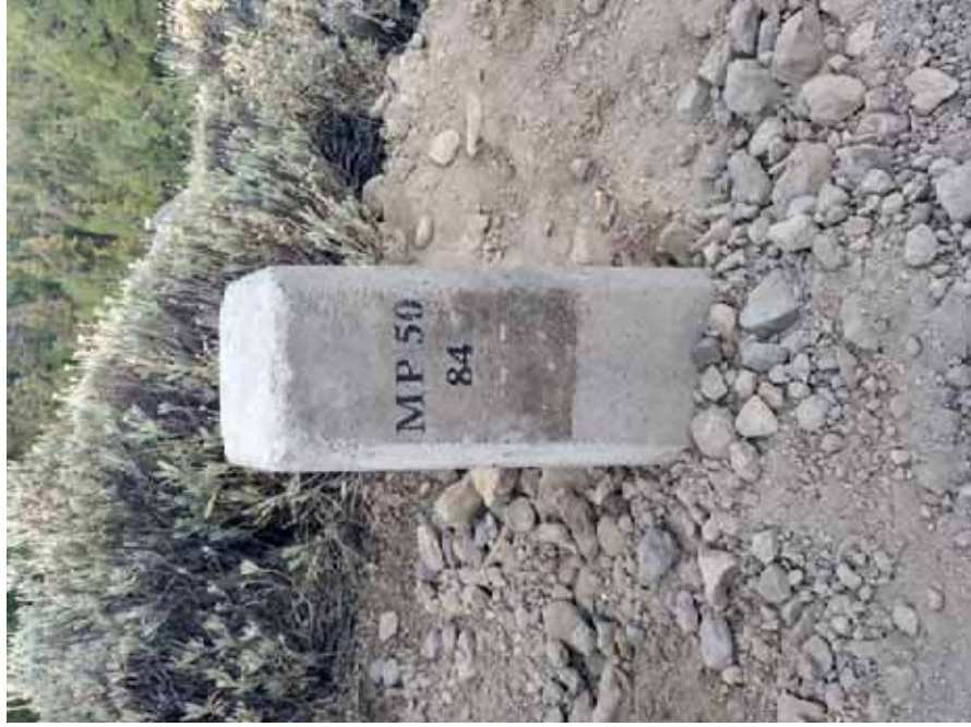
Detalle del mojón colocado
