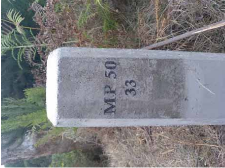
Detalle del mojón colocado
