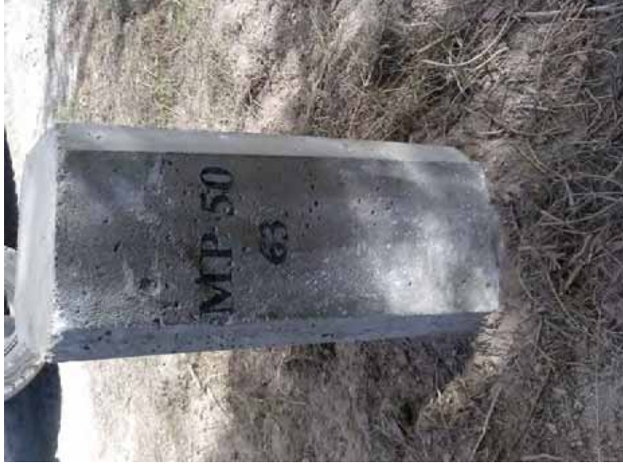
Detalle del mojón colocado
