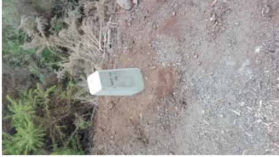
Detalle del mojón colocado
