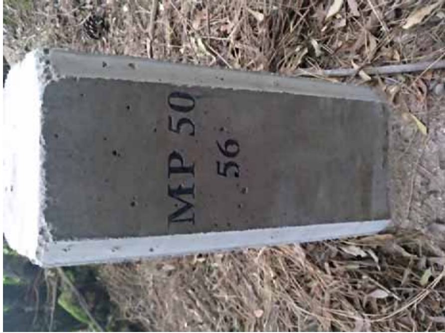
Detalle del mojón colocado
