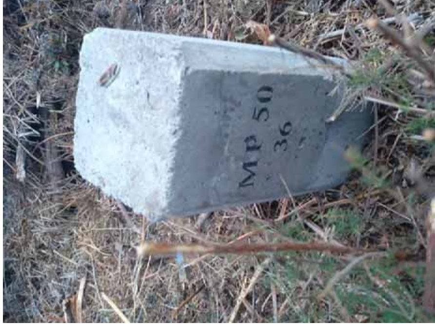
Detalle del mojón colocado
