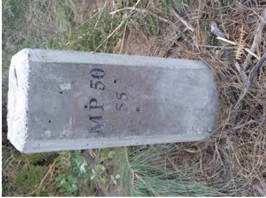
Detalle del mojón colocado
