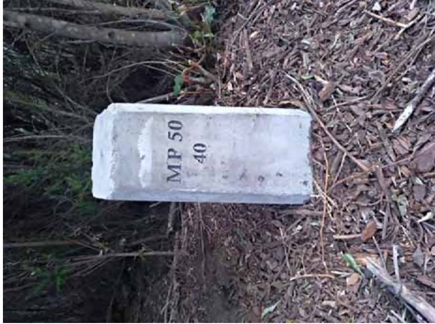
Detalle del mojón colocado
