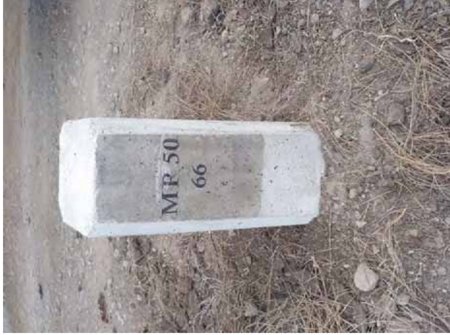
Detalle del mojón colocado
