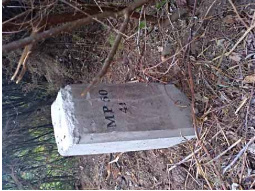
Detalle del mojón colocado
