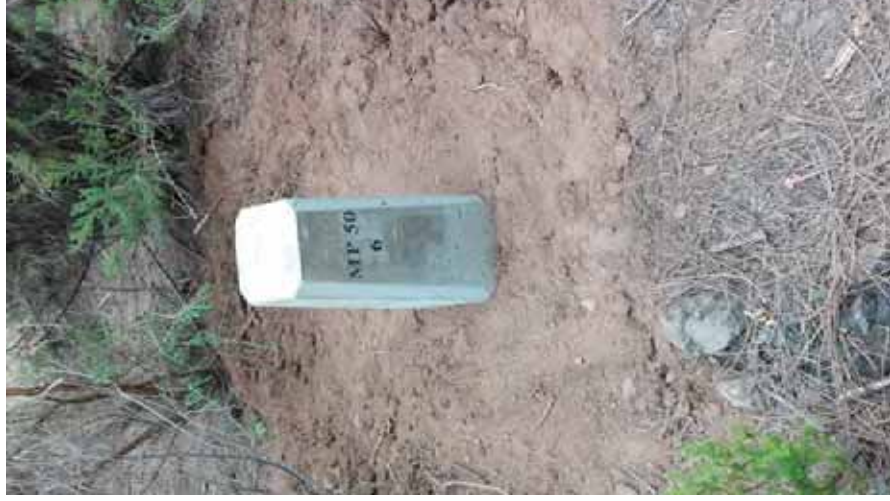
Detalle del mojón colocado
