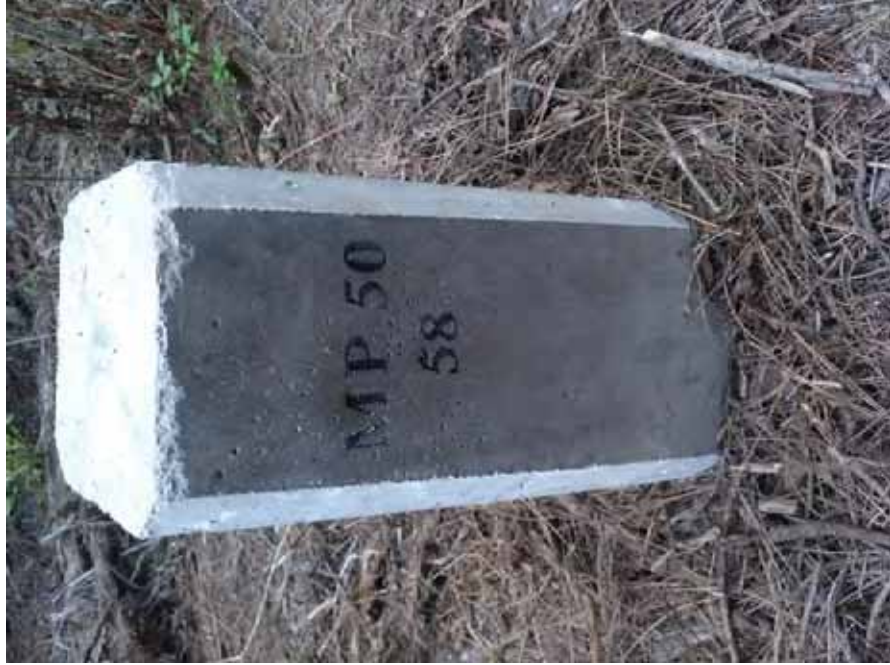
Detalle del mojón colocado
