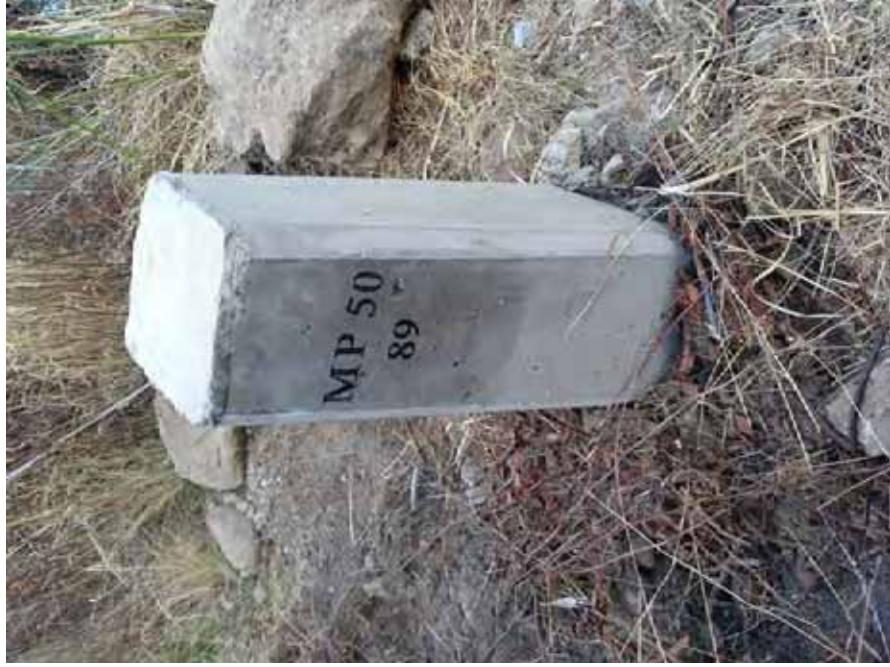
Detalle del mojón colocado
