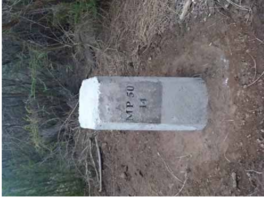
Detalle del mojón colocado
