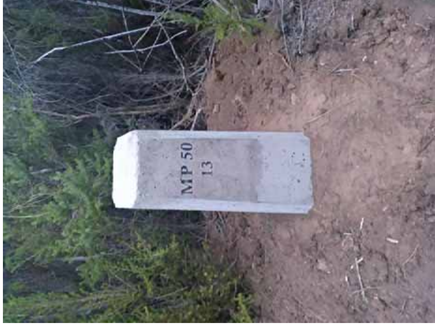
Detalle del mojón colocado
