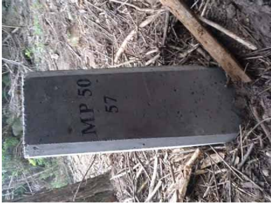
Detalle del mojón colocado
