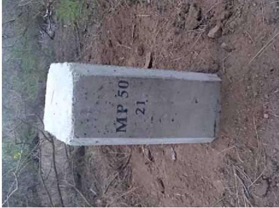
Detalle del mojón colocado
