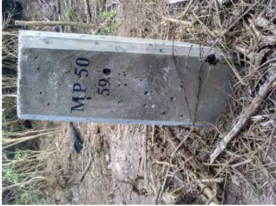
Detalle del mojón colocado
