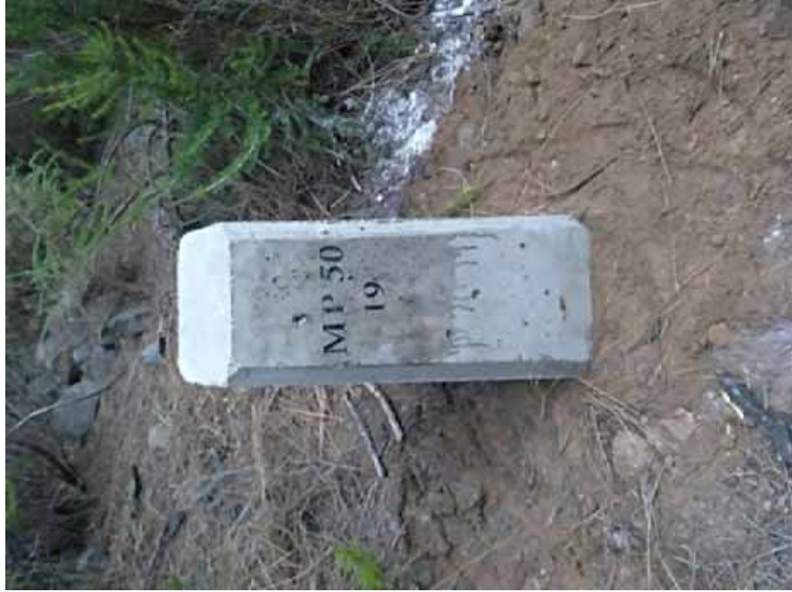
Detalle del mojón colocado
