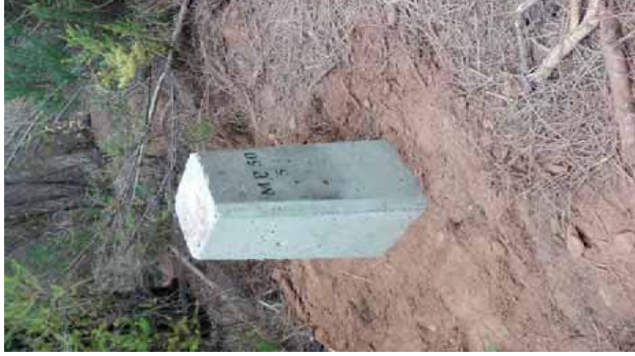
Detalle del mojón colocado
