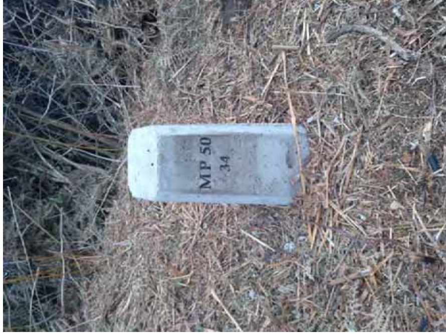
Detalle del mojón colocado
