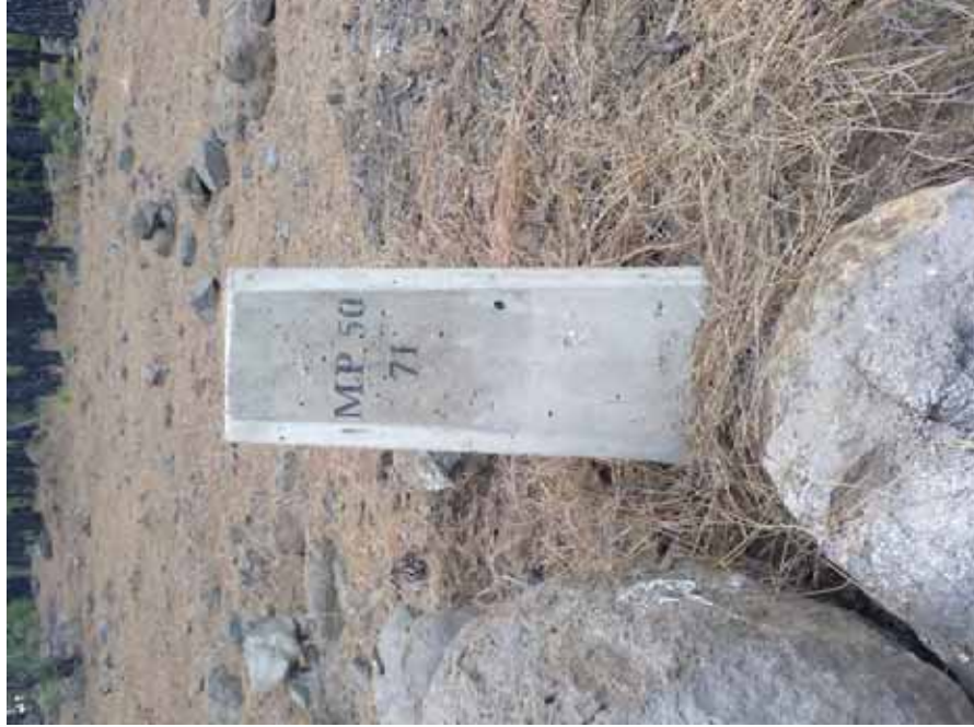
Detalle del mojón colocado
