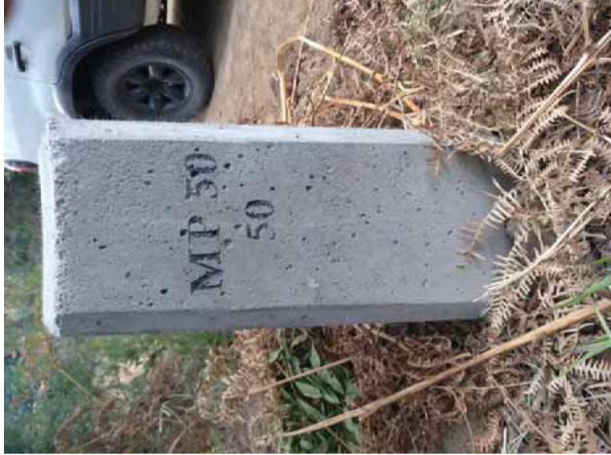
Detalle del mojón colocado
