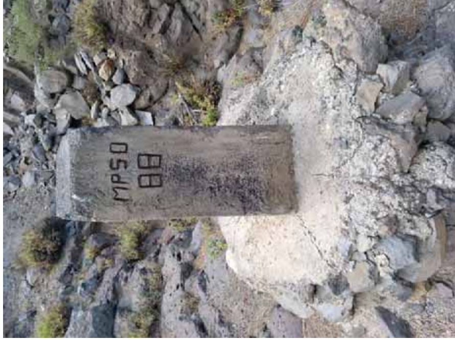
Detalle del mojón colocado
