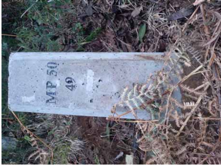
Detalle del mojón colocado
