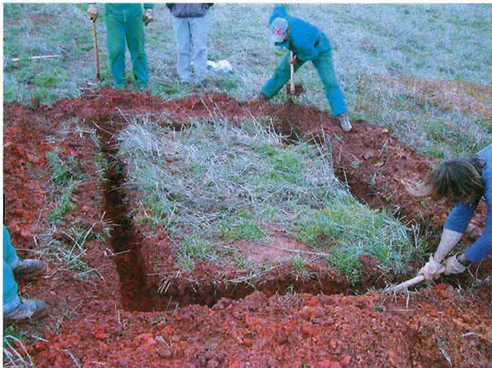
Fotografía 26. Construcción de majano de mallazo electrosoldado (1)
