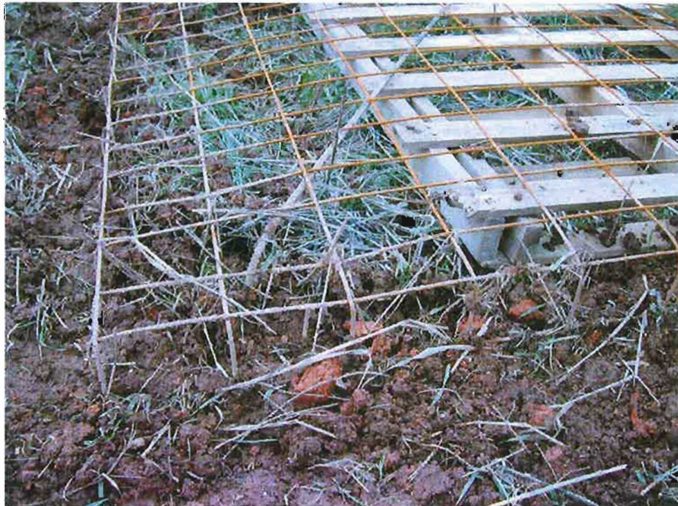
Fotografía 29. Construcción de majano de mallazo electrosoldado (4)
