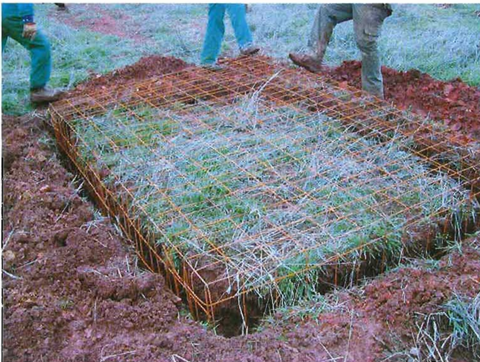
Fotografía 27. Construcción de majano de mallazo electrosoldado (2)
