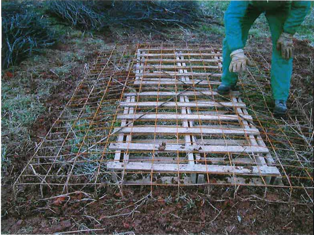
Fotografía 28. Construcción de majano de mallazo electrosoldado (3)
