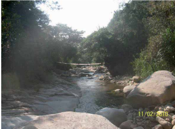
Sitio elegido para la instalación de tarabita en la estación La Rinconada sobre La Microcuenca La Cinco Mil
