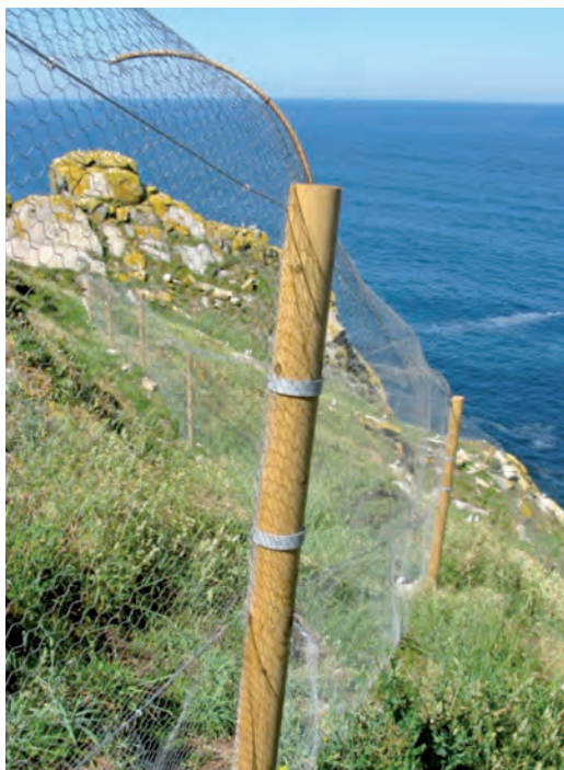
Foto 2. Detalle de la valla de «visera floja» empleada para impedir la entrada de depredadores carnívoros terrestres a los cercados.
