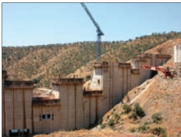
Figura 3-55. Construcción de presa en el embalse sobre el río Montoro, en Sierra Morena central.
