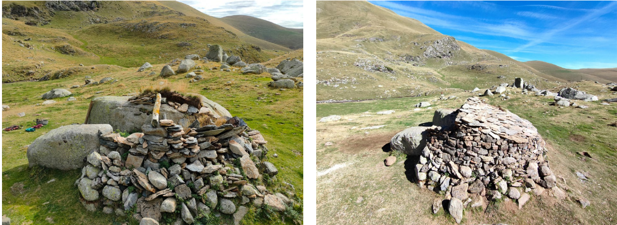
Imatge 20: Estat de la cabana abans (esquerra) i després de l'arranjament (dreta).
