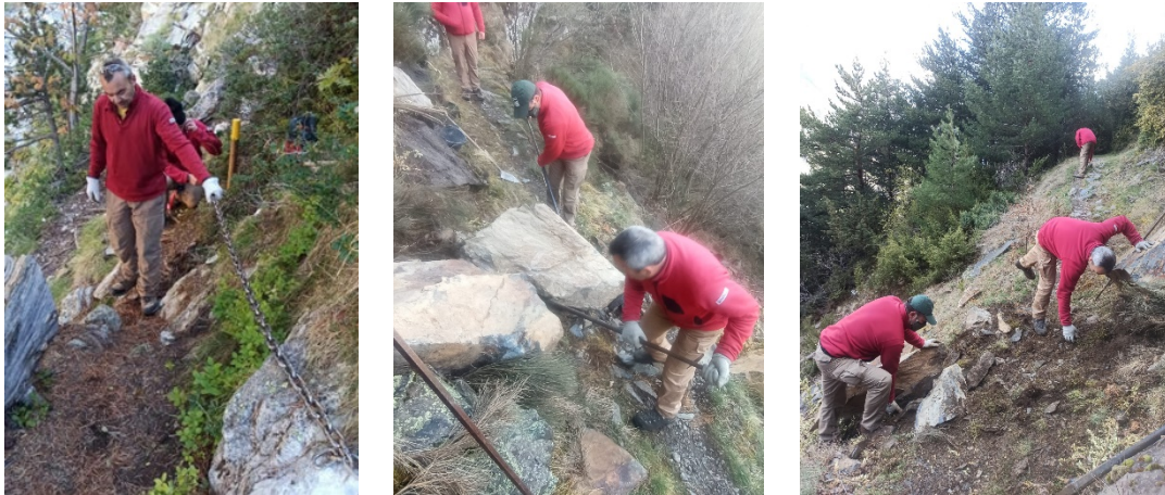
Imatge 35: Instal·lació de passamans al camí de Comalesbienes i retirada de rocs perillosos.
