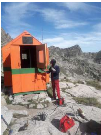
Imatges 19 i 20. Treballs de soldadura de la maneta del refugi del Gerber – Mataró.
