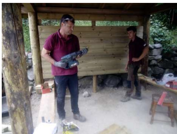
Imatges 26. Muntatge del plafó de fusta a l'aixopluc de Toirigo
