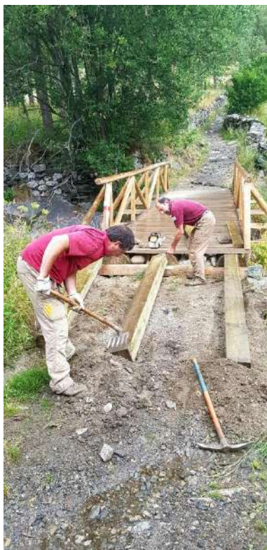
Imatges 35, 36 i 37 . Treballs per a la incorporació d'una rampa al pont de Suar.
