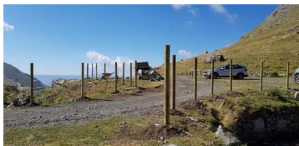
Imatges 33 i 34. Feines de substitució de la barana de l'aparcament de la Mainera.
