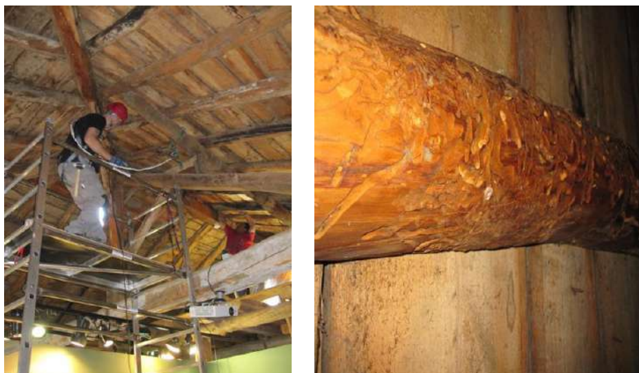
Imatges 16 i 17. Tasques de desinsectació de les bigues del llosat del punt d'informació de Llessui.
