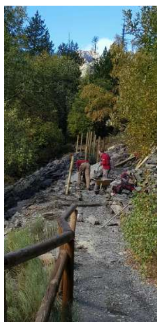
Imatges 38, 39, 40 i 41. Substitució de la barana del camí de la cascada al Sector Sant Maurici.
