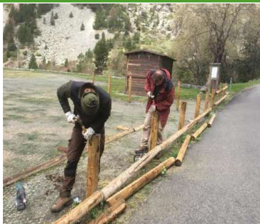
Imatges 31 i 32 Feines de reforç i substitució de les baranes dels aparcaments de Cavallers i La Molina
