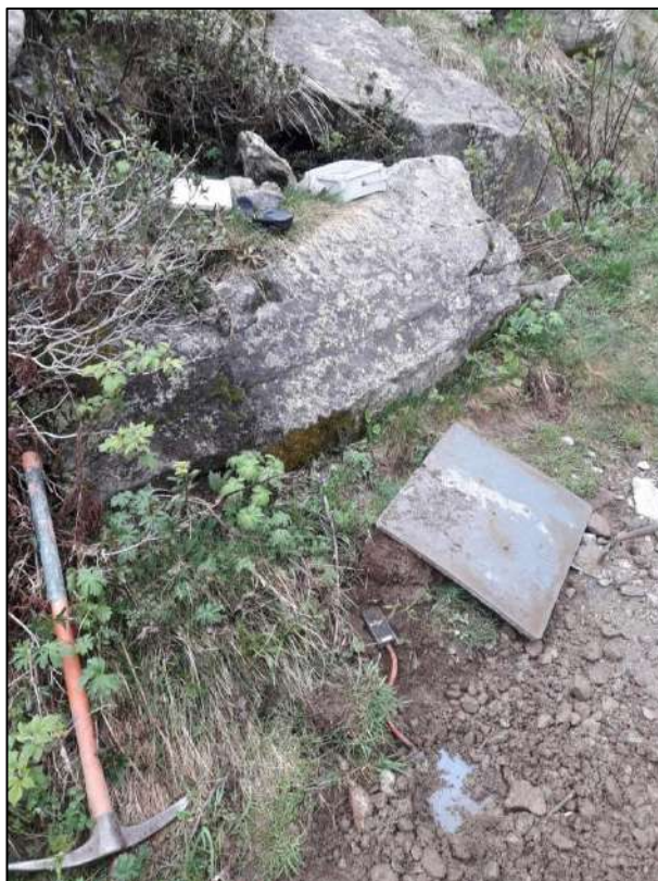
Imatge 12. Instal·lació d'un comptador.
