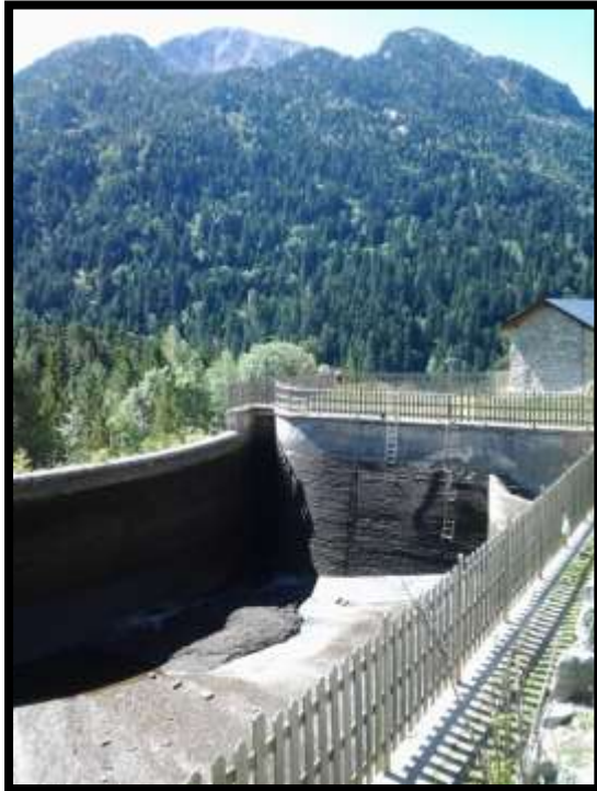
Foto 18: Vaciado de la presa de Sant Esperit 127,25 kg en el Parque Nacional estricto y 21,85 kg en la zona periférica.
