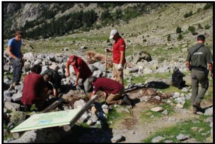
Foto 19: Colocación señal en Riumalo
