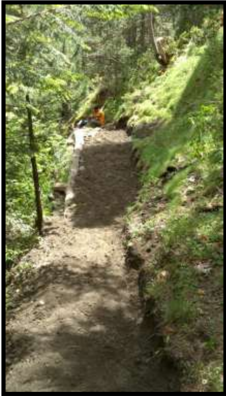
Foto 46: Trabajos de consolidación en el camino de la Montanyeta
