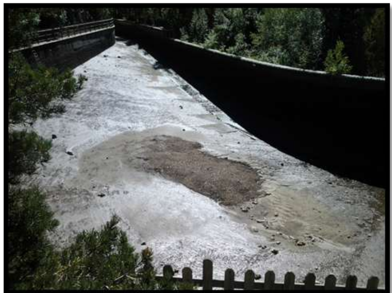
Foto 17: Vaciado de la presa de Sant Esperit
