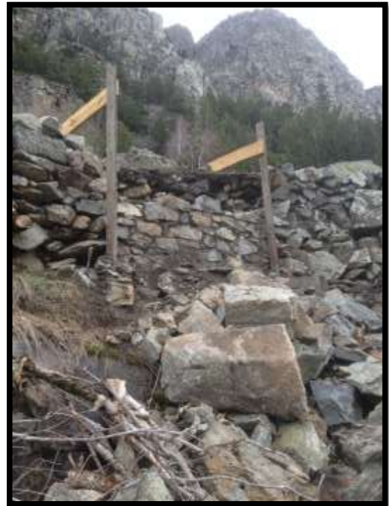
Foto 42: Reparación muro carretera Aigüestortes
