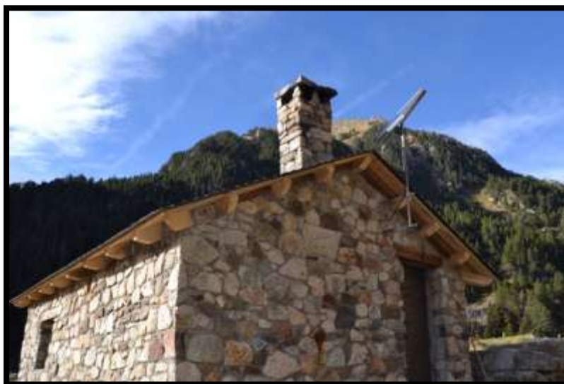
Foto 47: Tejado de la cabaña de la Muntañeta
