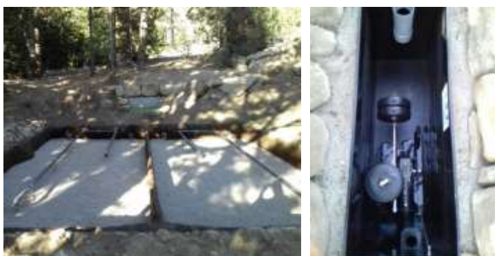
Imatge 15: Cambra sífó de polsos i sistema de drenatge amb diferents granulometries i dues cel·les alternants. (Arxiu fotogràfic del Parc)
