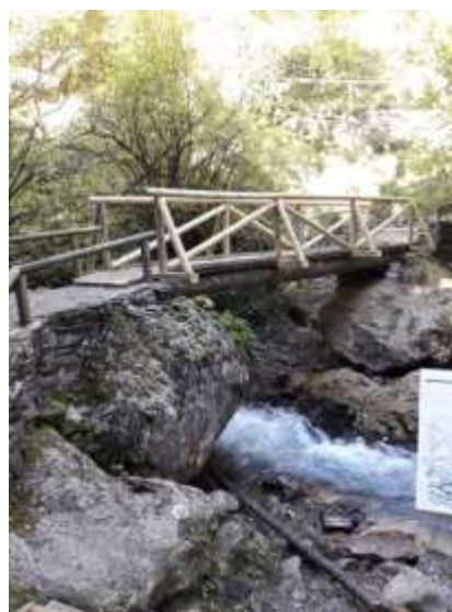
Imatge 18: Substitució del pont de la Gorga. Espot. (Arxiu fotogràfic del Parc)
