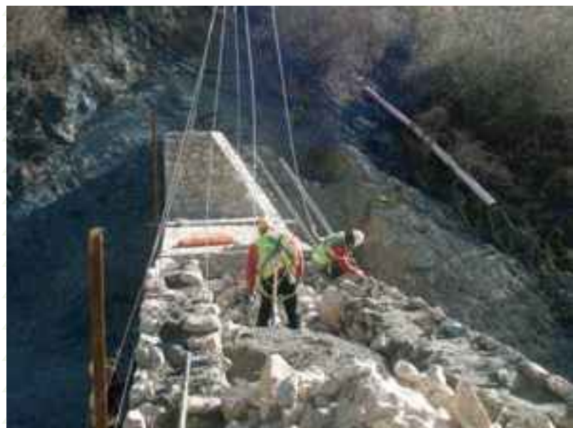
Ejecución de dique en Trevélez
