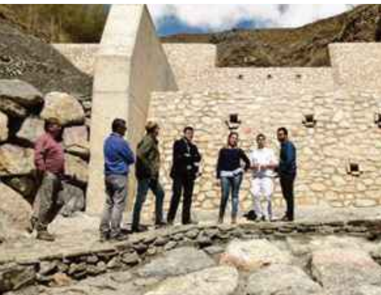
Dique para estabilización de cauces ejecutado en Trevélez
