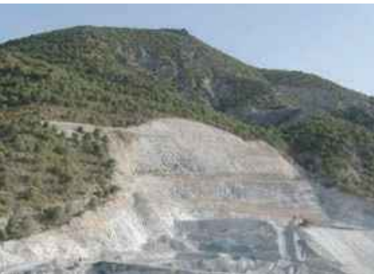
Restauración y revegetación de bancales en la zona noroeste de la cantera.
