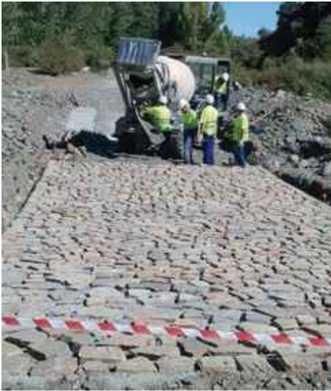
Construcción de badén de piedra.
