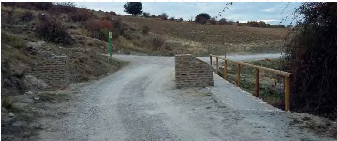
Ejemplo de muros de mampostería en el control de acceso del cortijo Sevilla
