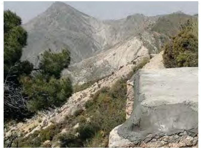
Obras para cegar parte del Canal de la Espartera
