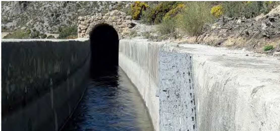
Rampa diseñada para la salida de animales en el Canal de la Espartera
