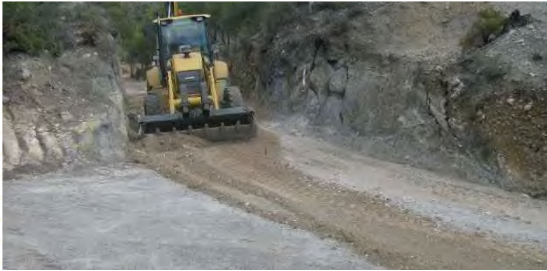
Obras de arreglo de la pista forestal
