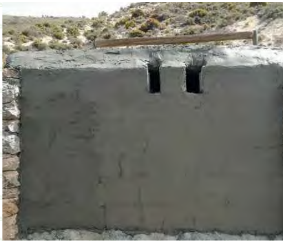
Las obras de cerramiento del canal de la Espartera permiten la salida de murciélagos
