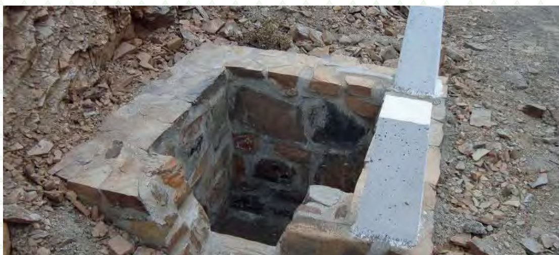
Obras de mantenimiento y modernización de los caminos forestales de Sierra Nevada en el ámbito del Proyecto REDVIA
