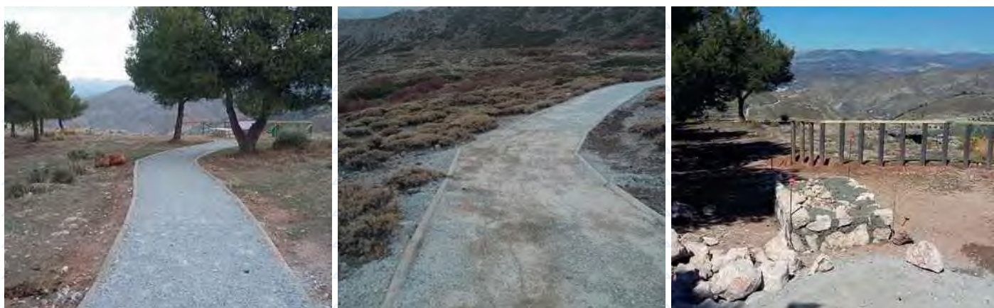
Mejoras de accesibilidad a ambos miradores y detalle de muro en el mirador de Huenes
