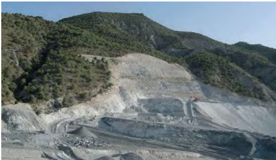
Restauración de bermas y taludes Cantera San Sebastián
