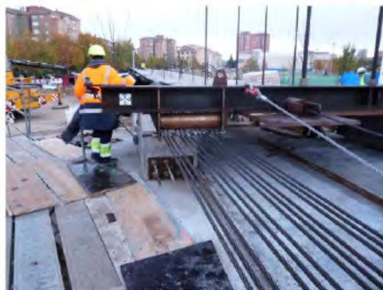
**Fig. 10.** Montaje sistema de arrastre
