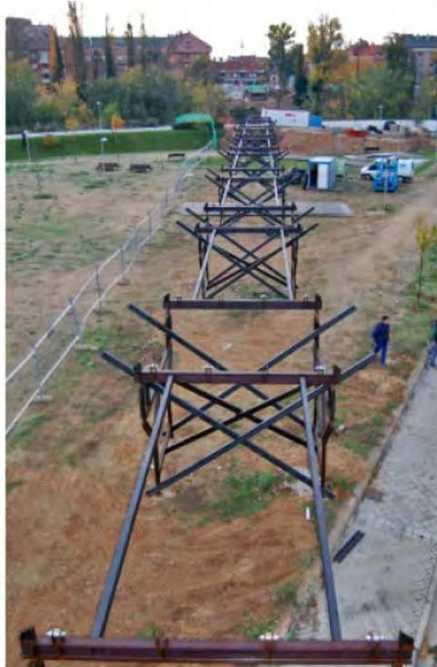
**Fig. 4.** Bancada de ensamblaje de banda tesa mediante cimbras
