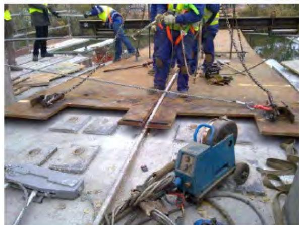
**Fig. 12.** Encaje pletina en las cosillas de fijación
