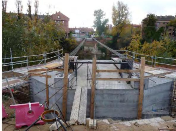
**Fig. 9.** Cables auxiliares de arrastre
