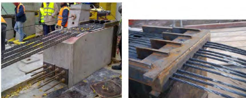
**Fig. 7.** Ménsula para fijación de anclajes del cable auxiliar de soporte
