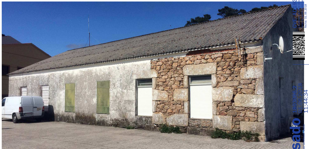
Foto 3 y 4.- Interior y exterior de las ventanas del aula.
