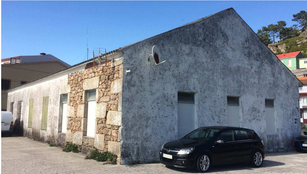
Foto 1 Fachadas Sur y Oeste.
