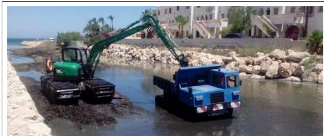
*-Máquina excavadora anfibia EIK AM-80 y Dumper de cadenas, para las labores de limpieza,*
