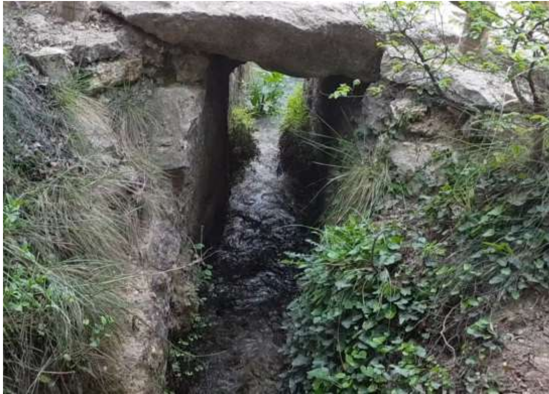
Vista del canal que une el manantial al cauce del río Vinalopó
