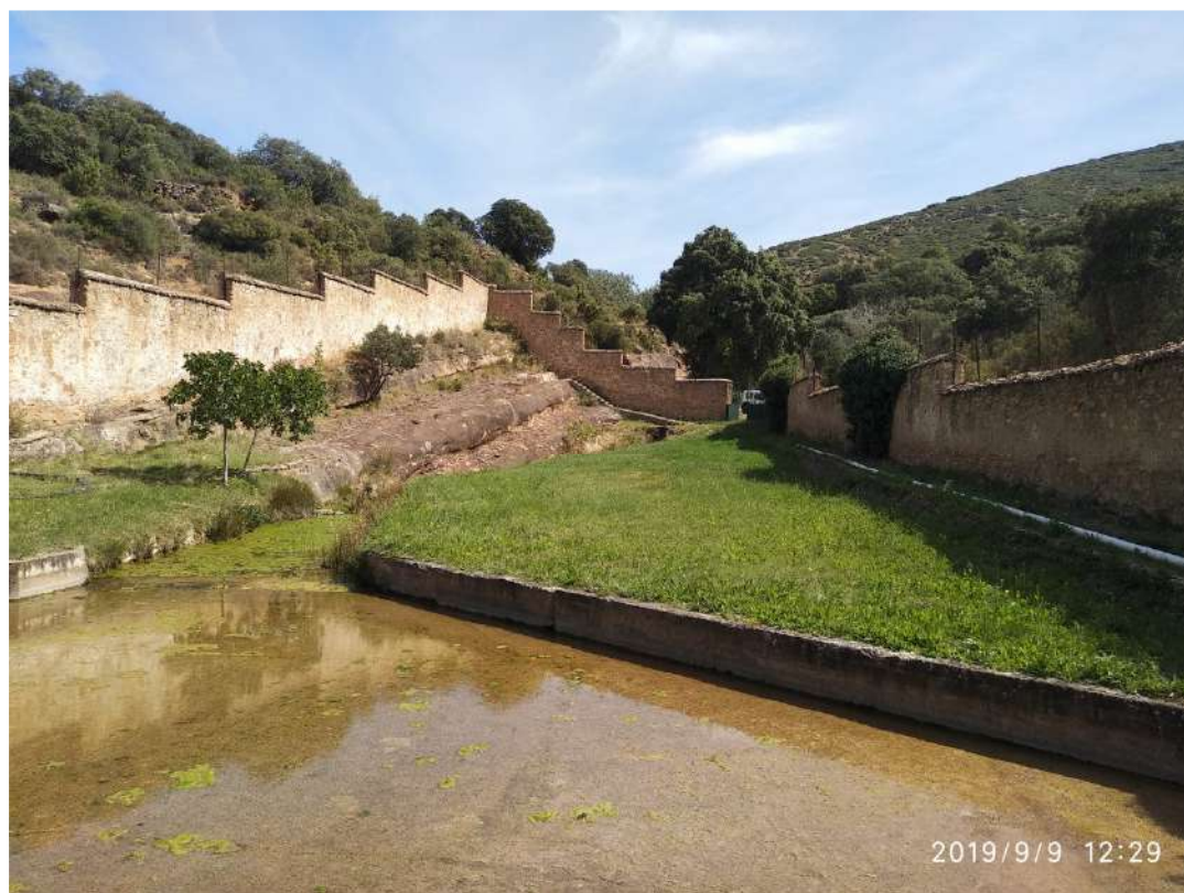
Interior del recinto de protección
