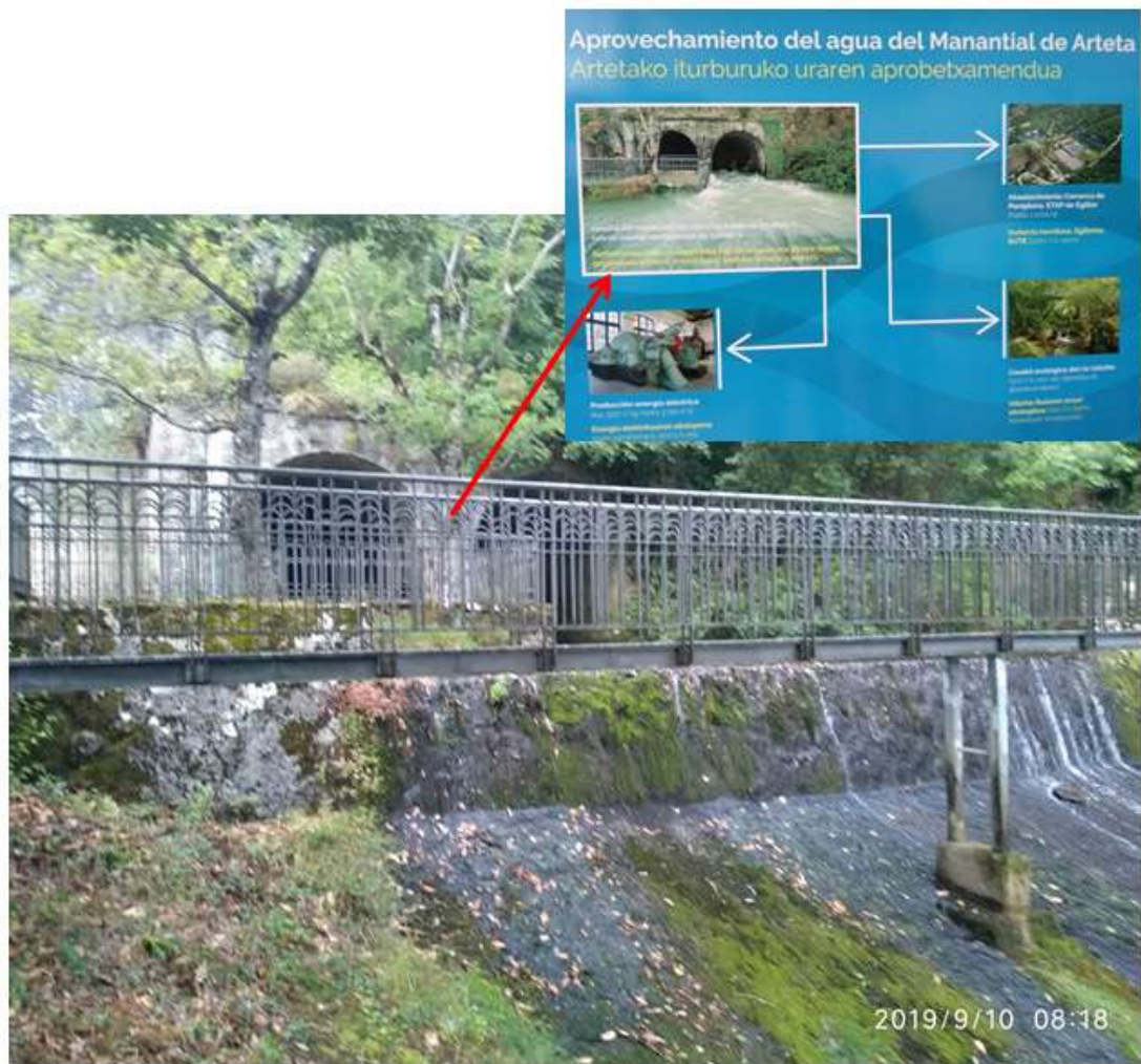
Azud para derivación a abastecimiento
