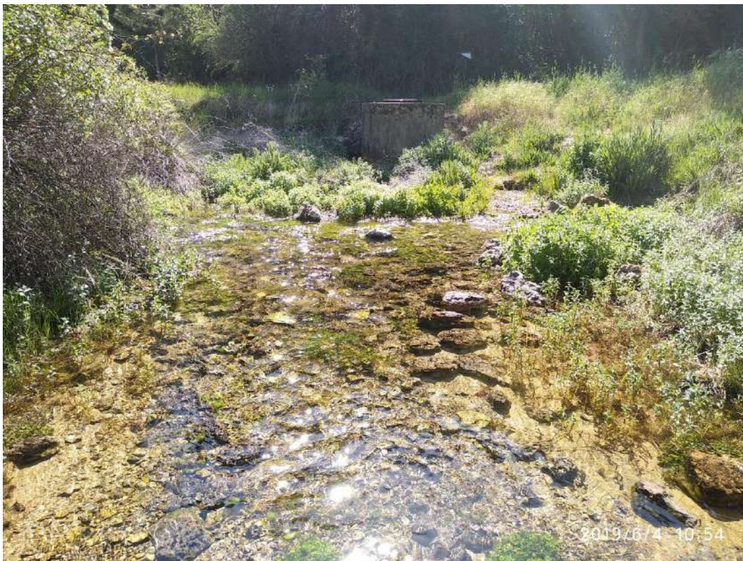
Vista aguas abajo de la arqueta donde rebosa la surgencia
