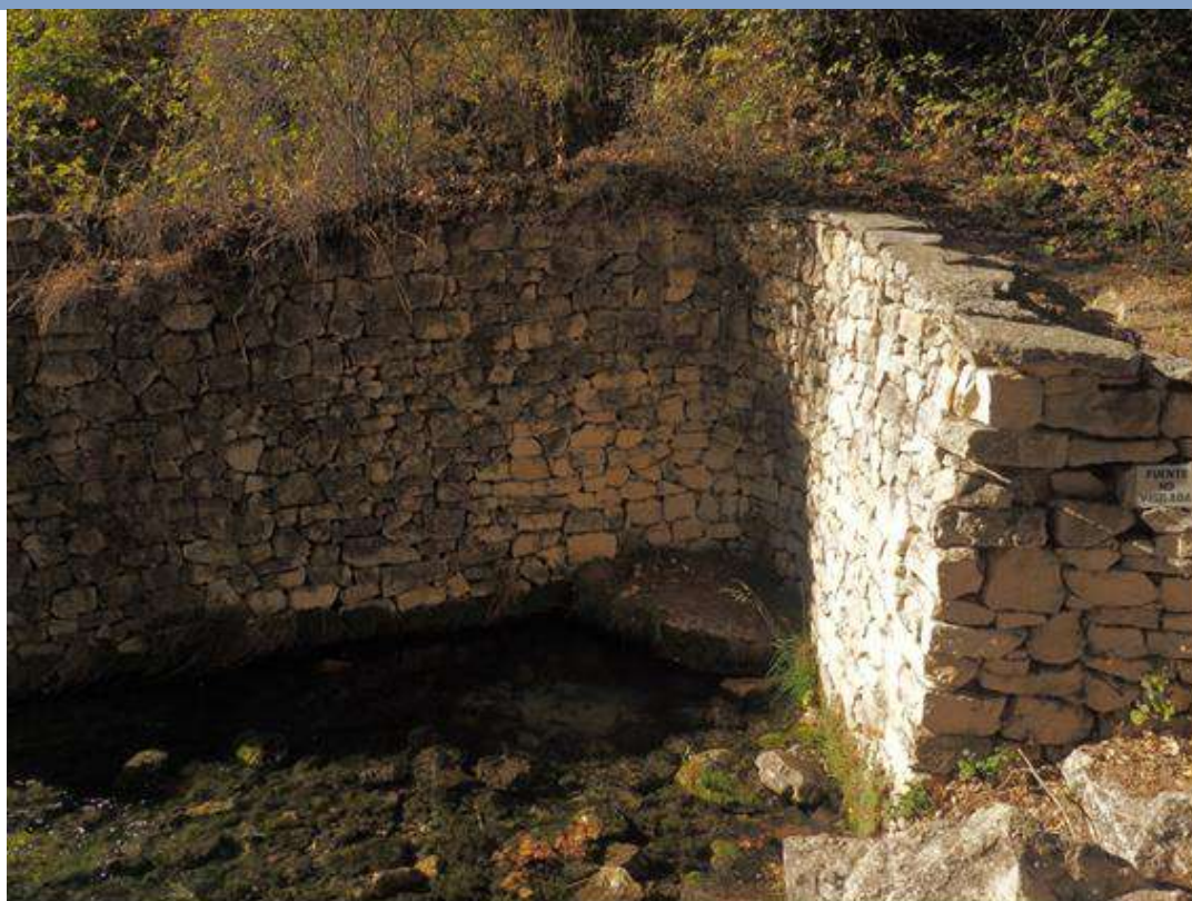
Principal punto de descarga de la RNS
