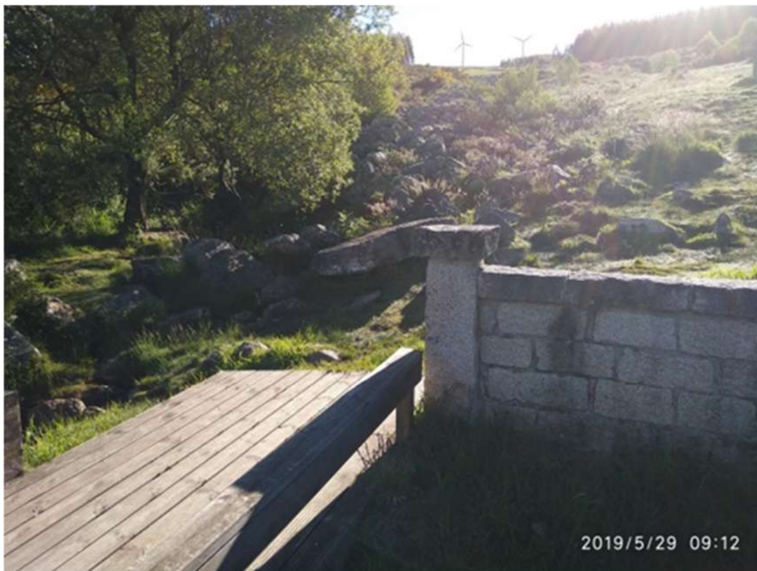
Vista del final del canchal encajado donde ya se puede ver discurrir el agua.
