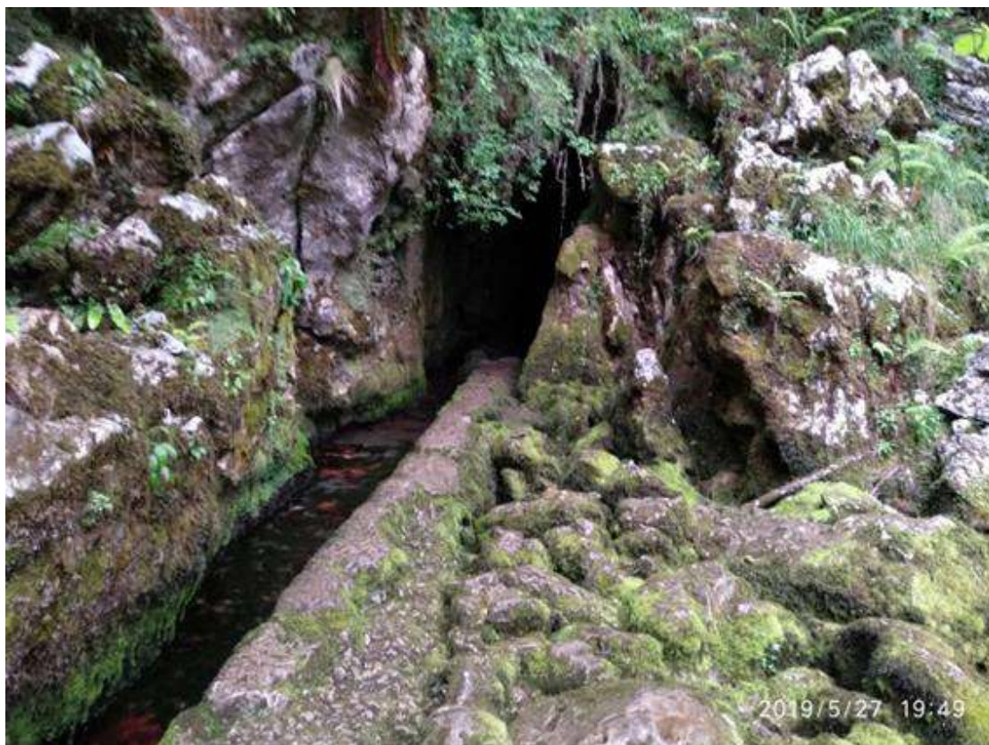
Galería que sirve de dren de las aguas subterráneas que originan el río Cabra.
