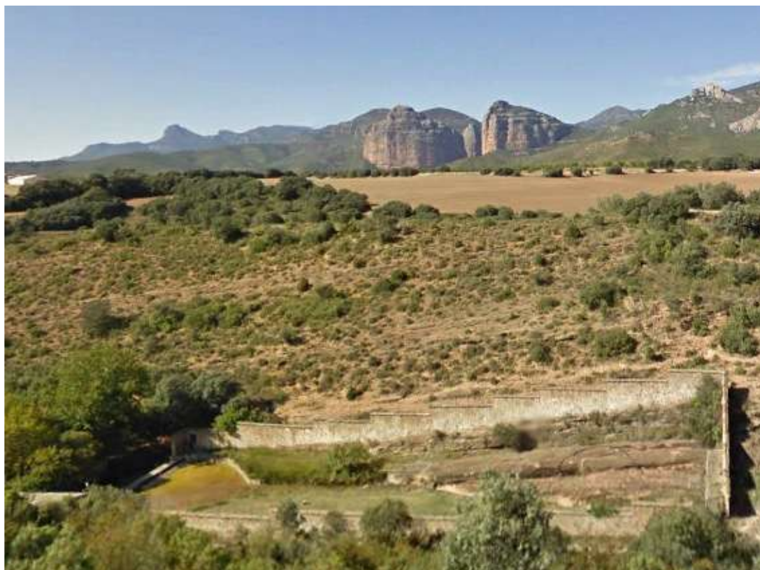
Recinto del principal punto de descarga de la nueva RNS
