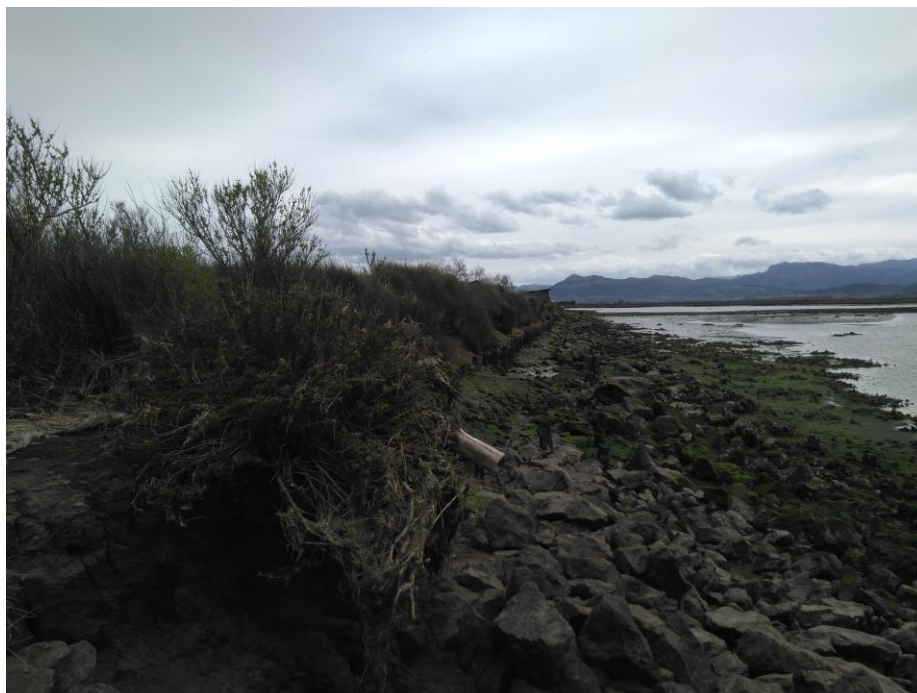
Foto 9. Perspectiva inferior del trazado que sigue el dique de contención, con irregularidades provocadas por la erosión de la dinámica mareal.
