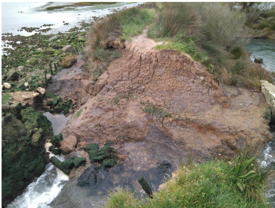
Foto 6. Detalle de flujo de agua a través de la rotura total del dique.
