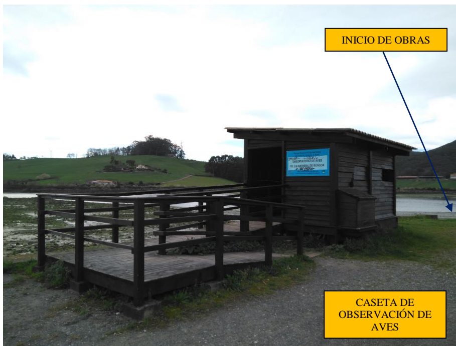
FOTOGRAFÍA 2 Punto de inicio de ejecución de obras, con muro de gaviones y mejora de la plataforma.
