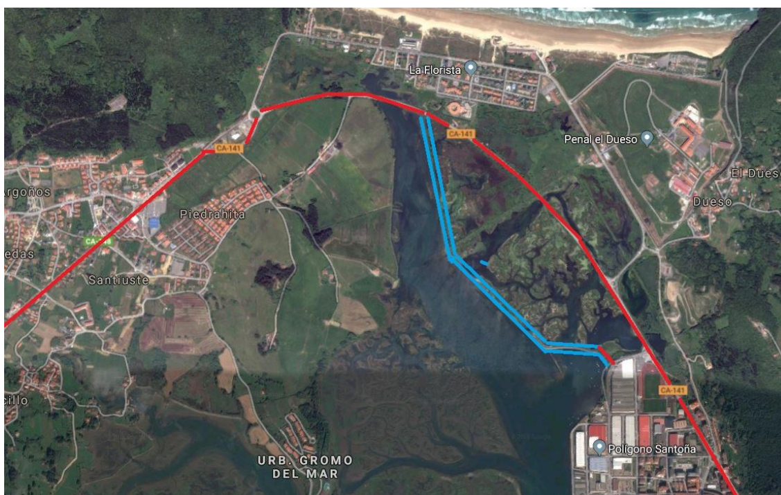
- Fotografía 1 - Vista general del trazado que discurre sobre el dique de Bengoa y su conexión con Santoña y con la CA-141".
