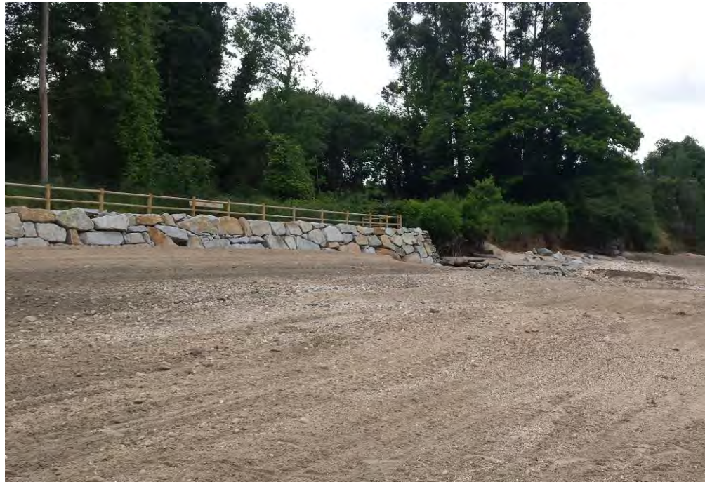
Fotografía nº 9: Actuaciones protección zona Este
