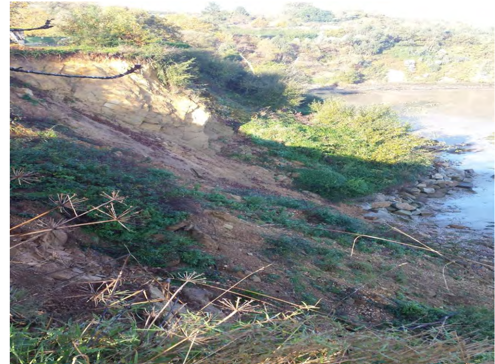
Fotografía nº 3: Desprendimientos en taludes de la zona oeste de la playa do Regueiro
