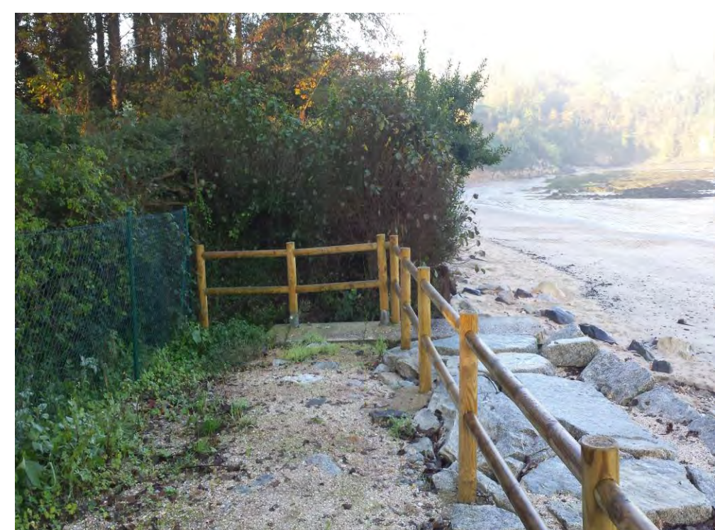
Fotografía nº 18: Vista de la zona Oeste de la playa, desde actuaciones de protección ya ejecutadas
