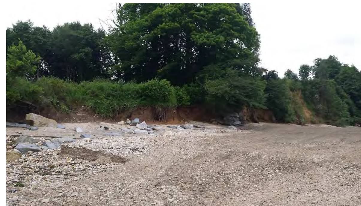
Fotos 1 y 2.- Erosión de la costa.
