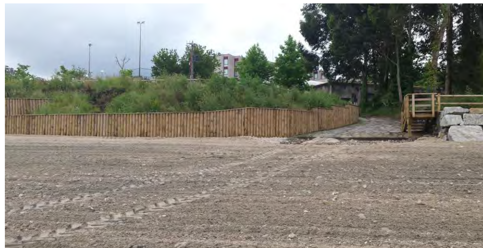
Fotografía nº 6: Actuaciones de protección zona Este de la playa do Regueiro
