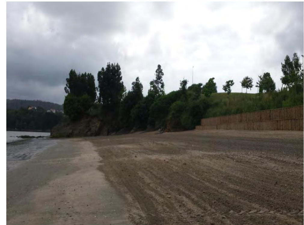
Fotografía nº 4: Actuaciones de protección zona Este de la playa do Regueiro
