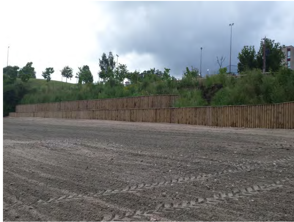
Fotografía nº 5: Actuaciones de protección zona Este de la playa do Regueiro
