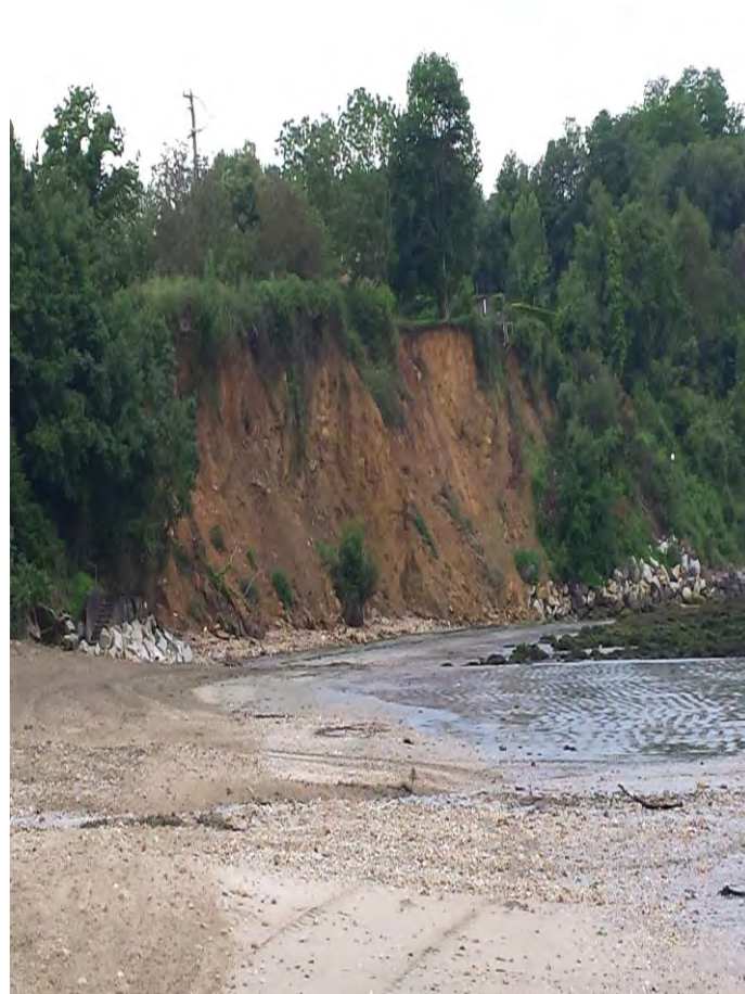
Fotografía nº 12: Taludes zona Oeste de la playa do Regueiro
