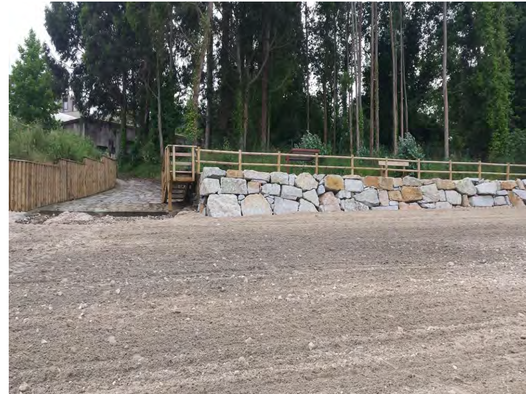
Fotografía nº 7: Actuaciones protección zona Este
