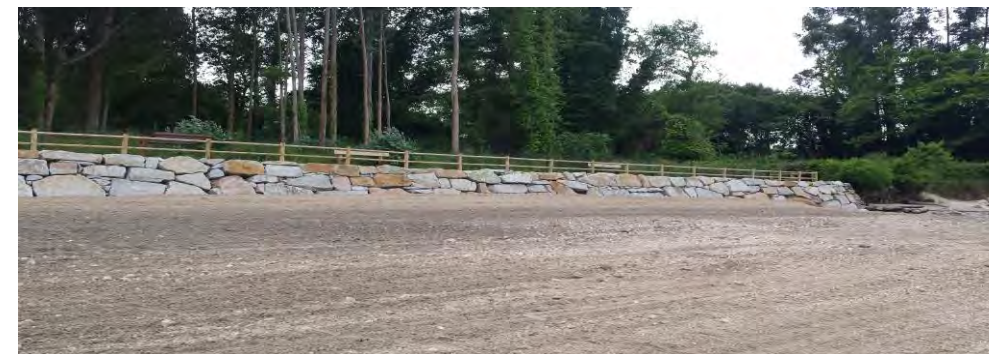
Fotografía nº 8: Actuaciones protección zona Este
