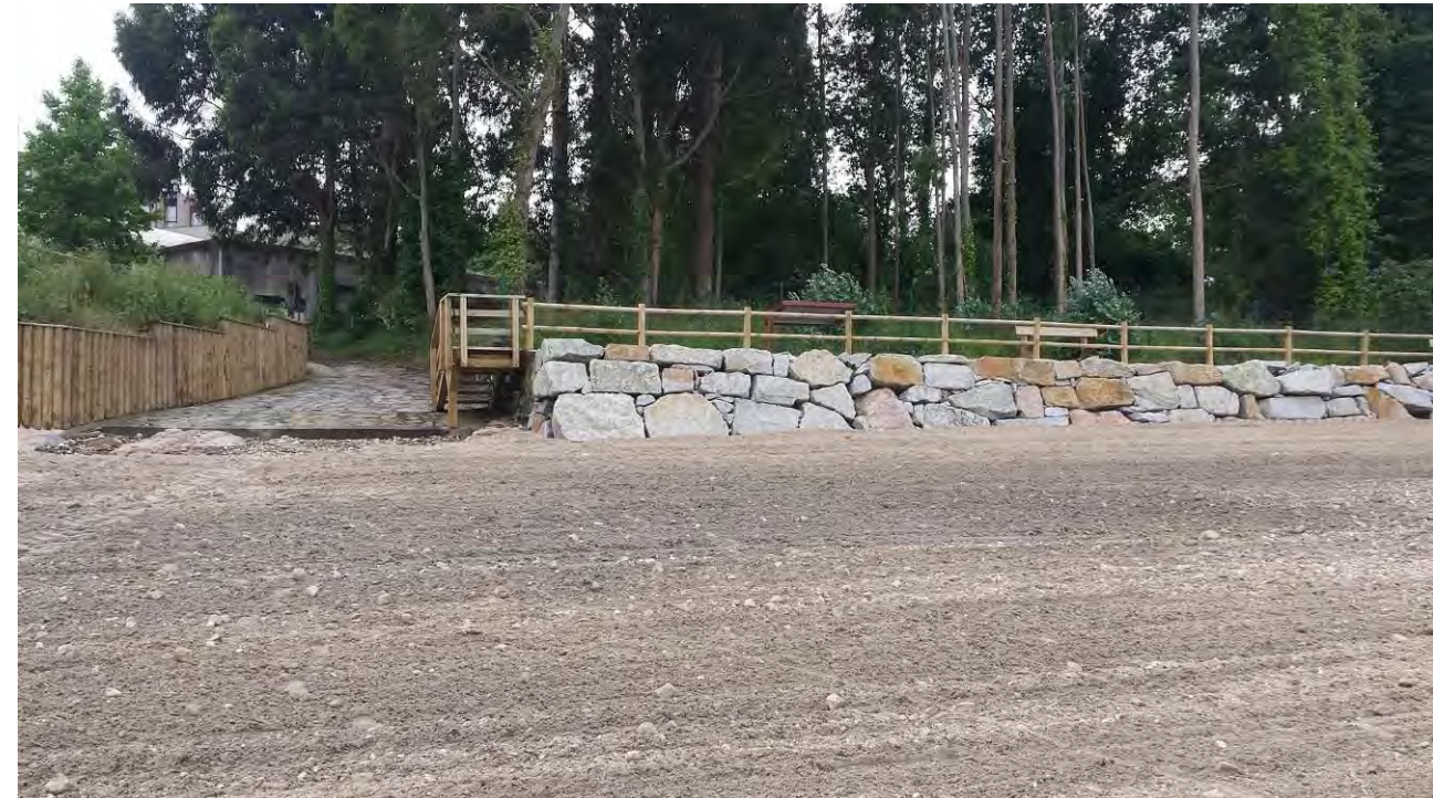
Fotos 2 y 3.- Actuaciones protección zona Este.
