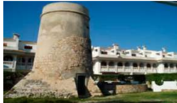
Figura 67. Torre de La Almadraba.
