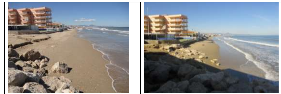
Figura 4. Último tramo de la playa de Les Deveses. Antes y después de un temporal.
