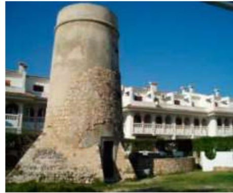
Figura 2. Torre de La Almadraba.
