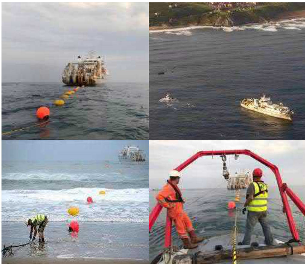
Figura 3.2-5: Ejemplo de las operaciones de acarreo en aguas someras (Fuente: Proyecto Marea, SubCom, 2017).
