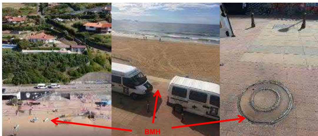
Figura 3.2-13: Vistas de la arqueta (BMH) en el paseo marítimo de la playa de Sopela (Fuente: SubCom, 2020).
