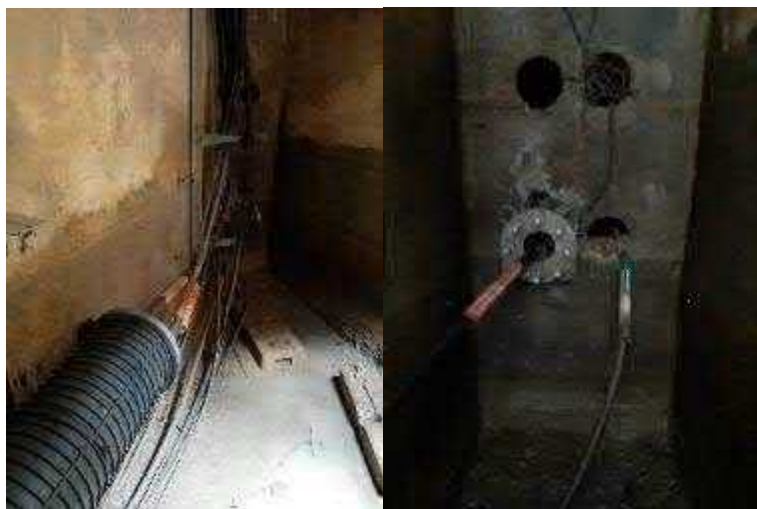
Figura 3.2-14: Vistas del interior de la arqueta (BMH) en el paseo marítimo de la playa de Sopela (Fuente: SubCom, 2020).
