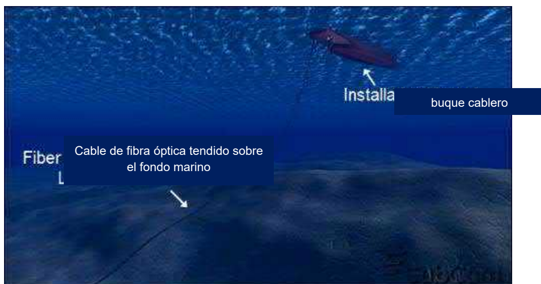
Figura 3.2-8: Vista general de las operaciones de tendido (Fuente: SubCom, 2020).
