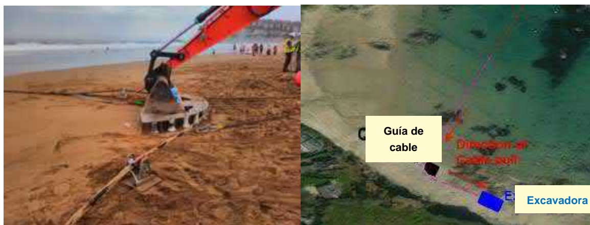
Figura 3.2-17: Imagen de la operación de tiro del cable desde la playa mediante una guía (izqda.) y esquema de tracción o tiro de cable (Fuente: SubCom, 2020)
