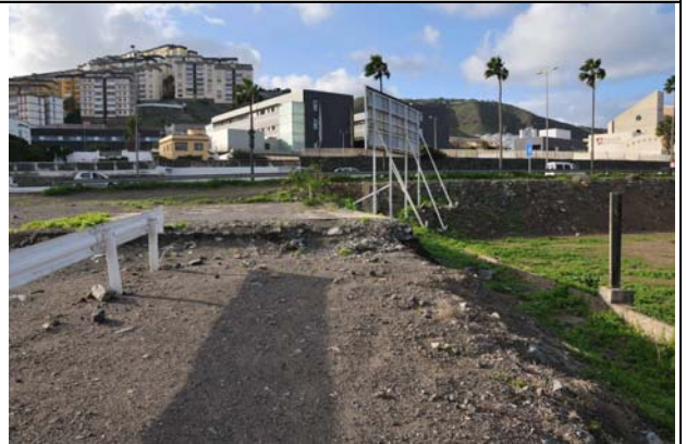
Restos de edificaciones demolidas
