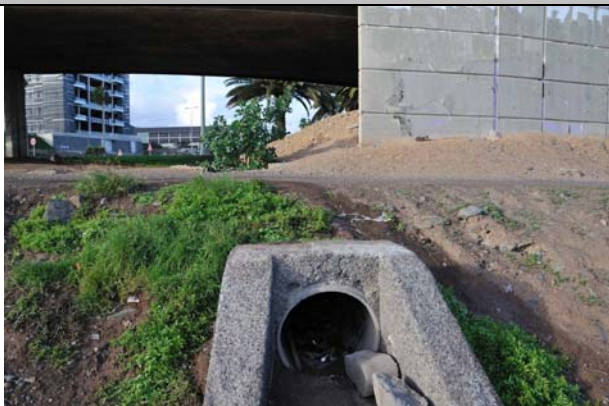
Obra de drenaje existente
