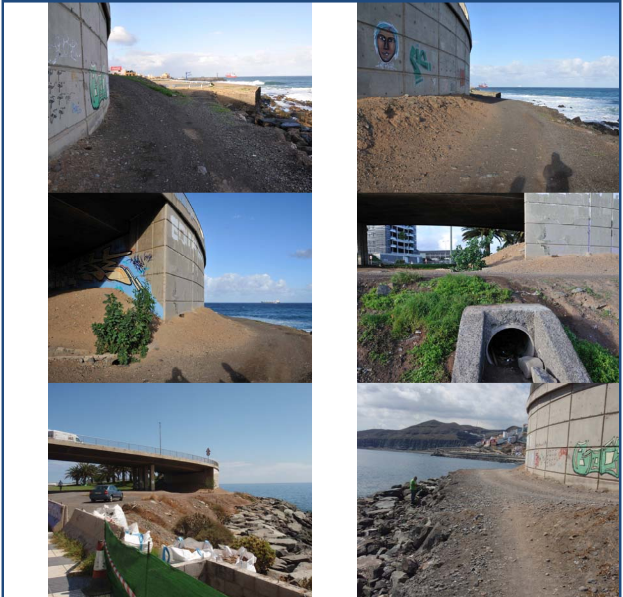
Zona de escollera de protección y camino de tierra inalterado sin afección del oleaje. Enlace Hoya de La Plata. Cota actual +7,00.
