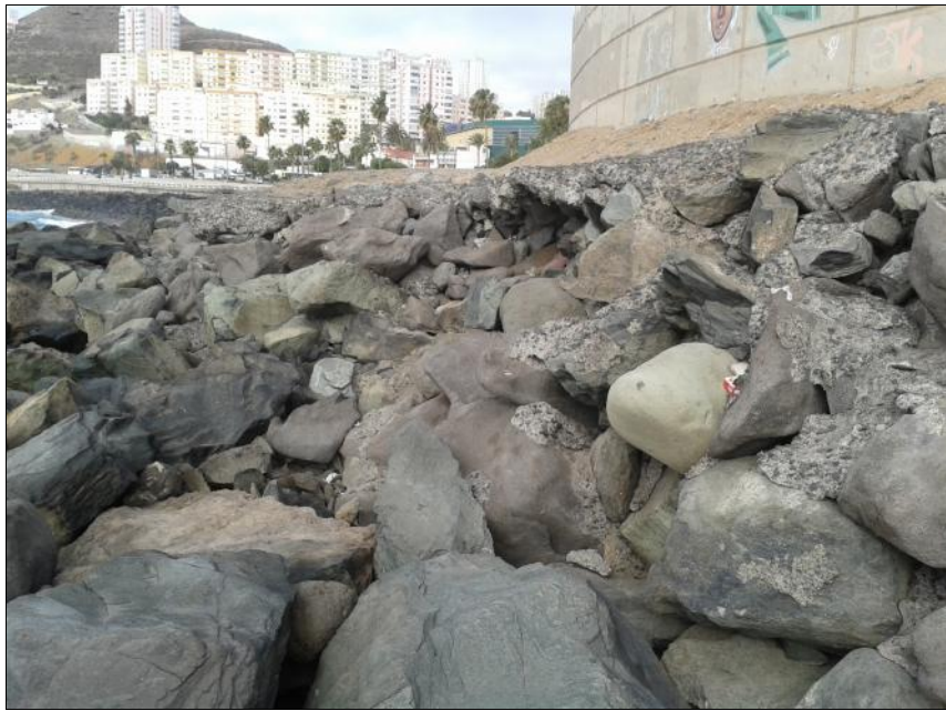
Ilustración 3. Detalle del Pedraplén a modo de Escollera
