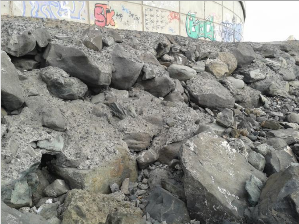
Fotografía 16: Afloramiento 2. Escollera con capa de hormigón superficial.
