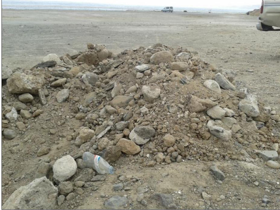
Fotografía 7: Material extraído calicata 2
