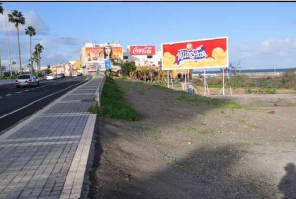
Acera y protección metálica existente junto a Avenida Marítima
