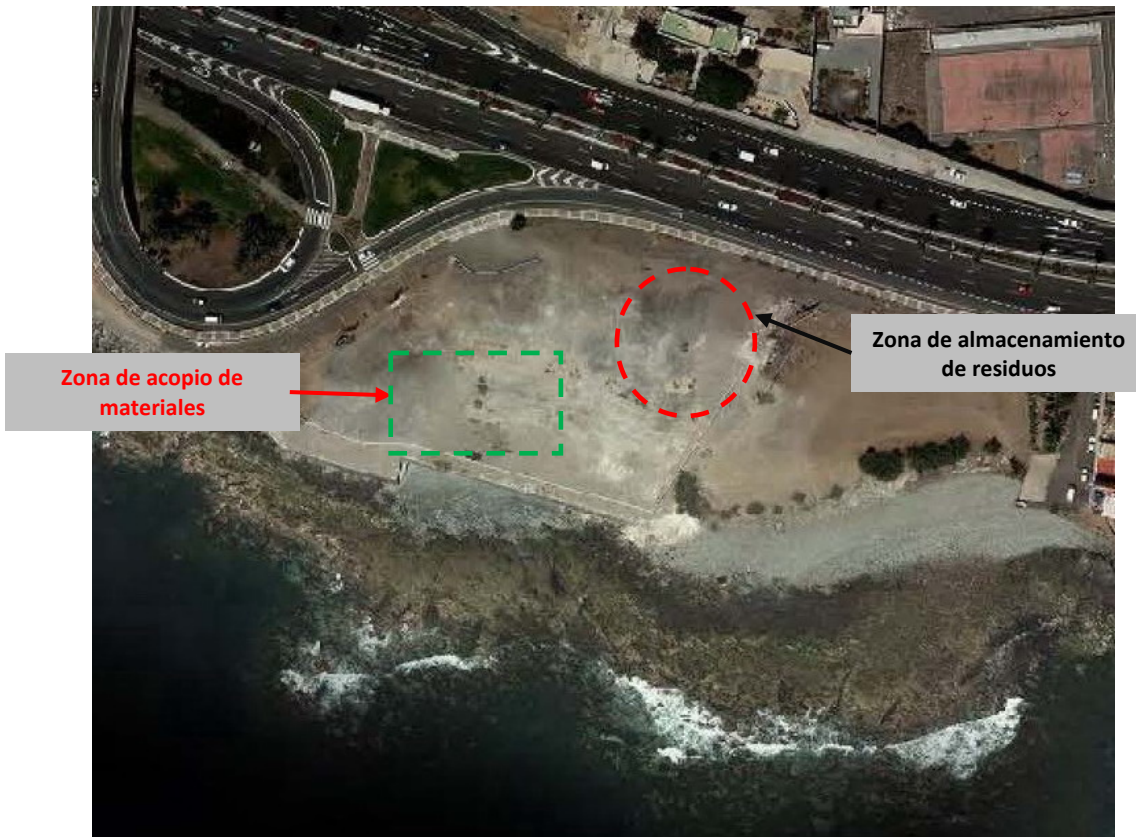
Figura 2. Zona de almacenamiento de residuos.
