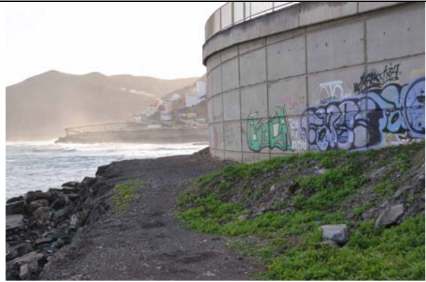
Protección con escollera del Enlace Hoya de La Plata
