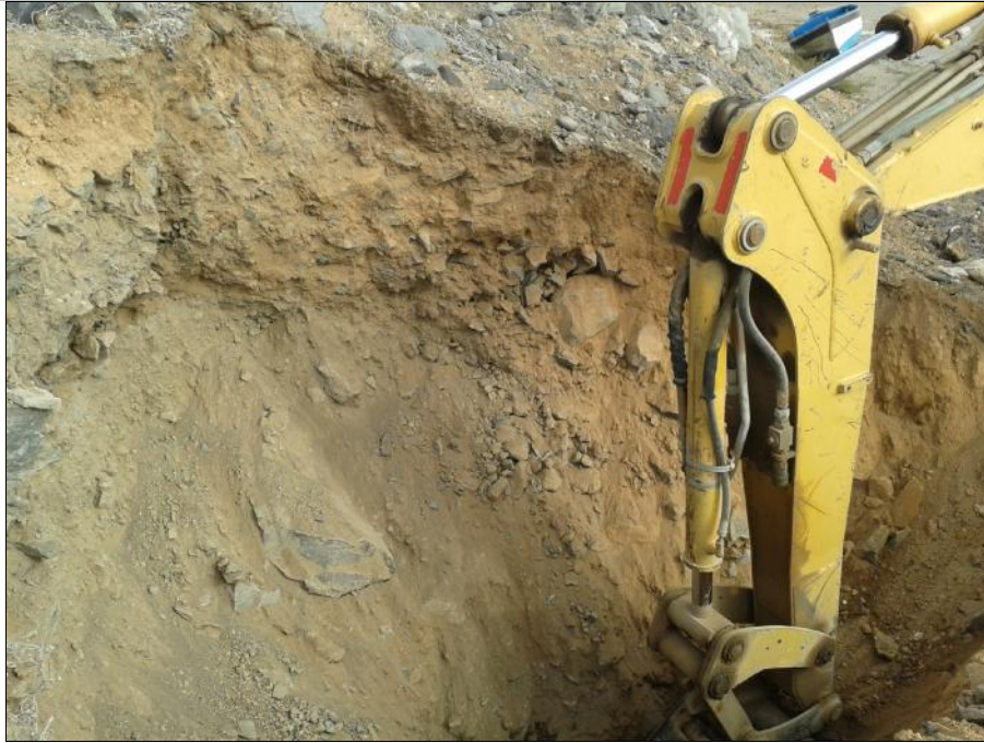
Fotografía 9: Calicata 3. Detalle del nivel de rellenos
