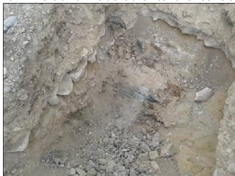
Fotografía 1: Talud formado durante la excavación
