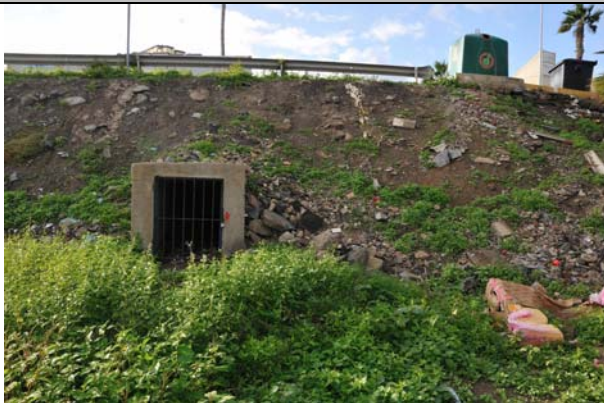
Boquilla canal de drenaje existente
