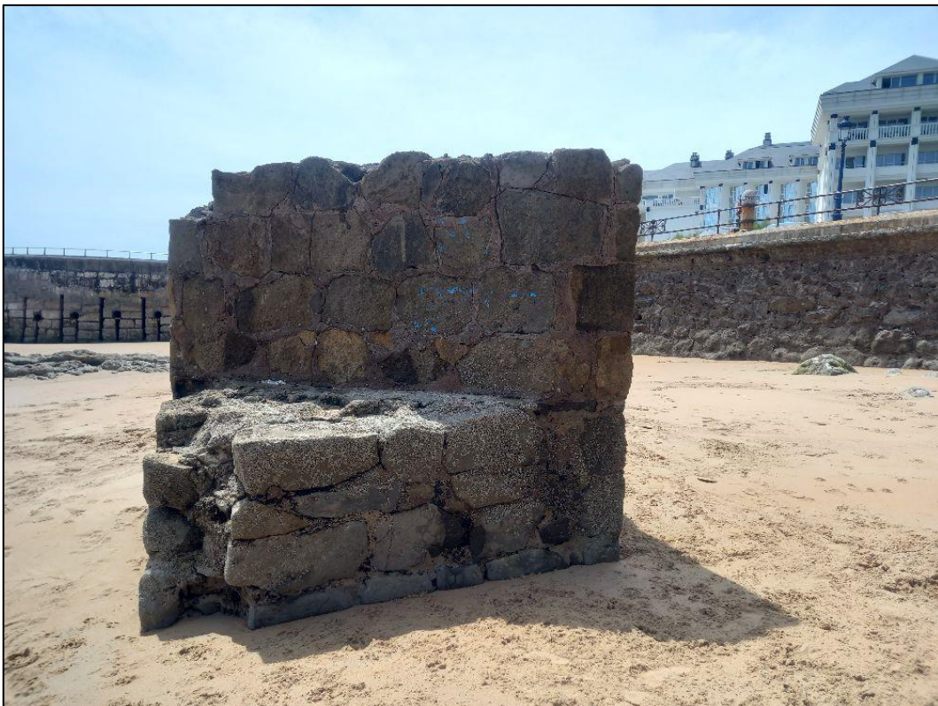
Ilustración 34. Estructuras de defensa de la playa de El Chiqui.
