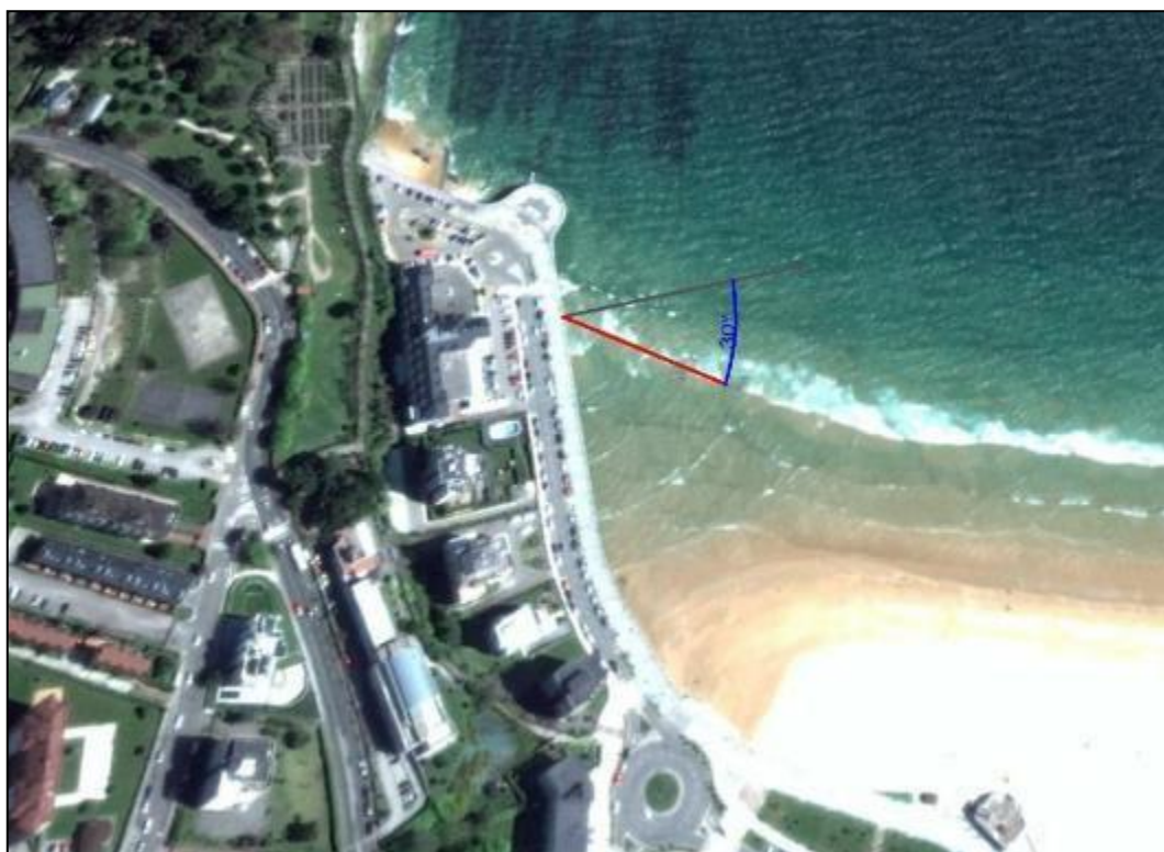
Ilustración 3. Incidencia el oleaje en el muro.
