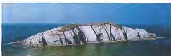
Isla del Castro, mostrando el acantilado dominado por los deslizamientos.
