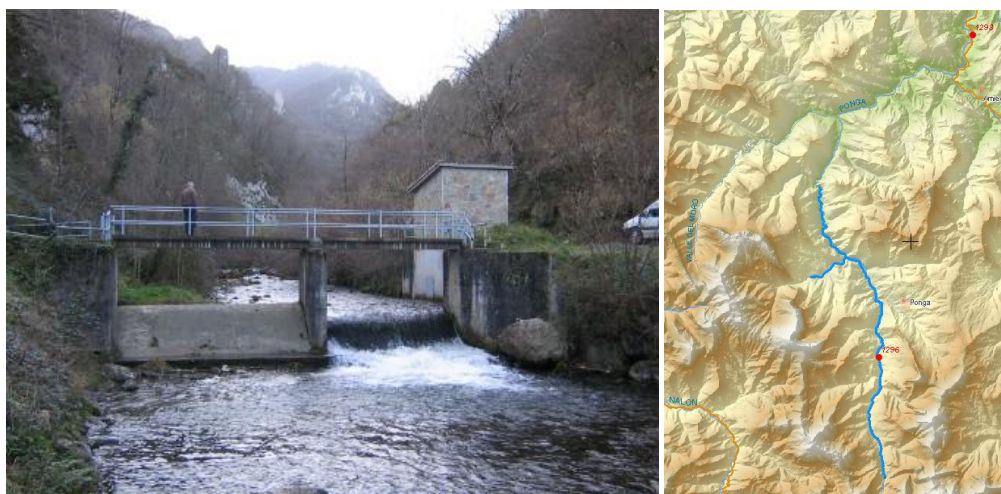
Imagen 5: Estación de aforos 1296 del Río Ponga en Sobrefoz (Asturias), con datos desde 1994, situada en la reserva natural fluvial de la Cabecera del Ponga, permite el análisis de las aportaciones en régimen natural y su variabilidad temporal, siendo un punto de seguimiento de los efectos del cambio climático en los recursos hídricos.
