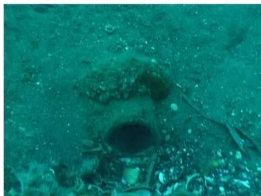
Salida en talud del emisario de emergencia
