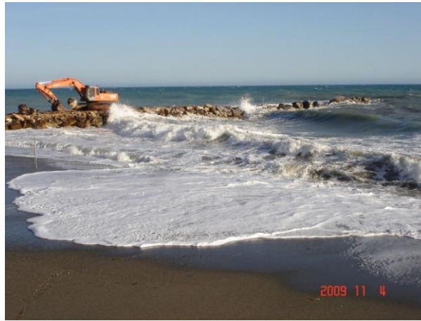
Ilustración 6 Foto de la construcción del espigón en La Mamola. Fuente: MITECO
