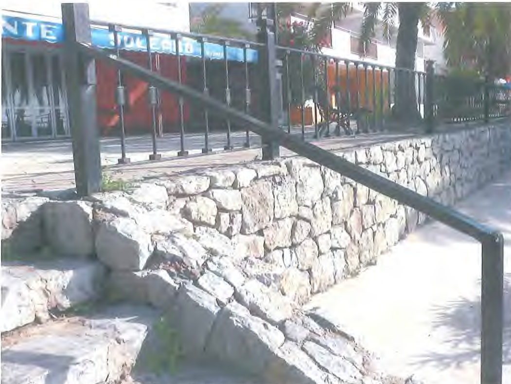
MURO DE CONTENCIÓN DE TIERRAS DEL PASEO DE SES PITIÜSES
