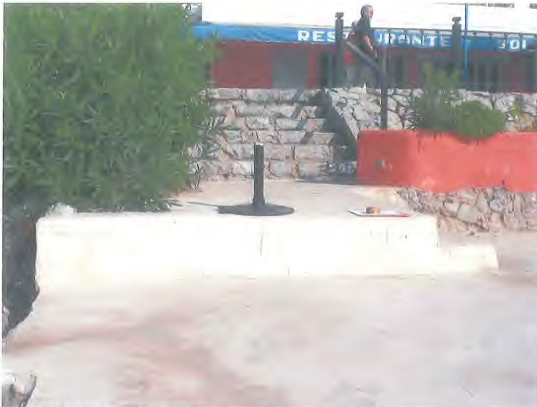
ACCESO A LAS PLATAFORMAS
