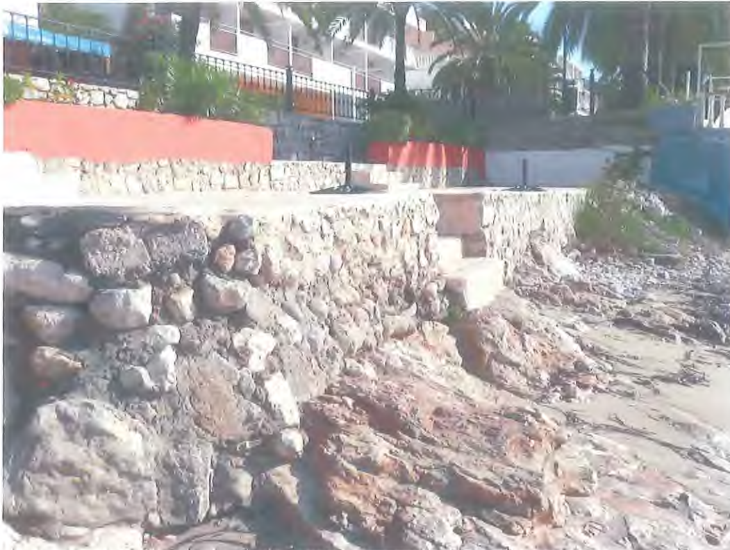
MURO DE CONTENCIÓN DE TIERRAS EN LA PLATAFORMA INFERIOR
